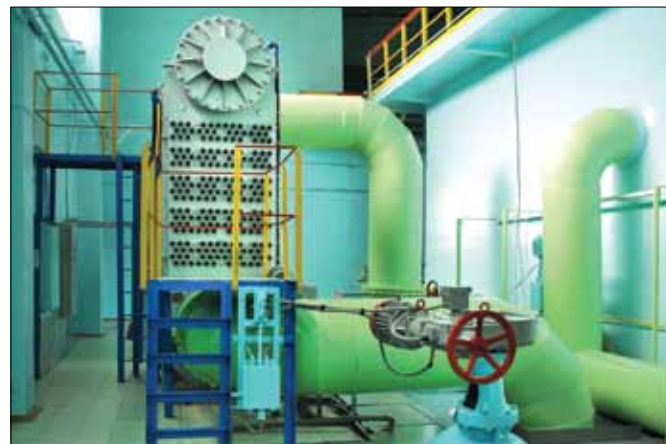
Станция ультрафиолетового обеззараживания воды на водоочистных сооружениях города Ангарска
