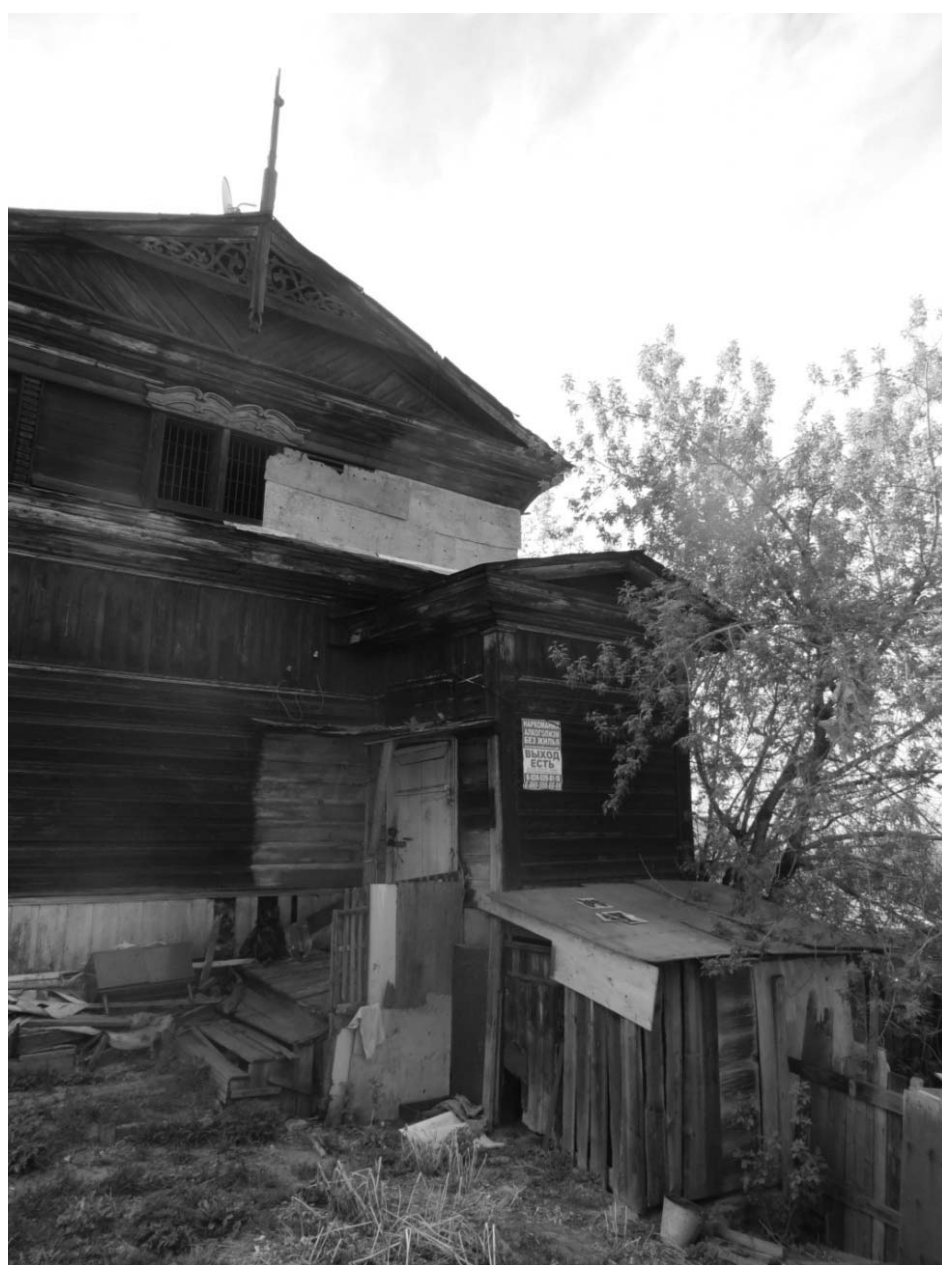
Фото 15 - Вид на пристрой сеной юго-восточного фасада с юга
