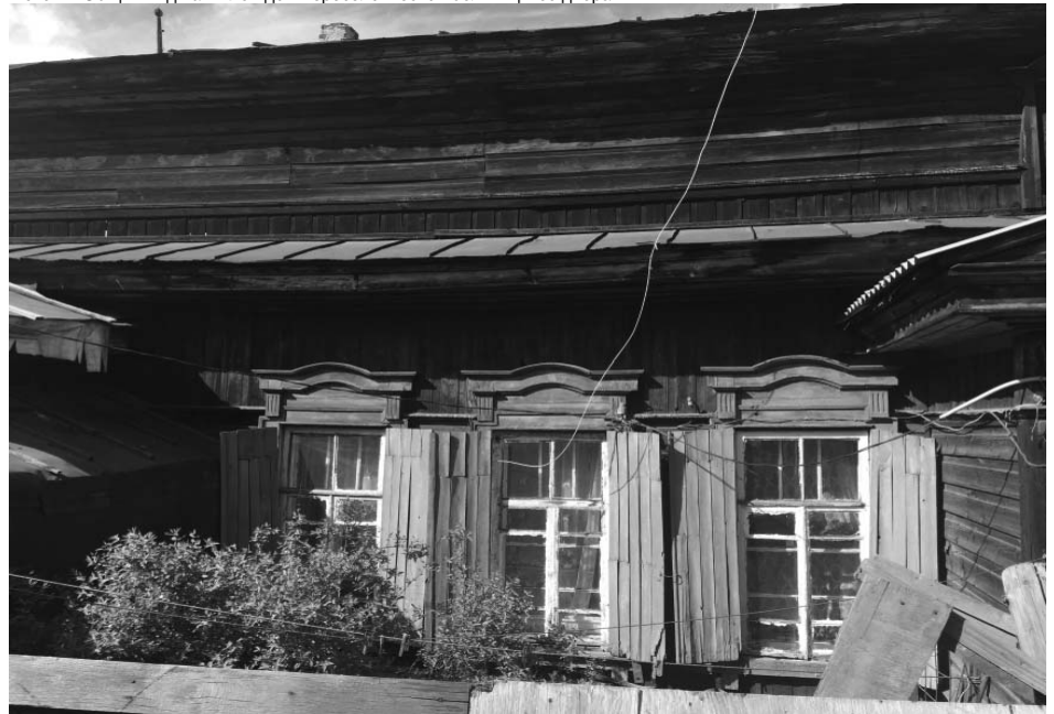
Фото 2 - Три центральных оконных проема со стороны юго-западного фасада
