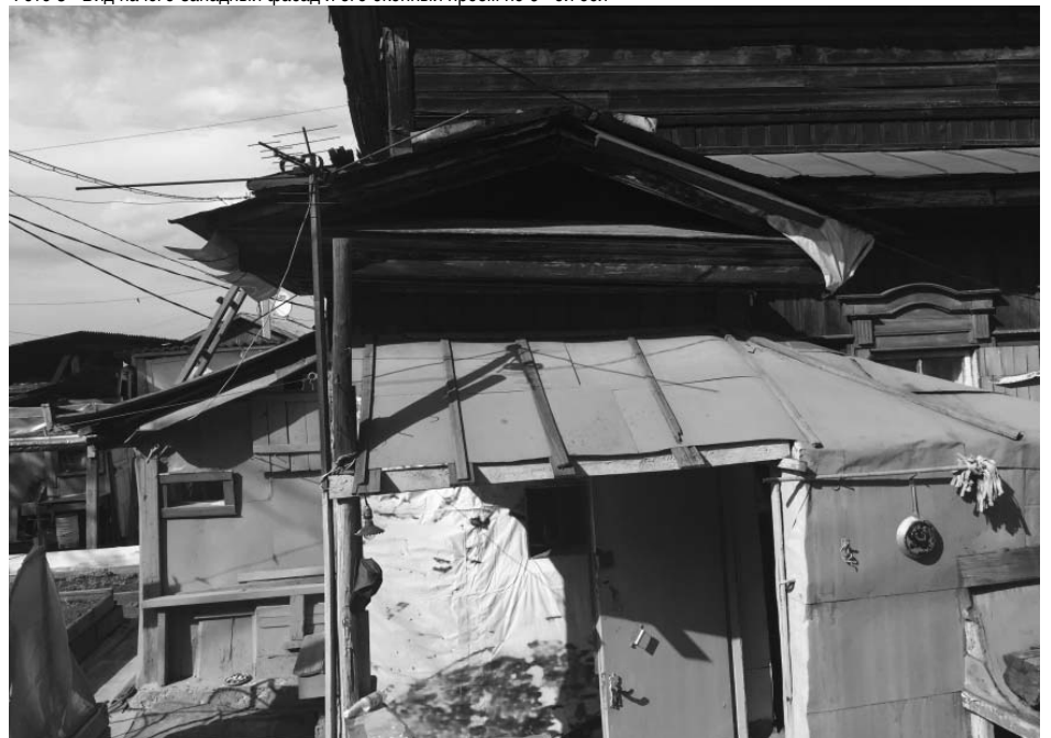
Фото 4 - Пристрой сеной юго-западного фасада, расположенный в западном углу жилого дома
