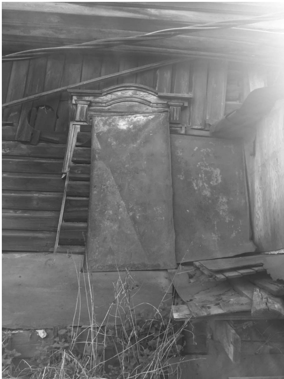
Фото 11 - Оконный проем по 5-ой оси со стороны северо-восточного фасада
