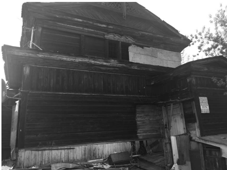
Фото 13 - Вид на юго-восточный фасад
