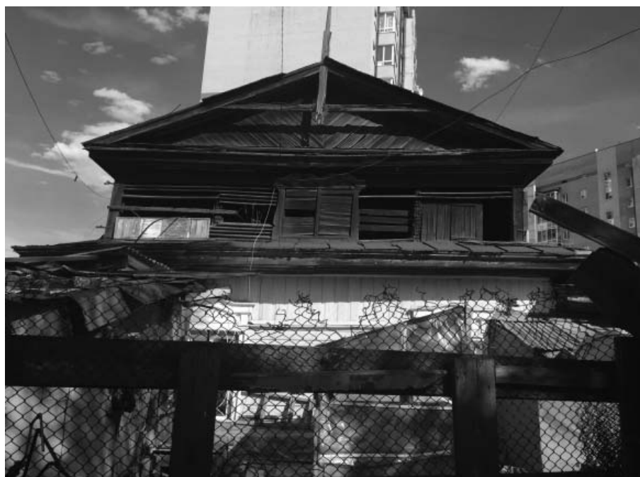
Фото 7 - Вид на северо-западный фасад
