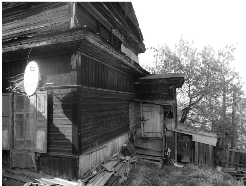
Фото 14 - Пристрой сеной юго-восточного фасада, расположенный в восточном углу жилого дома
