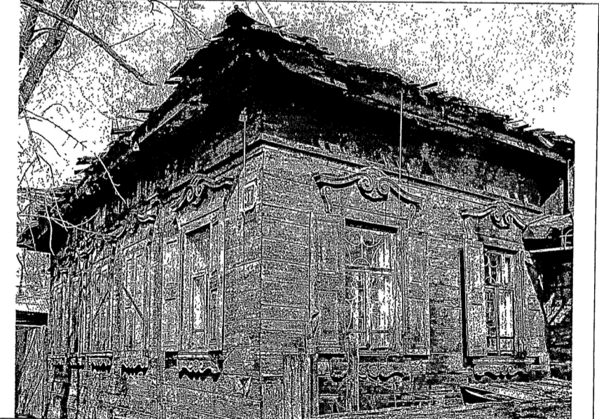
8. Южный угол дома. Вид с ул. К.Либкнехта. Фото 2006 г.
