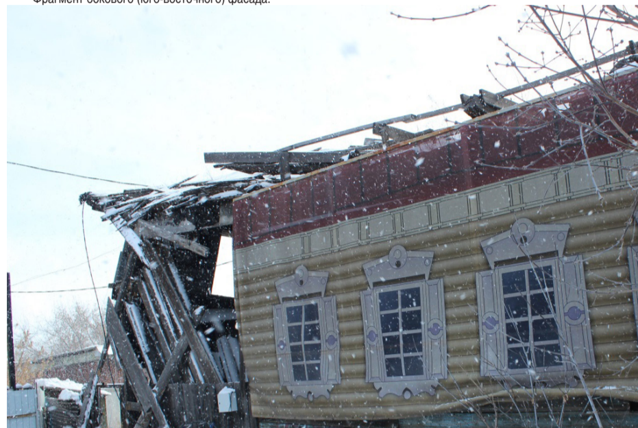
Фото А.А. Жильцов, март 2019 г. Боковой (северо-западный) фасад.
