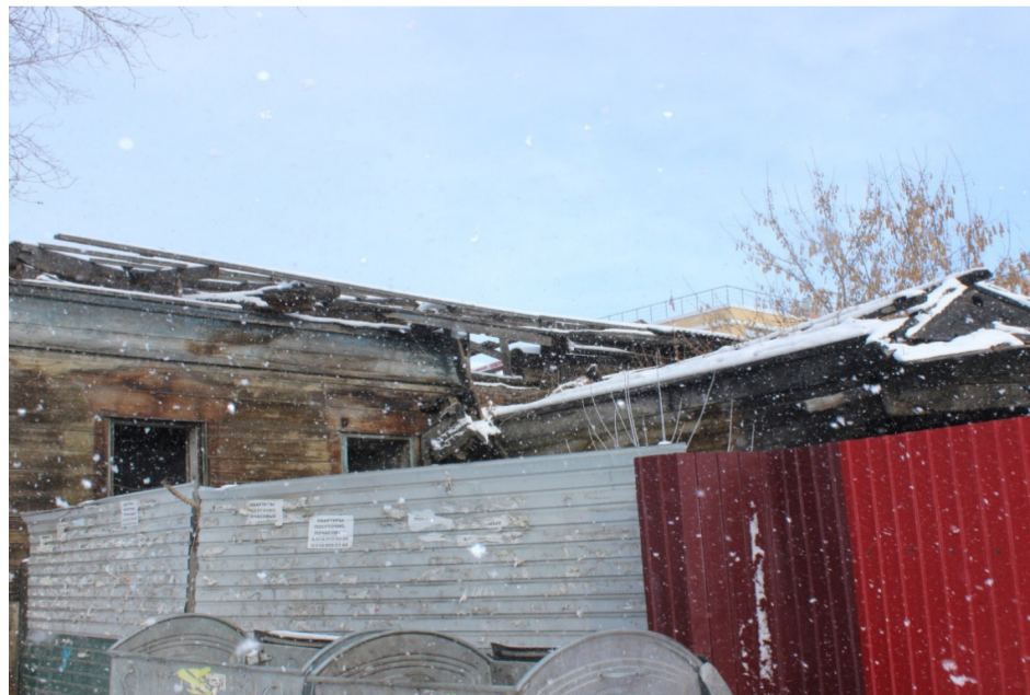
Фото А.А. Жильцов, март 2019 г. Боковой (юго-восточный) фасад.
