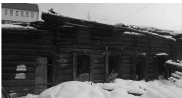
Фото 2 - Главный дом в усадьбе по адресу ул. Володарского, 2, лит. А (федеральный объект) после пожара
