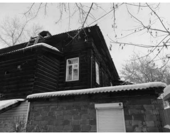
Фото 9 - Угол юго-западного и юго-восточного фасадов
