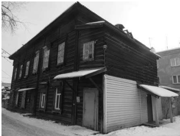
Фото 7 - Угол северо-западного и юго-западного фасада
