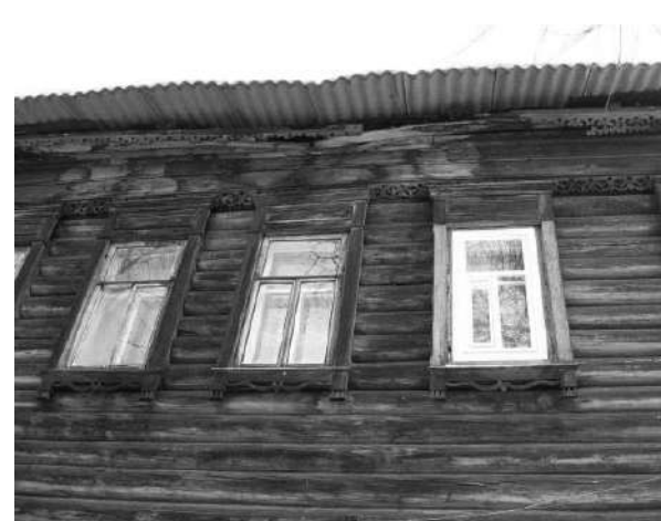
Фото 8 - Наличник 2 этажа главного фасада (юго-западный).
