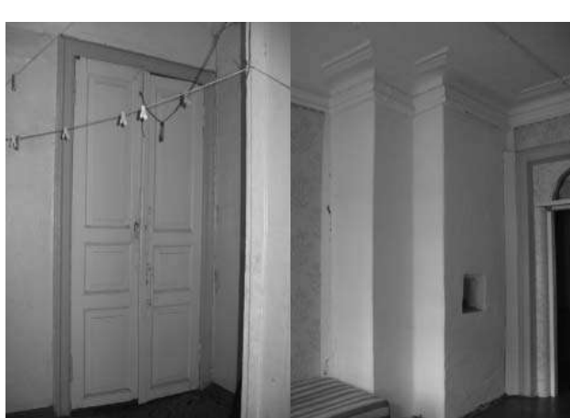
Фото 11 - Дверной проем в кв.№3, ком.8 Печь в кв.№3, ком.8
