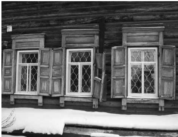
Фото 7 - Наличник 1 этажа главного фасада (юго-западный).
