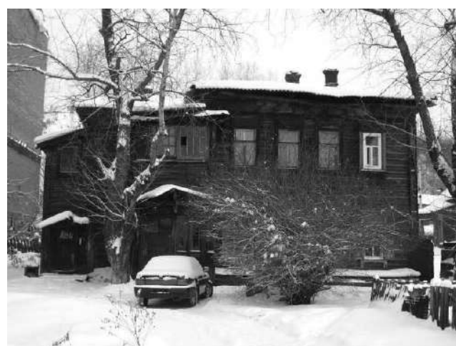
Фото 2 - Главный фасад (юго-западный).
