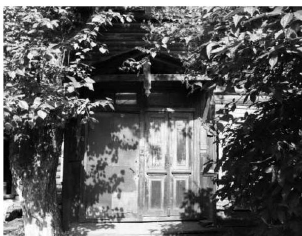
Фото 4 - Главный фасад (юго-западный). Главный вход.
