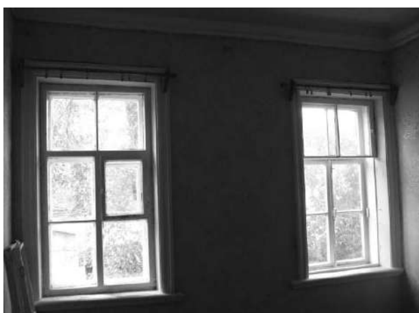
Фото 10 - Окна в кв.№3, ком.8
