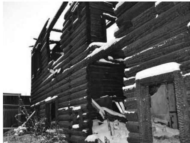
Фото 2018 г. Тылный (северо-восточный) фасад.
