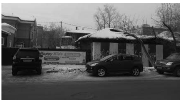
Фото 1 - Вид с ул. Володарского на усадьбу по адресу ул. Володарского, 2
