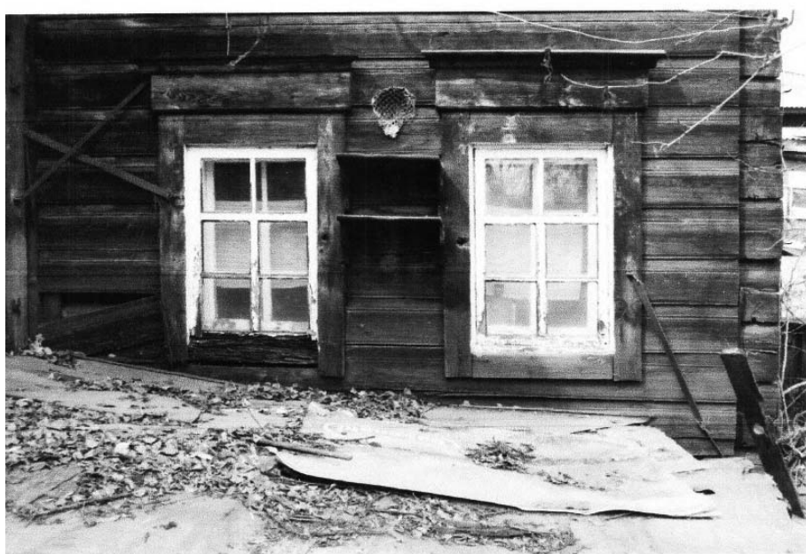
Фото 21. Окна второго этажа юго-восточного фасада со следами крепления ставень.
