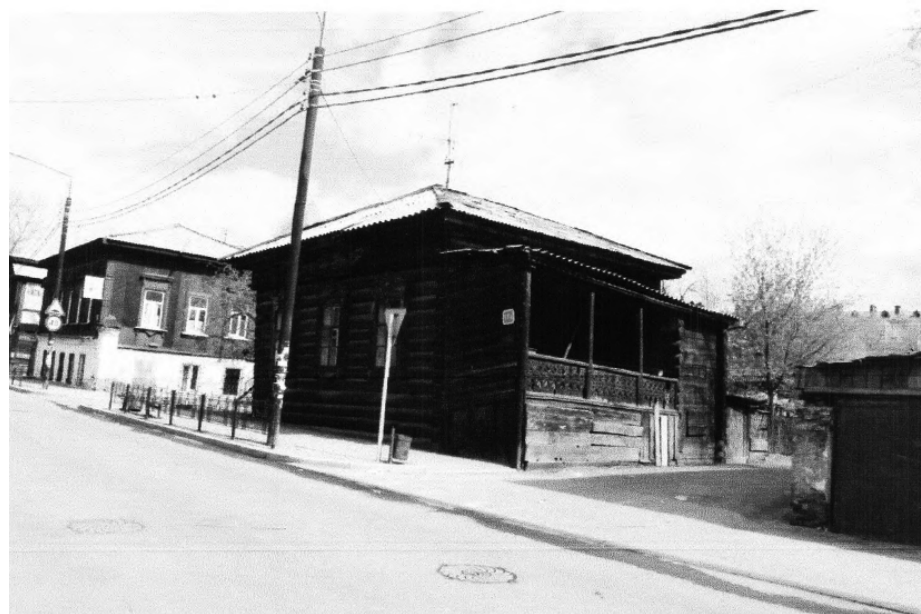
Фото 2. Общий вид ул. Грязнова.
