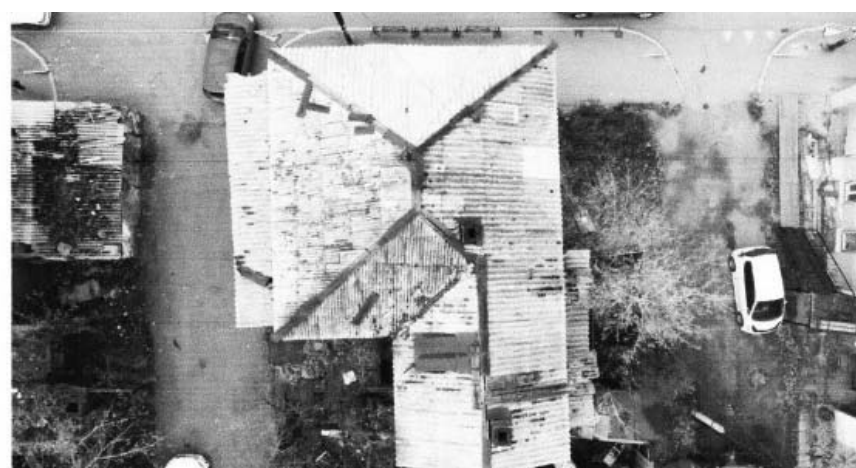
Фото 8. Общий вид кровли.
