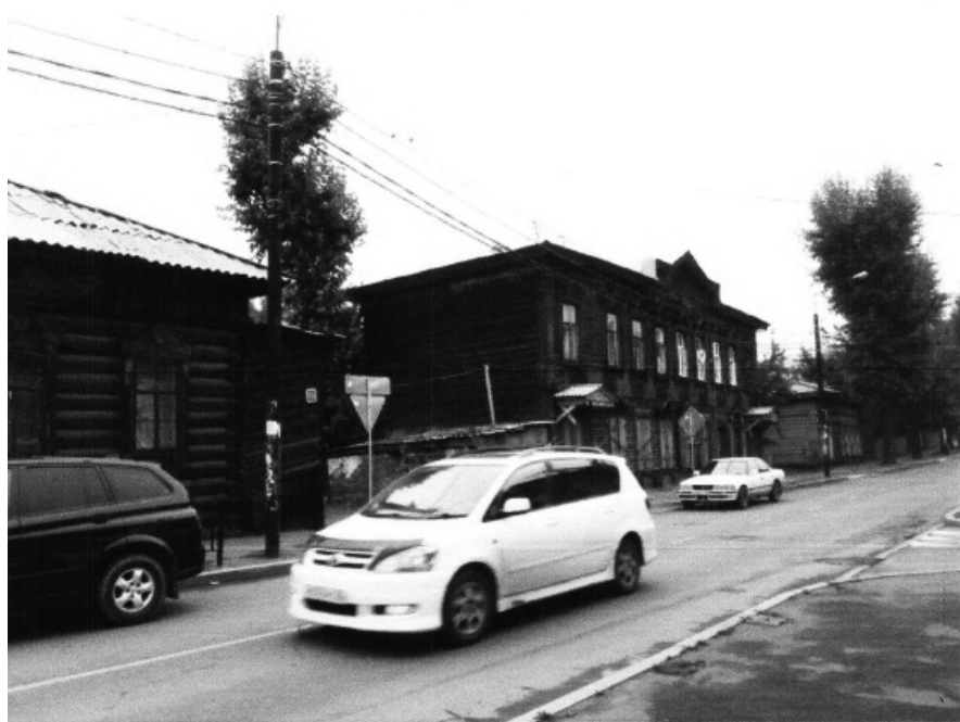
Фото 1. Общий вид ул. Грязнова.
