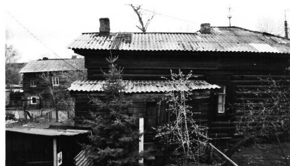
Фото 32. Пристрой «чёрной» лестницы.
