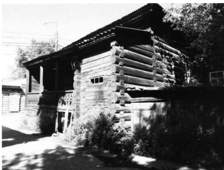
Фото 5. Общий вид на юго-восточный и северо-восточный фасады.
