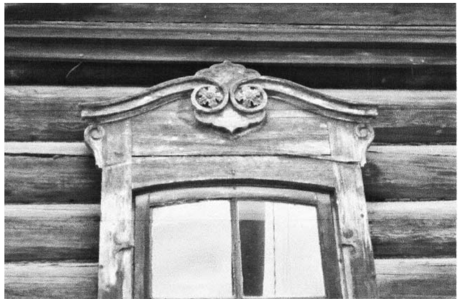
Фото 12. Завершение наличника главного фасада.
