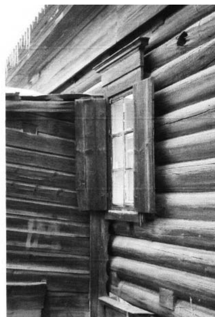
Фото 31. Место примыкания пристроя «чёрной» лестницы к основному объёму здания и окно с наличником второго этажа северо-западного фасада.
