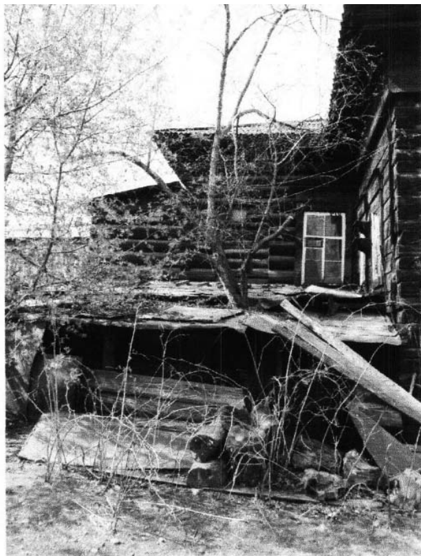
Фото 25. Основная часть здания с поздним пристроем гаража.
