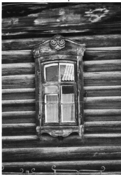
Фото 11. Окно и наличник главного (юго-западного) фасада.
