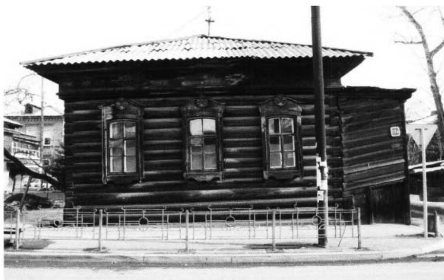
Фото 3. Главный фасад (юго-западный) по ул. Грязнова.
