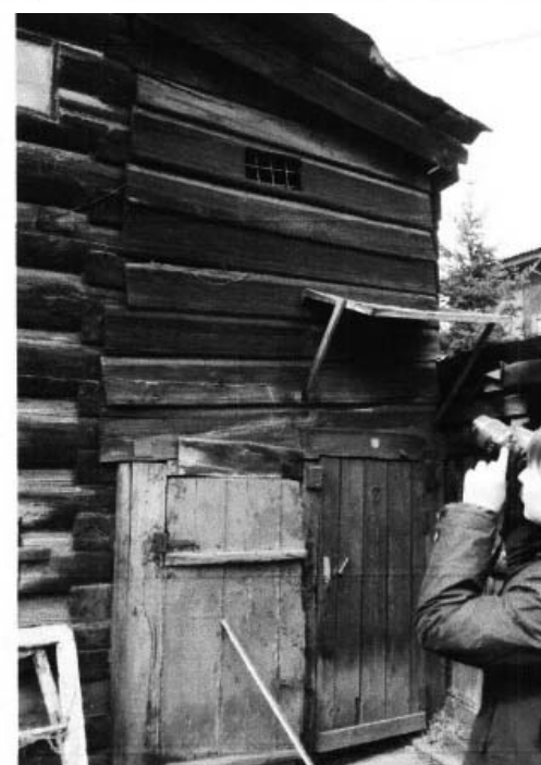
Фото 24. Пристрой «чёрной» лестницы. Обшивка калёванной доской.
