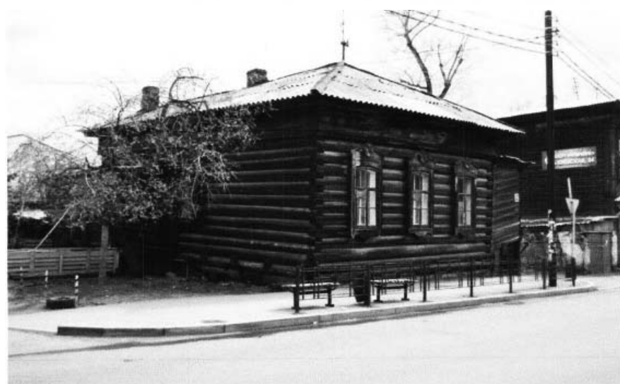
Фото 7. Общий вид на северо-западный и юго-западный фасады.
