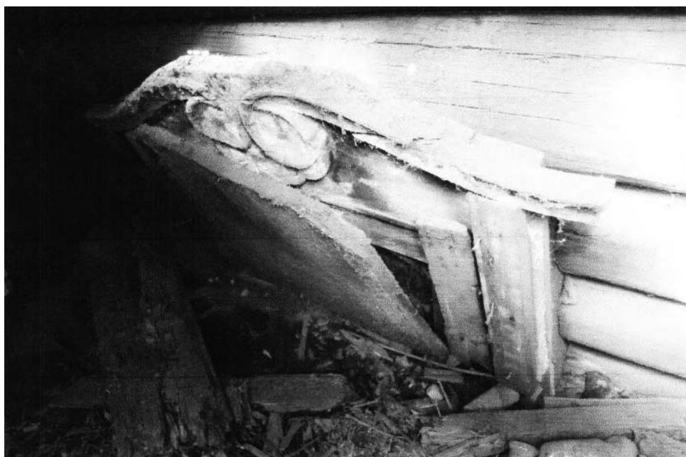
Фото 17. Остатки наличника первого этажа под галерей.
