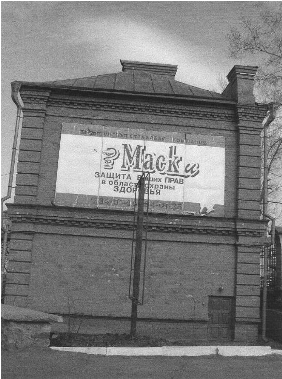
7. Юго-западный (торцовый) фасад
