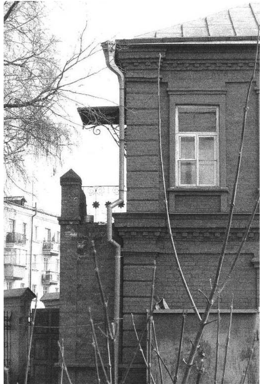
10. Фрагмент северо-западного фасада, пристрой с лестницей к юго-западному торцу.
