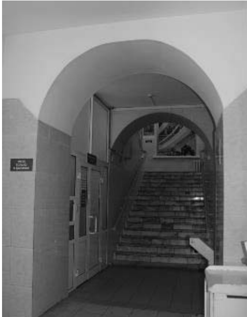
Арочный вход на парадную лестницу. Первый этаж.
