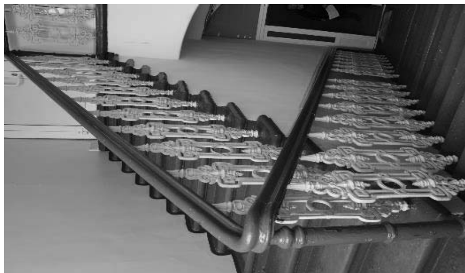
Фото Н.В. Шастун, апрель 2019 г. Лестница на второй этаж. Правое крыло здания.
