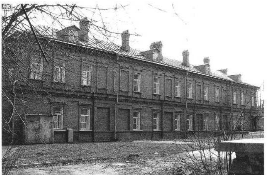
3. Северо-западный (дворовый) фасад
