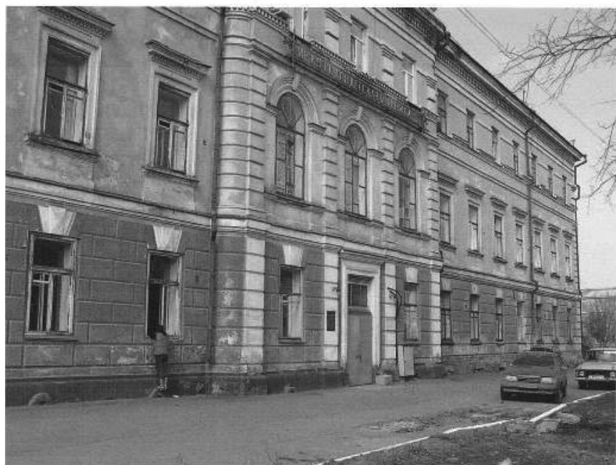
3. Фрагмент главного фасада (правое крыло)
