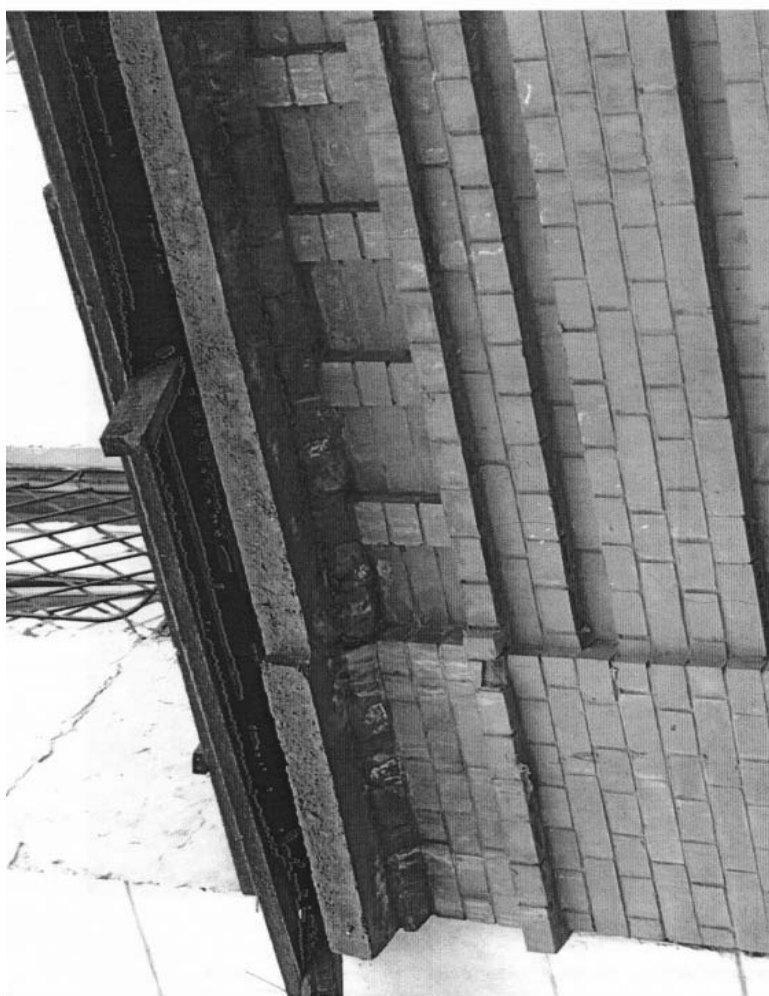
ФОТО 11 Иркутская область, г. Иркутск, ул. Тимирязева, 33, лит. А. «Здание пожарной части». Основной объем. Главный фасад: карниз, фриз, лопатка. Фото Бельского А.П. сентябрь 2010 г.
