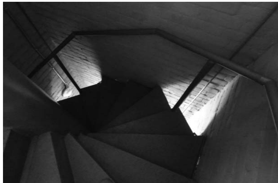
Металлическая лестница в объеме каланчи.
