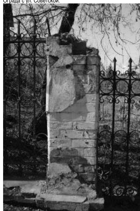
Утраты элементов ограды. Вывалы штукатурного слоя
