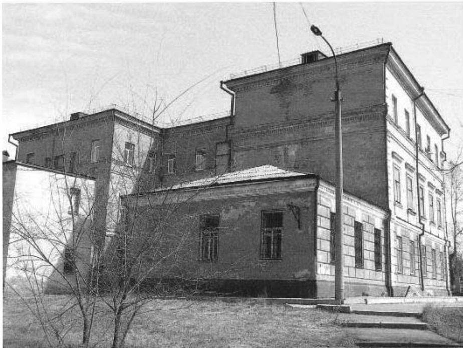
10. Вид на здание с запада
