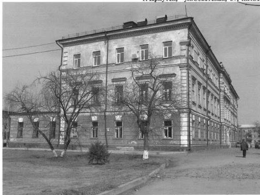
1. Общий вид здания (с юга)
