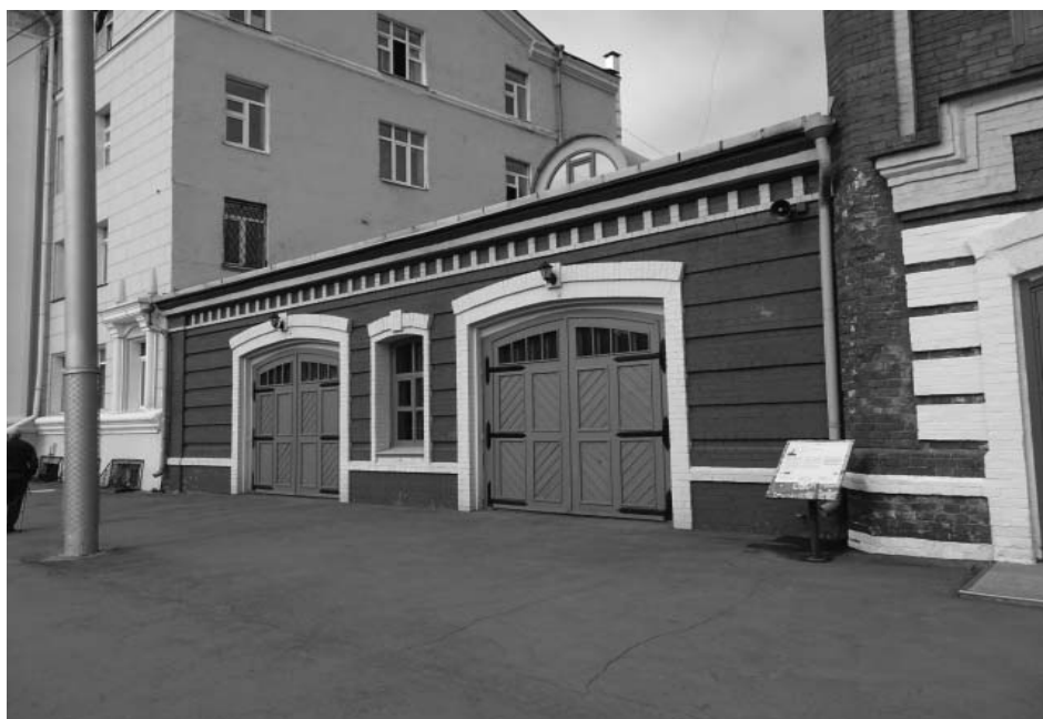
Фрагмент главного фасада. Дверные проемы.
