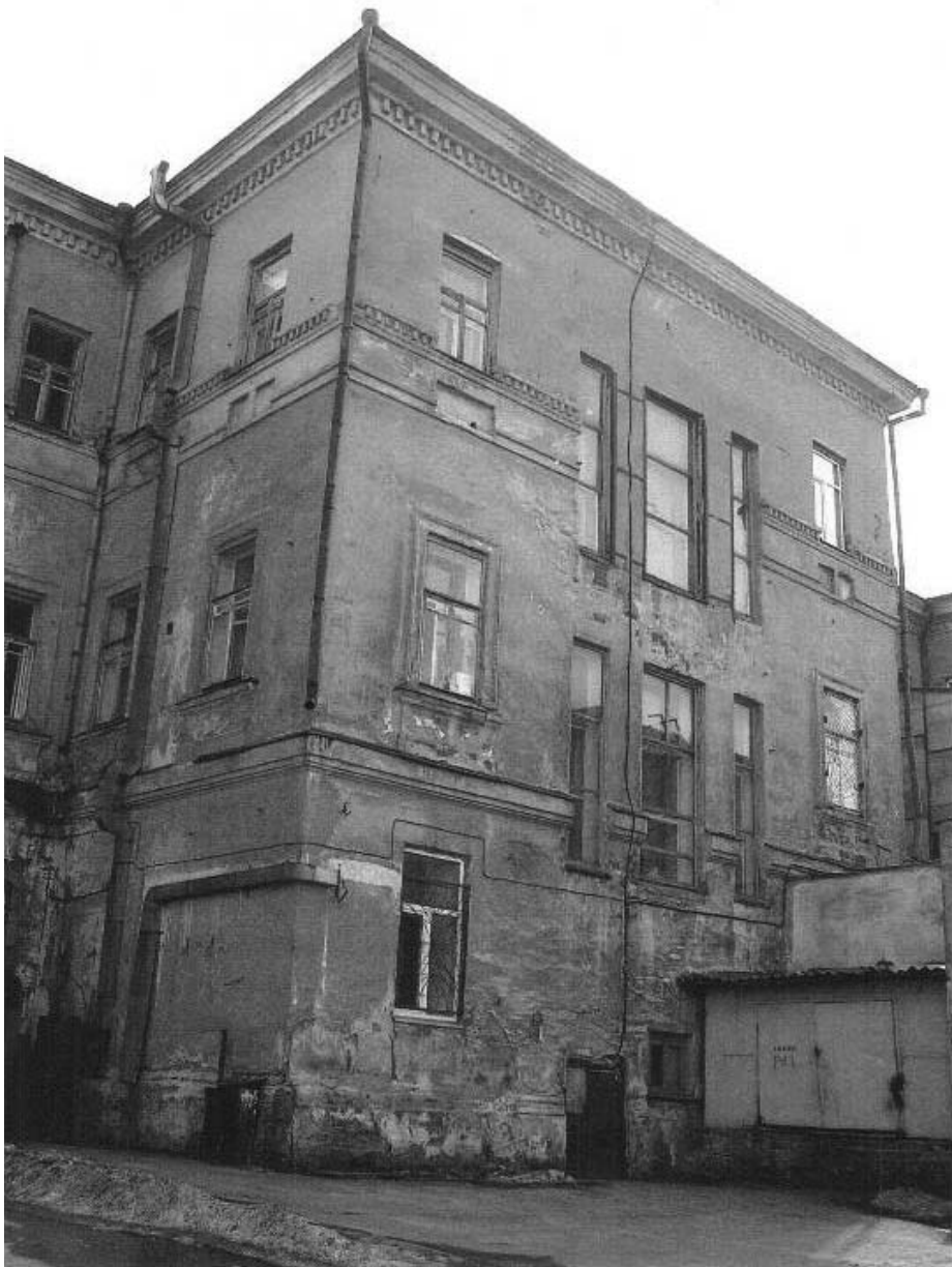
23. Северо-западный (задний) фасад, центральное крыло
