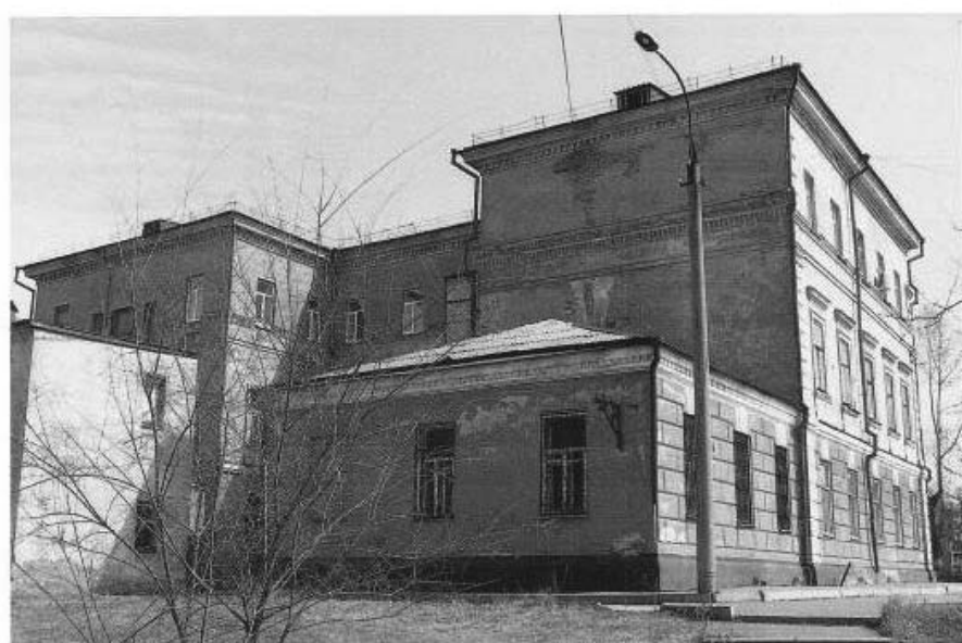
2. Общий вид здания (с запада)
