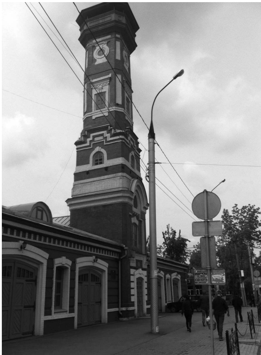
Главный (юго-восточный) фасад.
