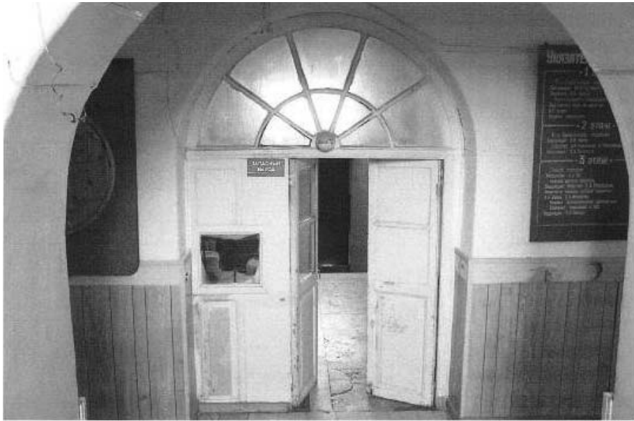
21. Арочный вход, первый этаж
