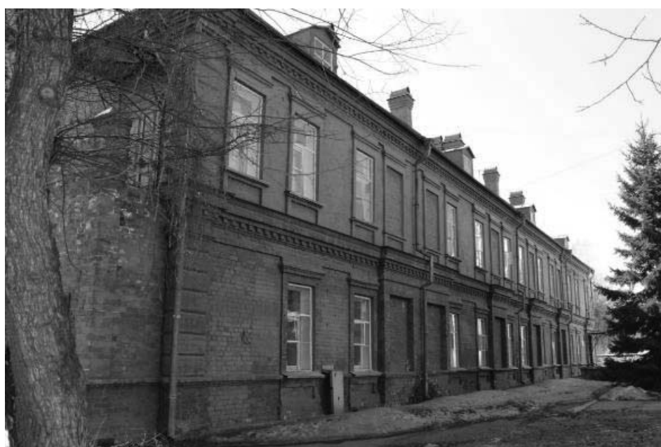
Северо-западный фасад. Вид с северного угла.
