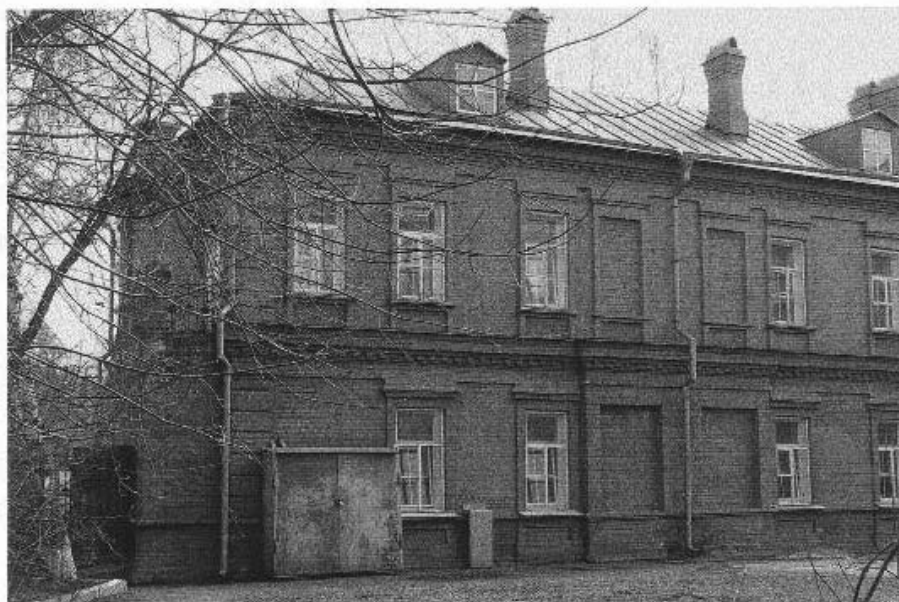
4. Фрагмент северо-западного фасада
