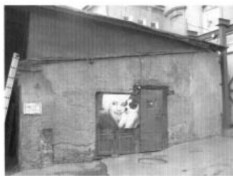
Фото 6, 7. Юго-восточный фасад. Поздние пристройки.
