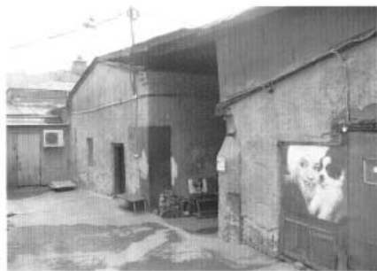
Фото 5. Общий вид со двора. Юго-восточный фасад
