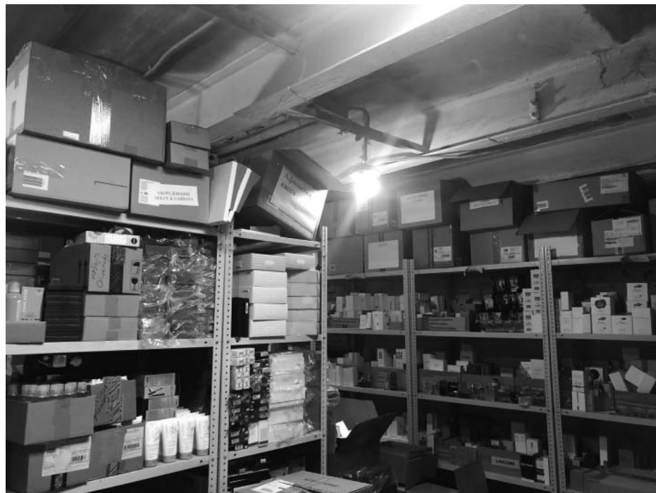
Интерьер подвала. Балочные потолки.
