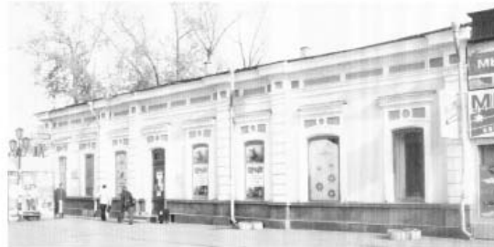
Фото 4. Фасад по ул. Урицкого (юго-западный)
