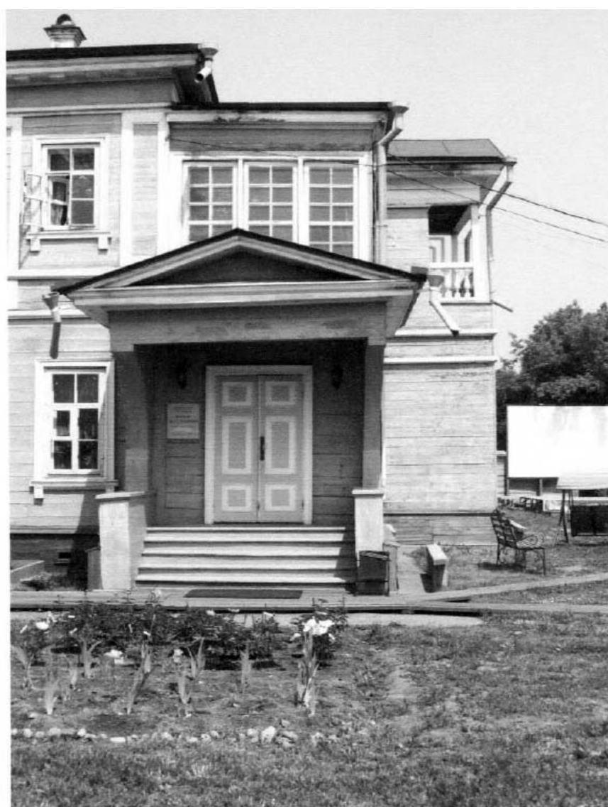
Фото 11. Фрагмент Юго-западного фасада, дворовой прируб с верандой-светелкой и парадное крыльцо.
