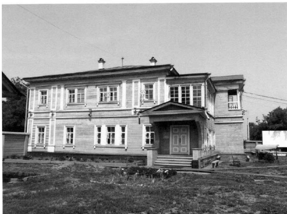
Фото 9. Юго-западный фасад, вид со стороны внутрисадебной территории.
