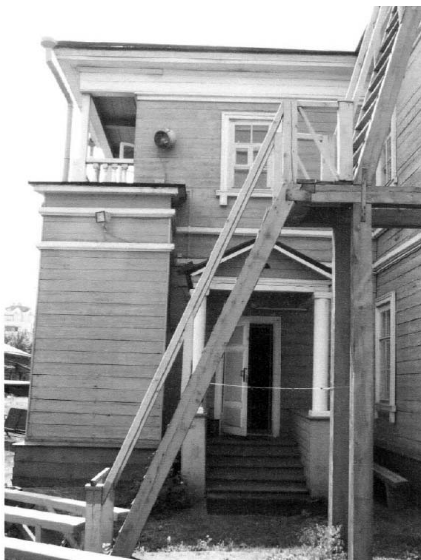
Фото 24. Фрагмент Северо-восточный фасад, крыльцо черного входа.
