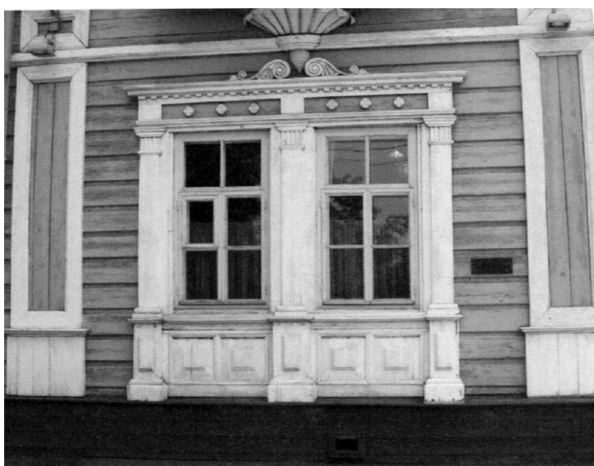
Фото 5. Наличник спаренного оконного проема первого этажа, правый ризалит Северо-западного фасада.
