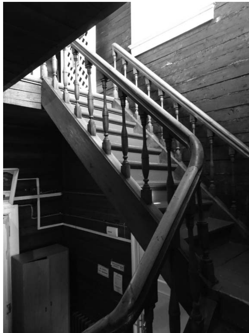
Лестница в пом. № 3 (1 эт).
