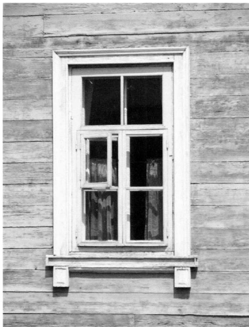
Фото 17. Наличник оконного проема первого этажа, Юго-западный фасад.
