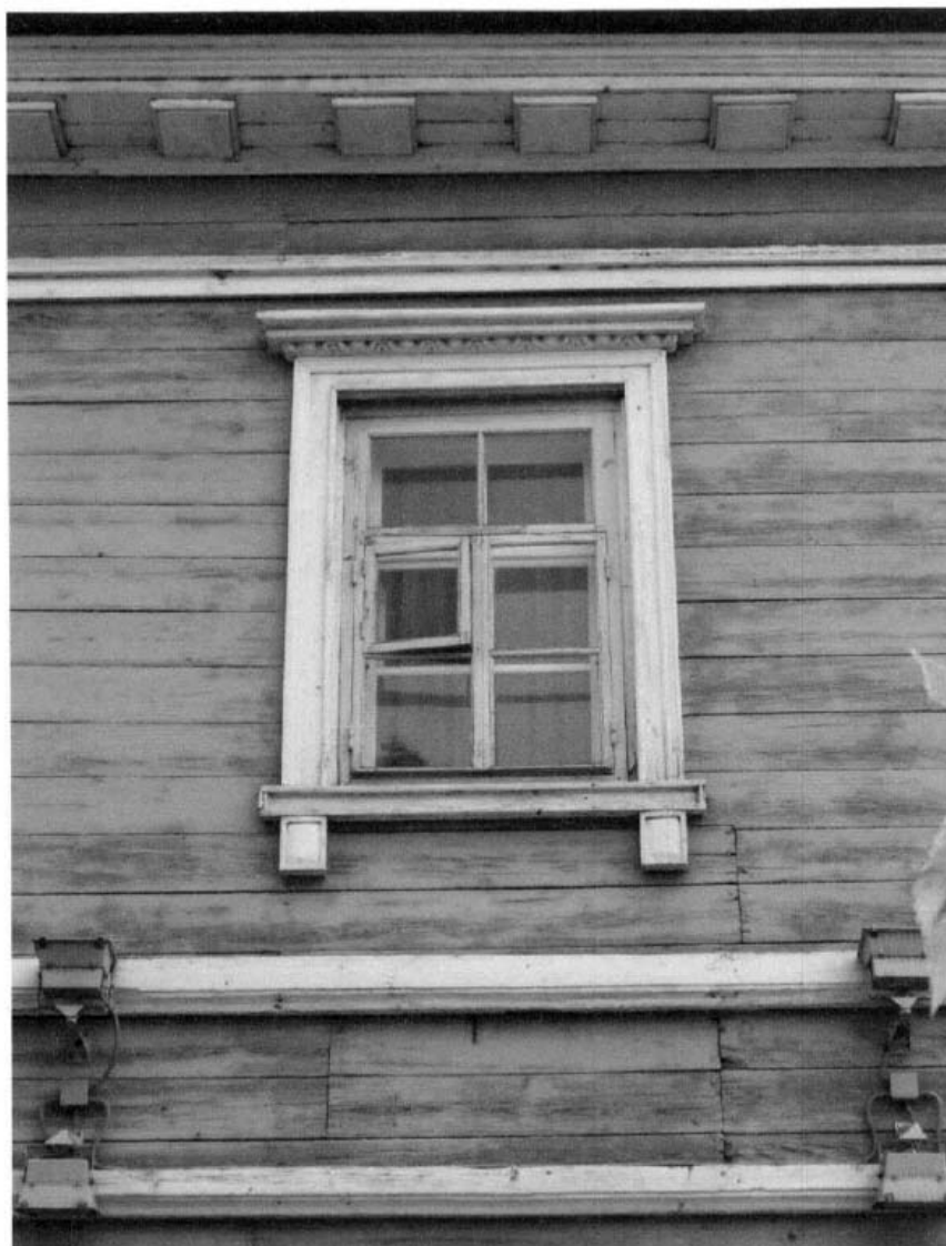
Фото 8. Наличник оконного проема второго этажа, Северо-западный фасад.
