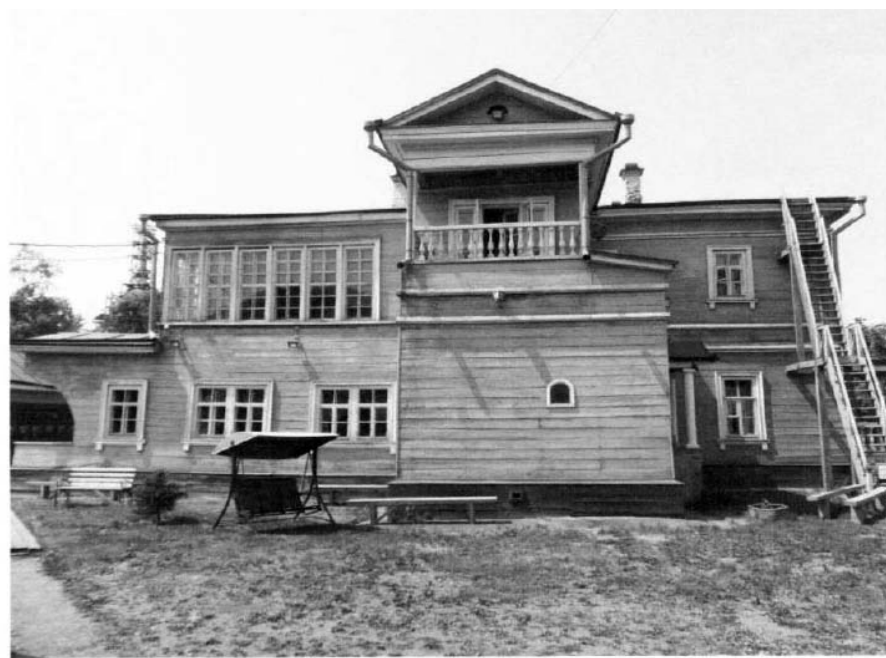
Фото 18. Юго-восточный фасад, вид со стороны внутриусадебной территории.
