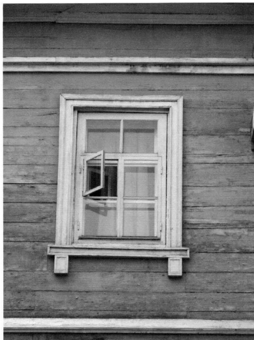
Фото 23. Наличник оконного проема второго этажа, Юго-восточный фасад.
