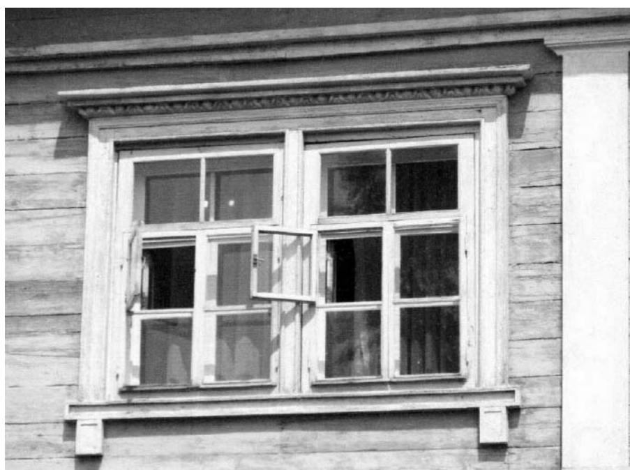
Фото 15. Наличник спаренного оконного проема второго этажа, Юго-западный фасад.
