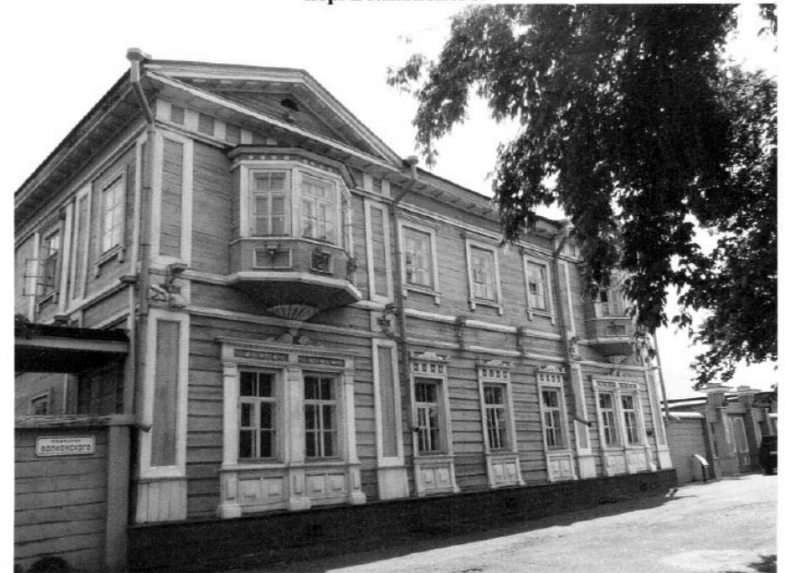
Фото 2. Северо-западный фасад, вид дома с северной стороны вдоль пер. Волконского.
