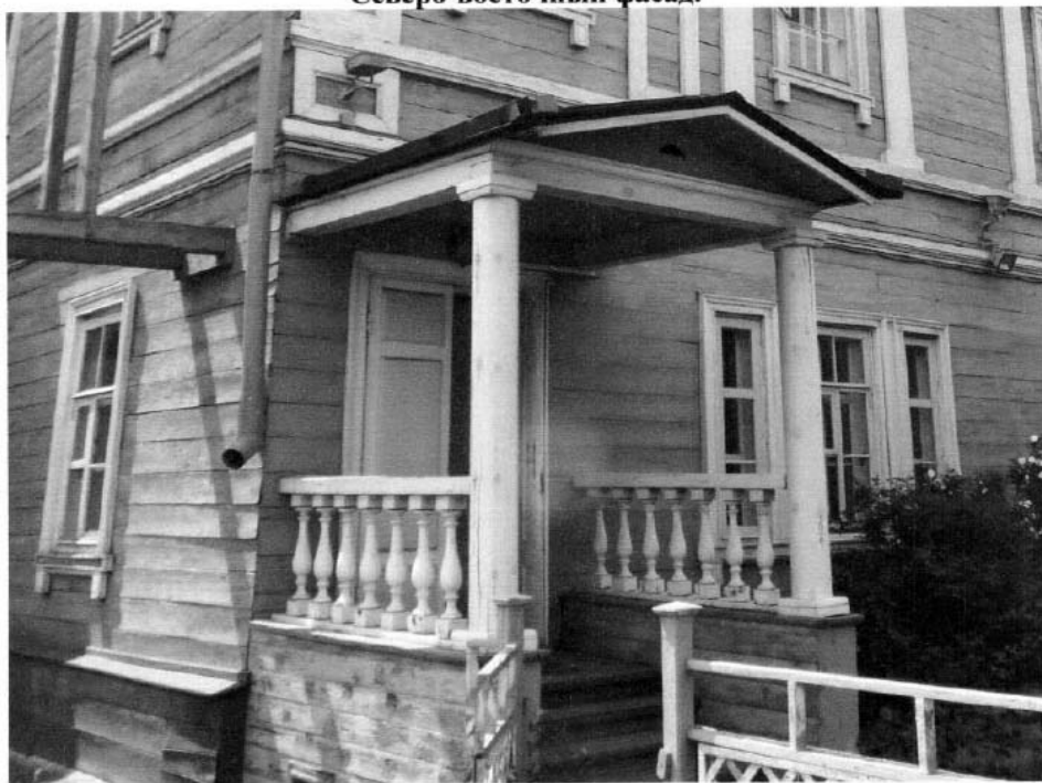
Фото 26. Фрагмент Северо-восточного фасада крыльцо.
