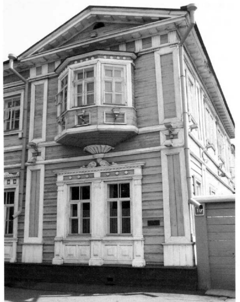
Фото 3. Фрагмент Северо-западного фасада, правый ризалит.
