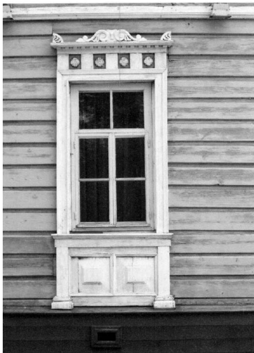
Фото 7. Наличник оконного проема первого этажа, Северо-западный фасад.
