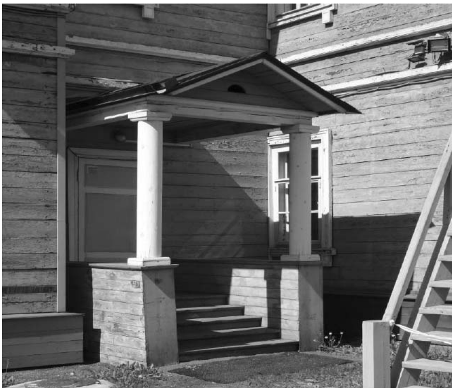
Крыльцо на юго-западном фасаде лит. А1.
