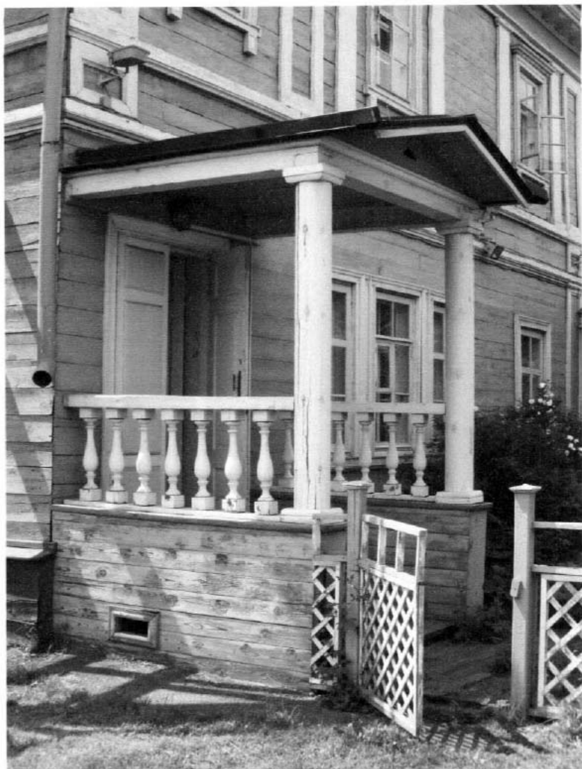
Фото 27. Крыльцо Северо-восточного фасада.
