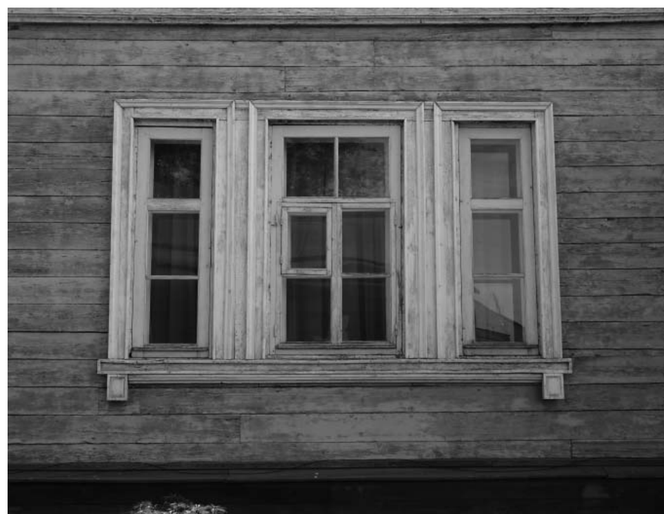
Наличник юго-западного фасада.
