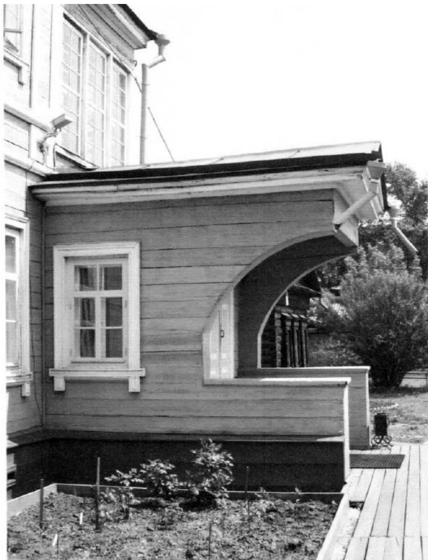
Фото 14. Крыльцо парадного входа, с северо-западной стороны.
