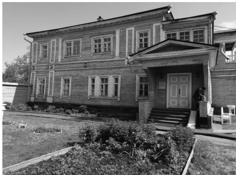
Боковой (юго-западный) фасад здания. Парадный вход с крыльцом.
