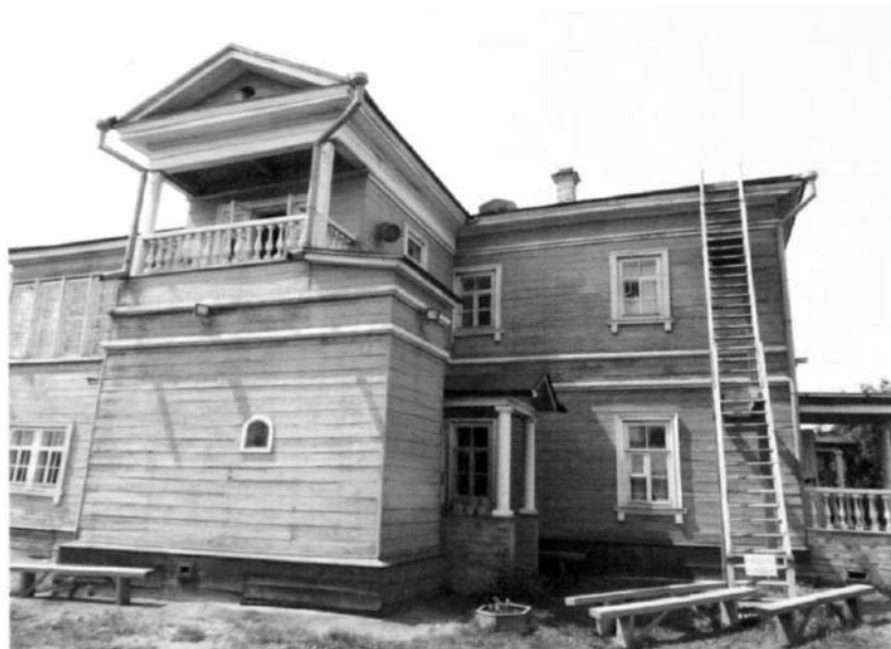
Фото 20. Фрагмент Юго-восточного фасада, переруб с балконом.
