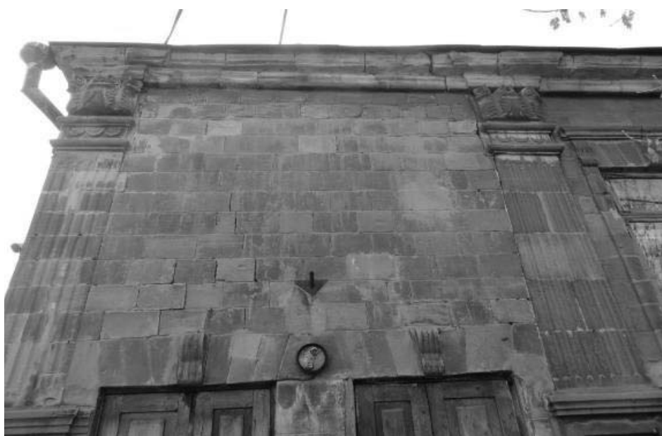
Фото 9 - Фрагмент главного северо-западного фасада (лит. Б)
