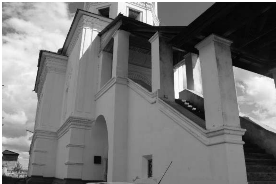
Фото Н.В. Шастун, июль, 2019 г. Фрагмент лестницы и бокового (северо-западного) фасада
