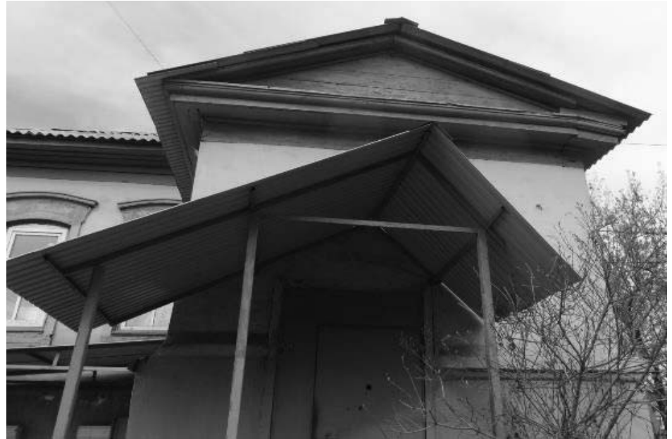
Фото 10 - Фрагмент с правого фланга (юго-восточного) фасада жилого дома (лит. А)
