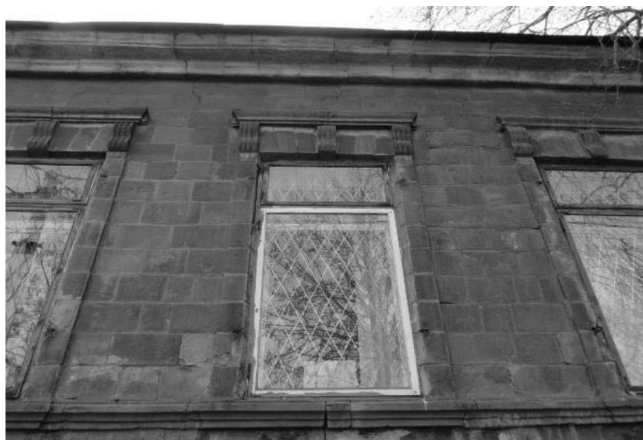
Фото 11 - Фрагмент главного северо-западного фасада (лит. Б)
