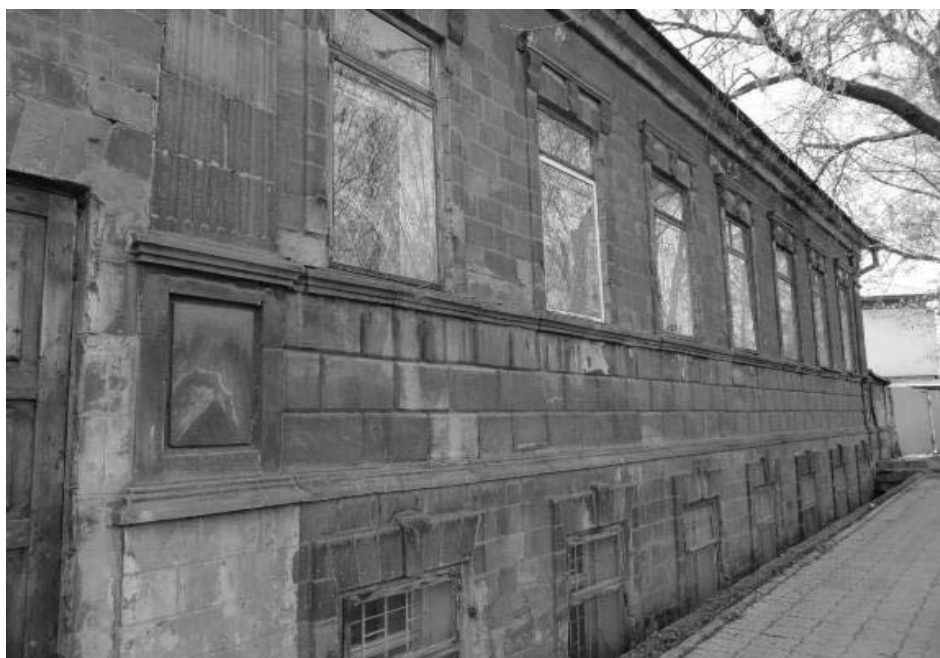
Фото 7 - Фрагмент главного северо-западного фасада (лит. Б)
