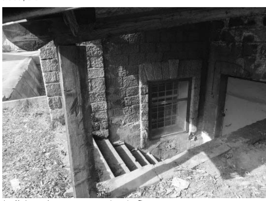
Фото 20 - Фрагмент бокового северо-восточного фасада (лит. Б), с левого фланга. Вход в помещения полуподвального этажа
