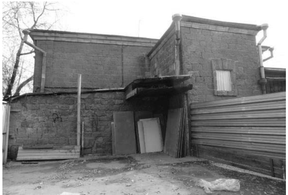
Фото 4 - Боковой юго-западный фасад доходного дома (лит. Б)
