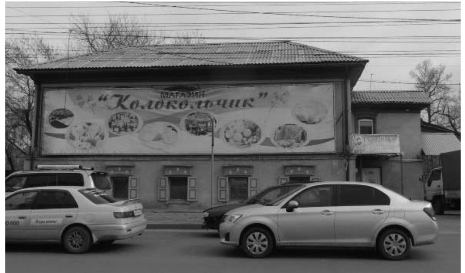
Фото 1 - Главный (юго-западный) фасад жилого дома (лит.А)
