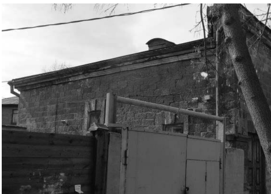
Фото 8 - Фрагмент бокового северо-восточного фасада (лит. Б)
