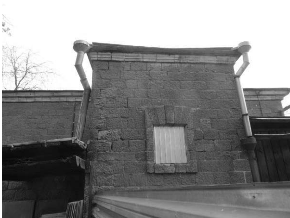
Фото 16 - Фрагмент бокового юго-западного фасада (лит. Б)
