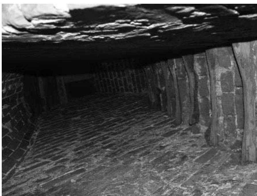
Фото Н.В. Шастун, июль, 2019 г. Кирпичная лестница на колокольню
