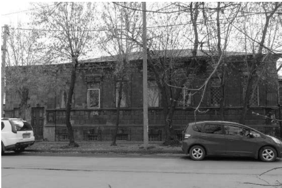
Фото 1 - Главный северо-западный фасад доходного дома (лит. Б)
