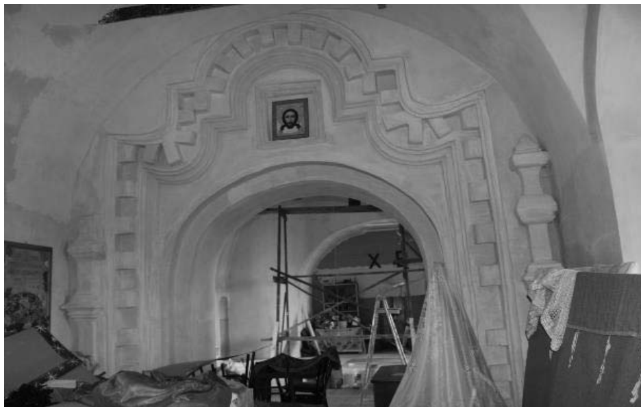
Фото Н.В. Шастун, июль, 2019 г. Помещение этажа №2 (проход между колокольней и трапезной)
