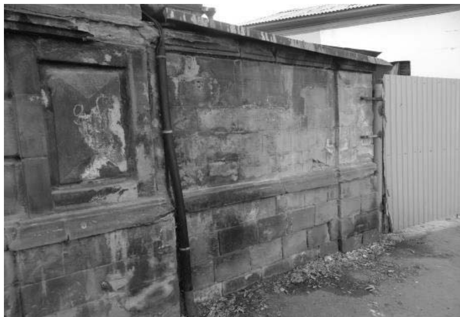
Фото 14 - Фрагмент главного северо-западного фасада (лит. Б)
