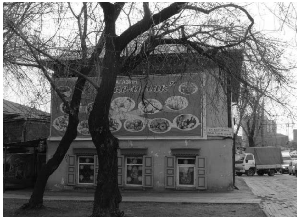
Фото 3 - Торцовый (северо-западный) фасад жилого дома (лит. А)
