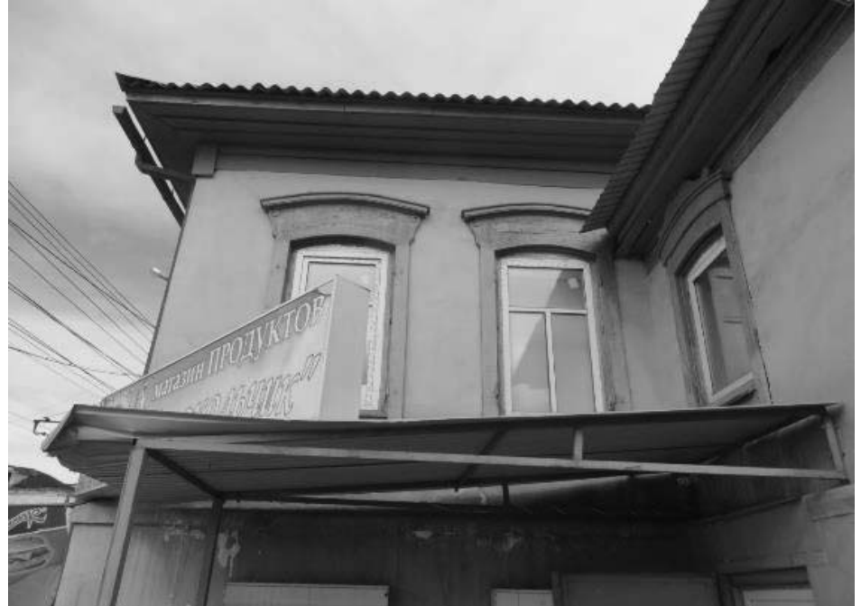
Фото 9 - Фрагмент с левого фланга (юго-восточного) фасада жилого дома (лит. А)
