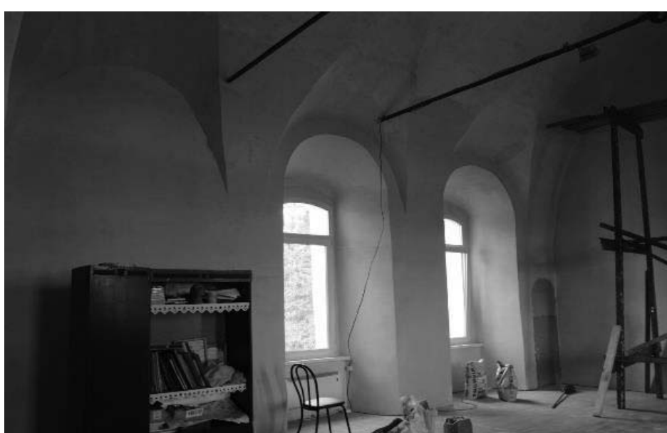
Фото Н.В. Шастун, июль, 2019 г. Помещение этажа №2 с видом на оконные проемы и потолочный свод
