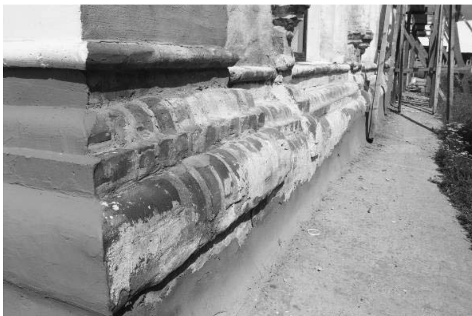
Фото Н.В. Шастун, июль, 2019 г. Фрагмент цоколя бокового (южного) фасада
