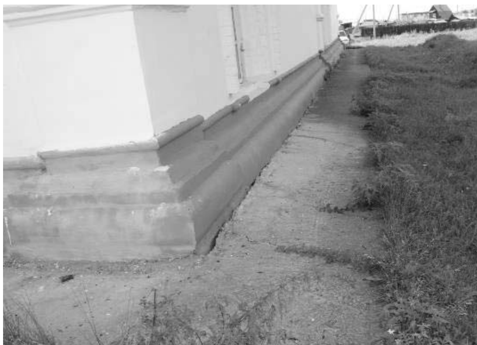
Фото Н.В. Шастун, июль, 2019 г. Фрагмент кирпичного цоколя бокового (северного) фасада
