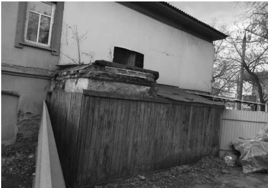
Фото 8 - Фрагмент дворового (северо-восточного) фасада жилого дома (лит. А)
