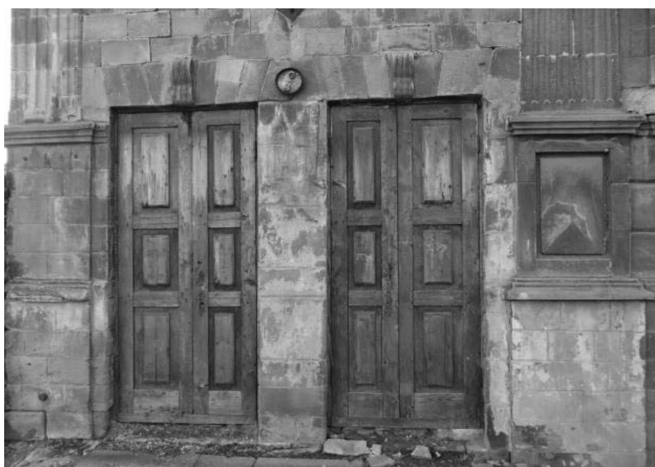
Фото 10 - Фрагмент главного северо-западного фасада (лит. Б), парадный вход.
