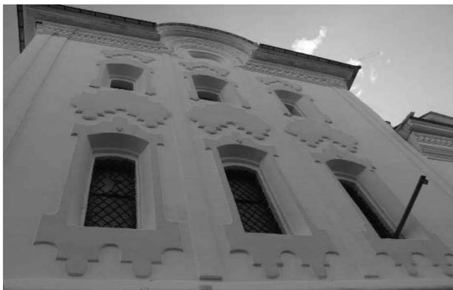
Фото Н.В. Шастун, июль, 2019 г. Оконные проемы второго и третьего яруса
