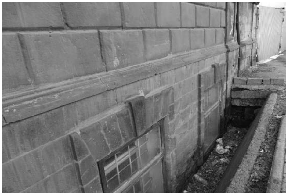
Фото 12 - Фрагмент главного северо-западного фасада (лит. Б), полуподвальный этаж.
