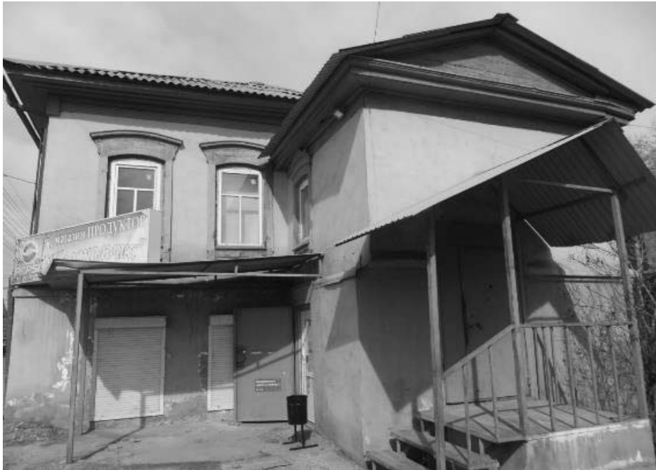
Фото 7 - Торцовый (юго-восточный) фасад жилого дома (лит. А)
