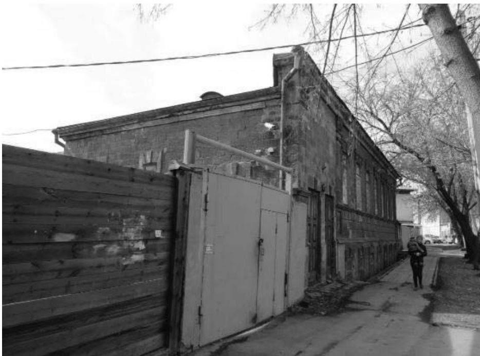
Фото 2 - Общий вид доходного дома (лит. Б) с северного угла
