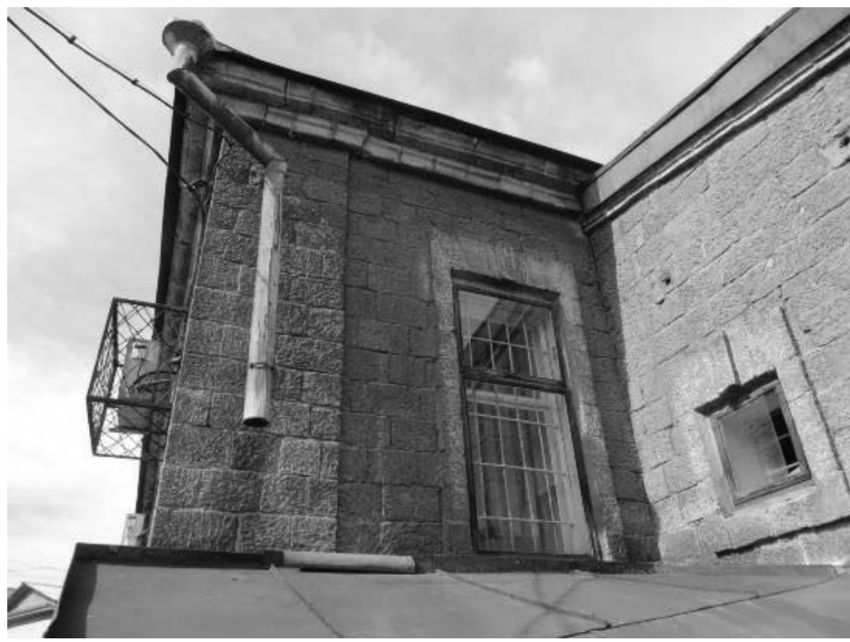
Фото 19 - Фрагмент бокового северо-восточного фасада (лит. Б), с левого фланга
