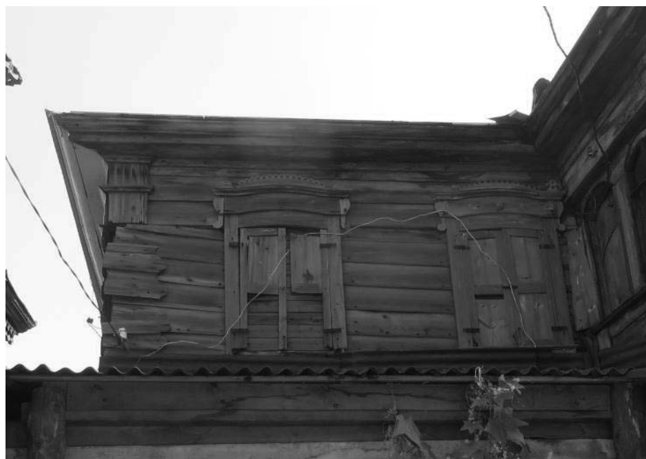
Фото 9 - Фрагмент северо-западного фасада. Оконные проемы 2 этаж
