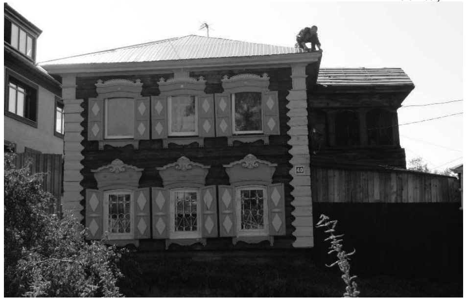
Фото 1 - Главный (северо-восточный) фасад
