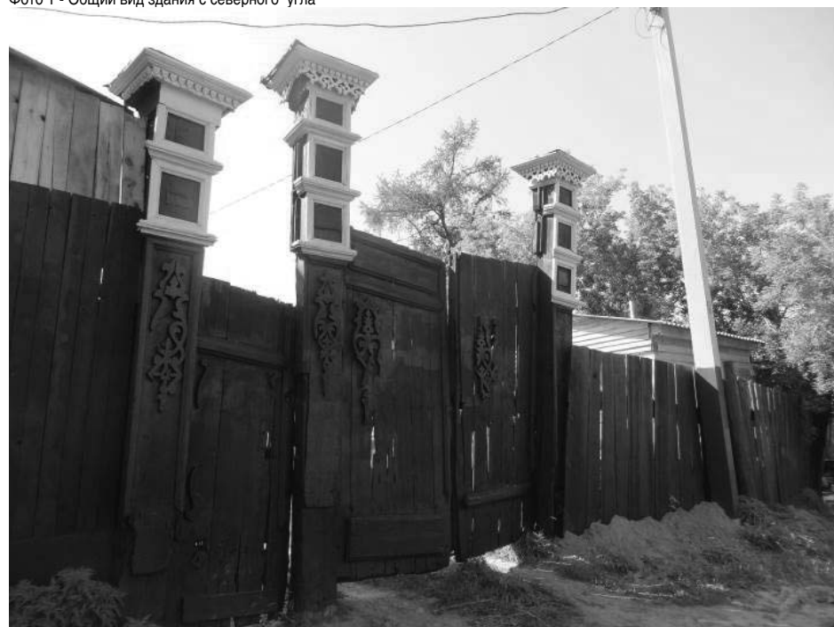
Фото 2 - Ворота. Вид с главного (северо-восточного) фасада
