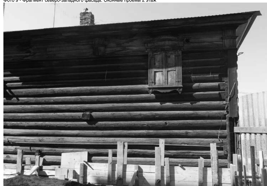
Фото 10 - Фрагмент юго-восточного фасада с прилегающей территории
