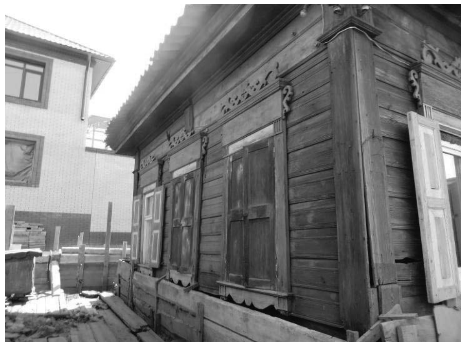
Фото 2 - Вид с северного угла. Северо-восточный фасад
