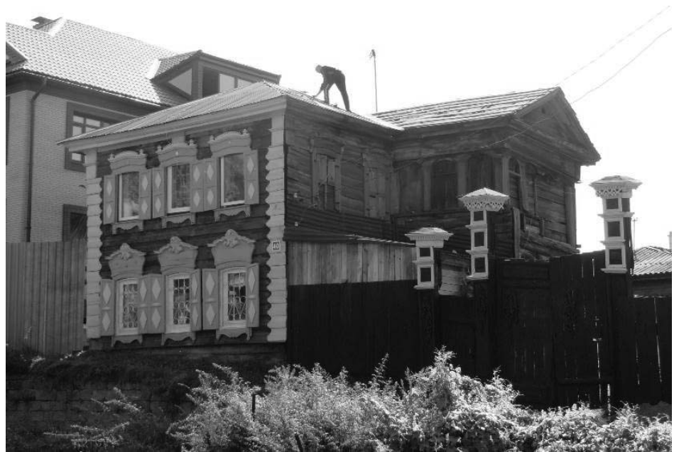
Фото 2 - Общий вид здания с северного угла
