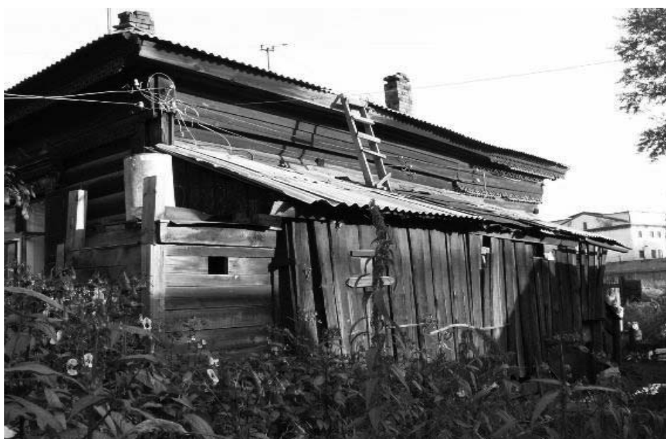
Фото 10 - Боковой (западный) фасад (лит.Г). Фото из архива Госоргана
