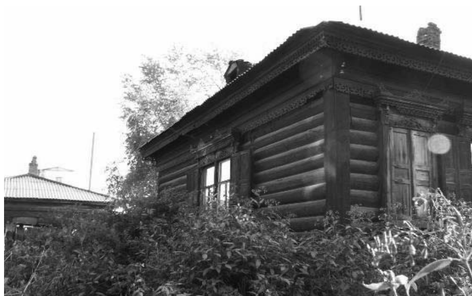
Фото 12 - Боковой (восточный) фасад здания (лит. Г). Фото из архива Госоргана
