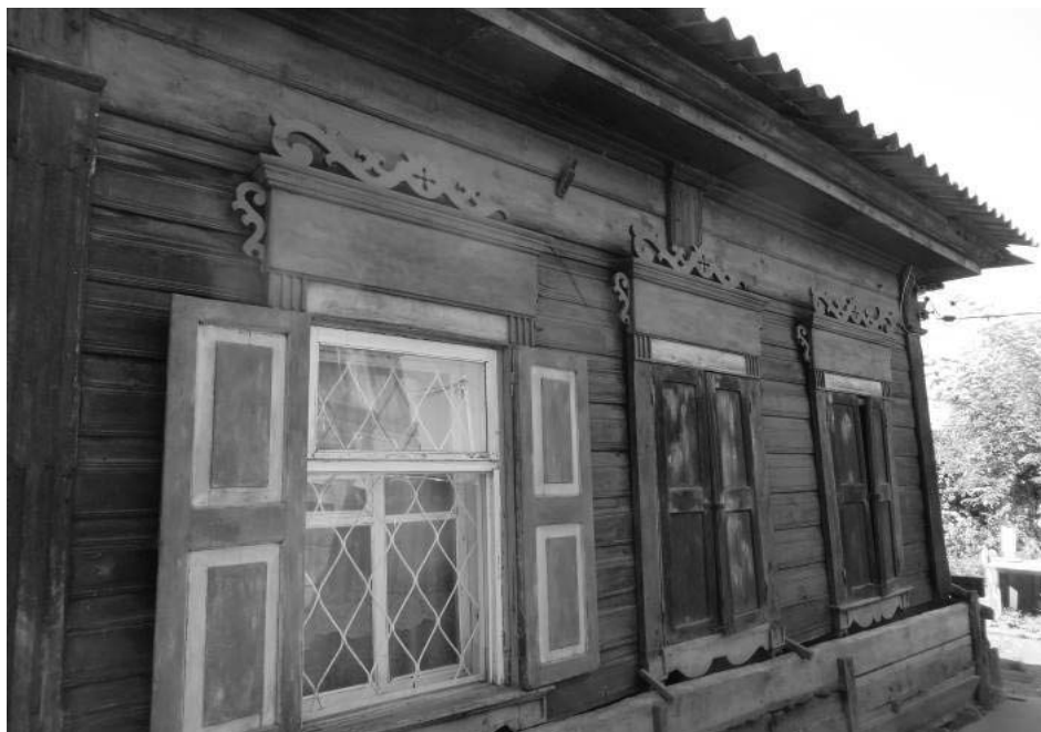
Фото 4 - Фрагмент северо-восточного фасада
