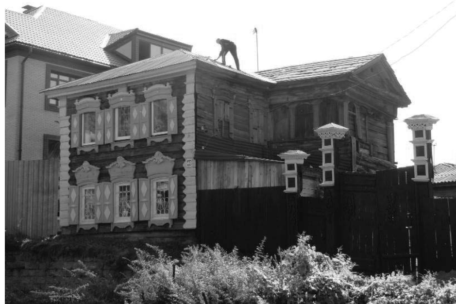
Фото 1 - Общий вид здания с северного угла
