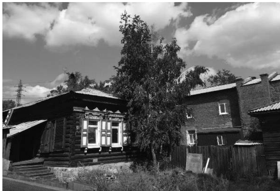
Фото 4 - Главный (южный) и боковой (западный) фасады здания (лит. Г)
