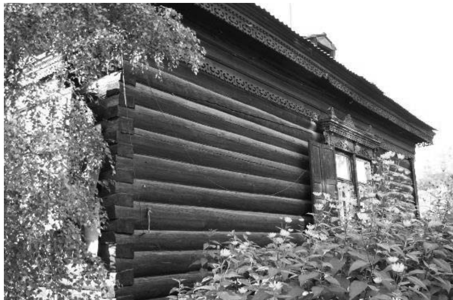
Фото 11 - Боковой (восточный) фасад здания (лит. Г). Фото из архива Госоргана
