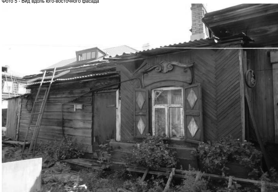
Фото 6 - Фрагмент северо-западного фасада.Лит.Б1
