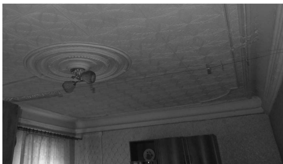
Фото 9 - Потолочные тяги. Потолочная розетка
