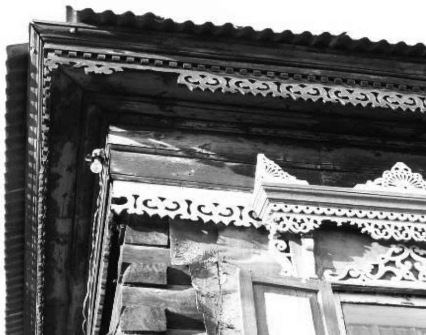
Фото 13 - Фрагмент карниза и фриза здания (лит. Г). Фото из архива Госоргана
