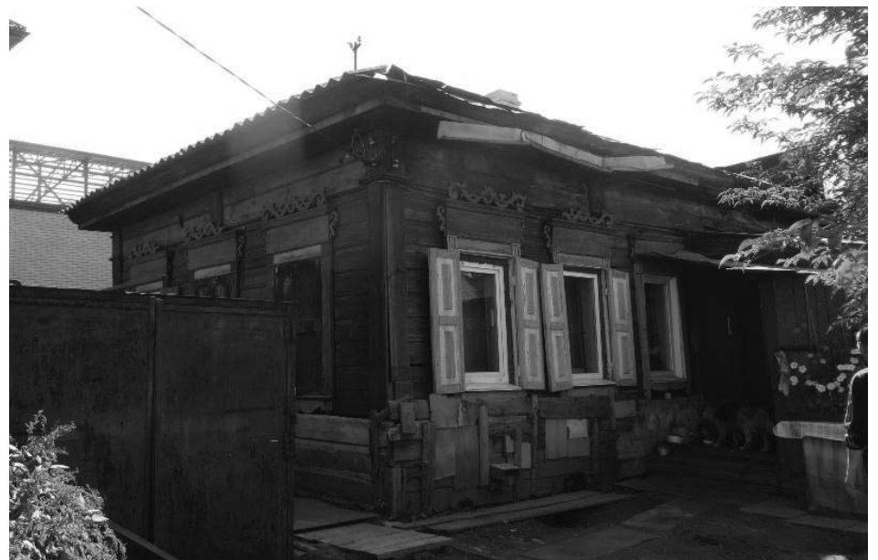
Фото 1 - Общий вид здания с северного угла
