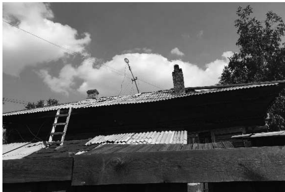
Фото 5 - Боковой (западный) фасад здания (лит. Г)
