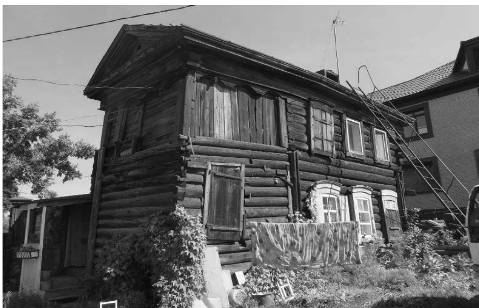
Фото 6 - Вид дома с западного угла. Юго-западный фасад
