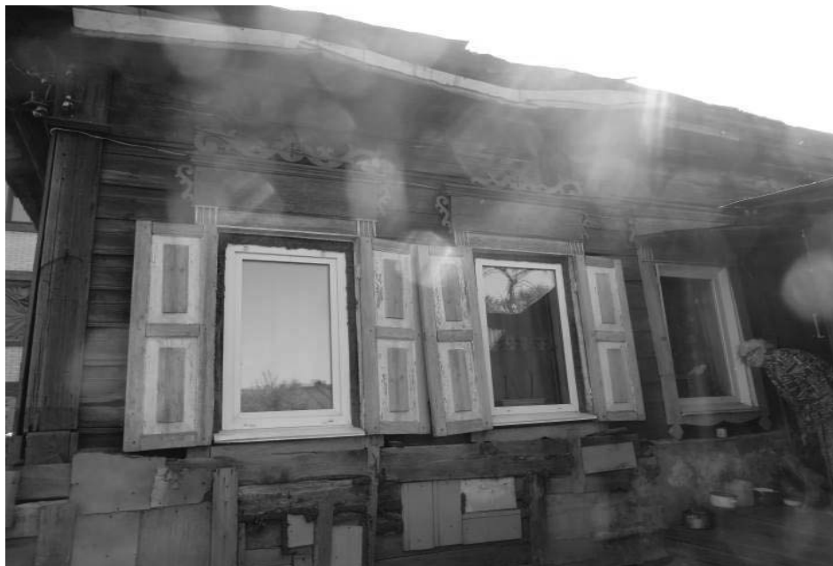
Фото 3 - Фрагмент северо-западного фасада
