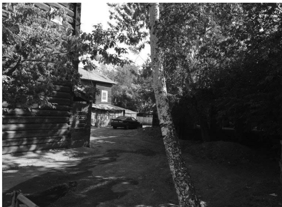
Фото 1 - Вид во двор усадьбы со стороны ул. Грязнова. Слева главный дом усадьбы лит. А, справа – флигель (лит. Д)
