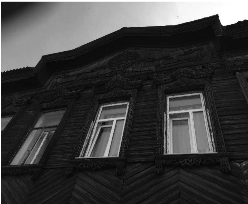
Фото 9 - Фронтон с декоративными накладными элементами со стороны главного (юго-западного) фасада
