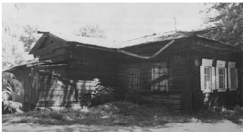
Фото 2 - Вид дома северо-западный и юго-западный фасада. Архивное фото 2009г.
