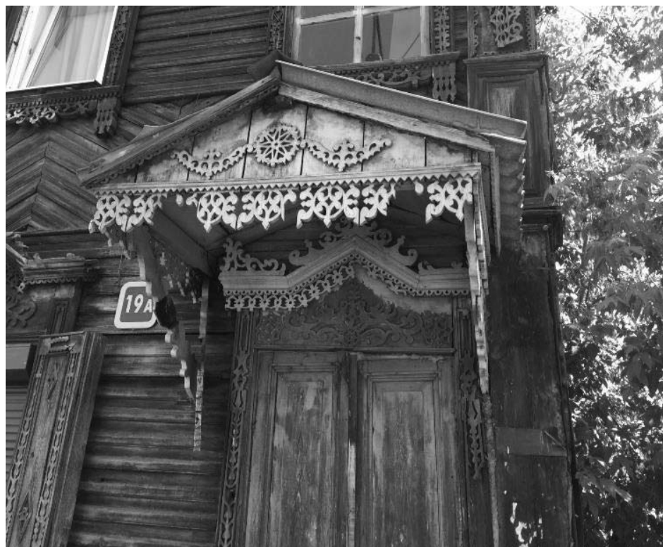
Фото 11 - Козырек над входом справа (южный угол основного объема) со стороны главного фасада
