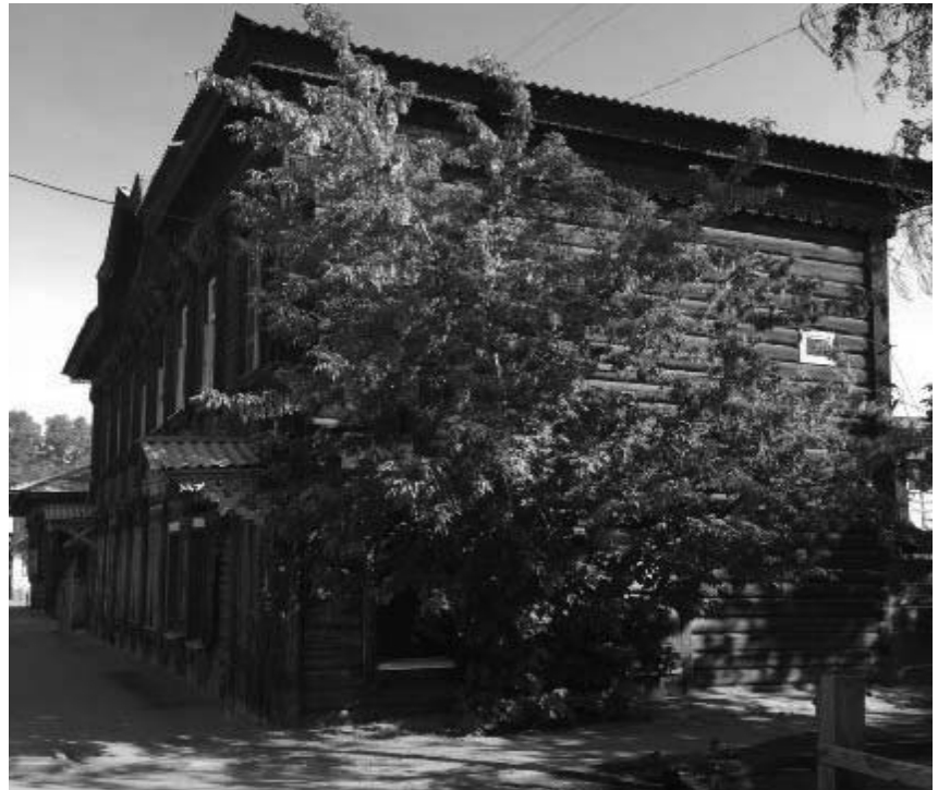
Фото 5 - Общий вид на боковой (юго-восточный) фасад
