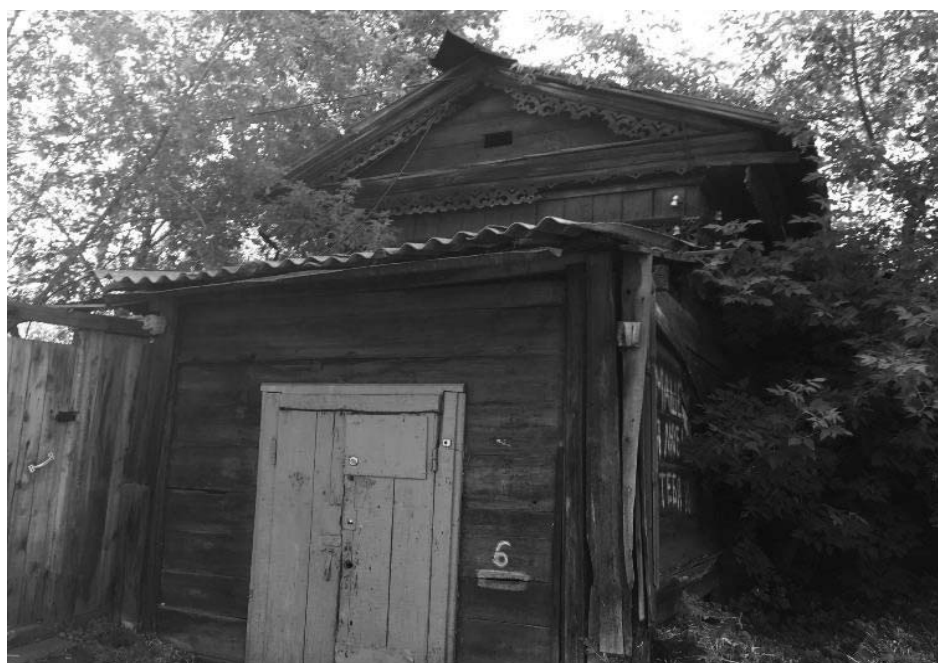
Фото 7 - Прируб с крыльцом (лит. Д2,Д3) со стороны северо-западного фасада
