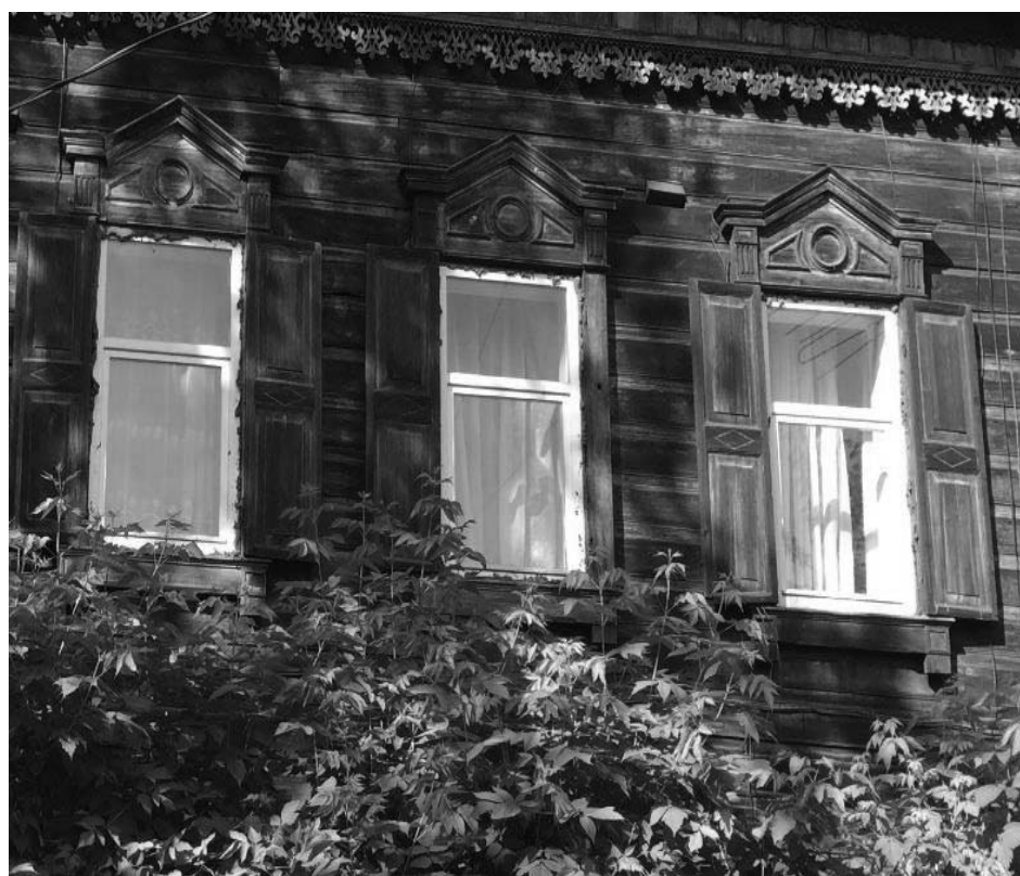
Фото 12 - Наличники второго этажа со стороны дворового (северо-западного) фасада
