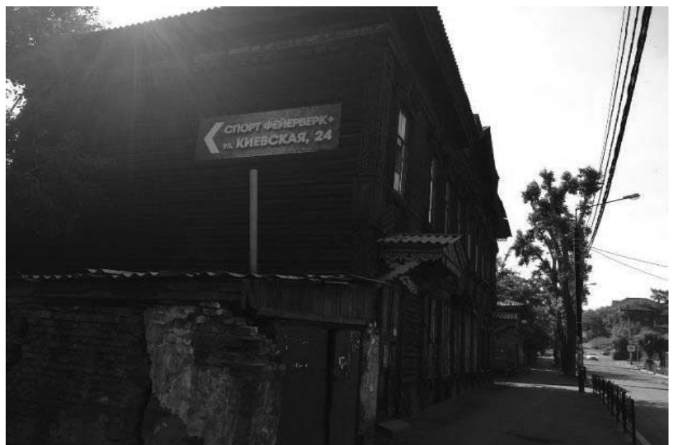
Фото 6 - Общий вид на боковой (северо-западный) фасад
