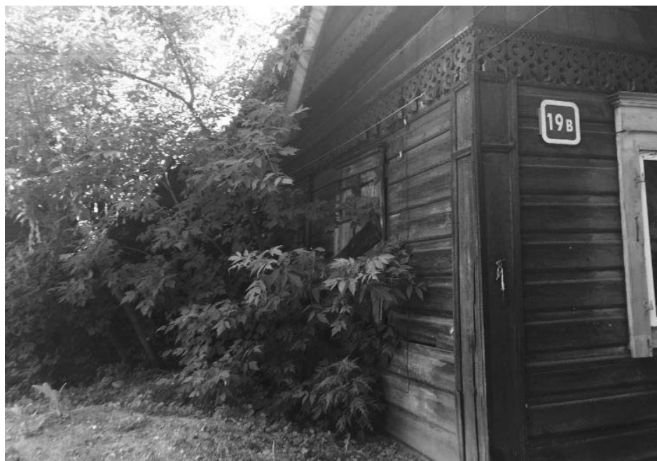
Фото 6 - Фрагмент бокового (северо-западного) фасада. Декоративные элементы: обшивка, наличники, ставни, фриз, лопатка, карниз
