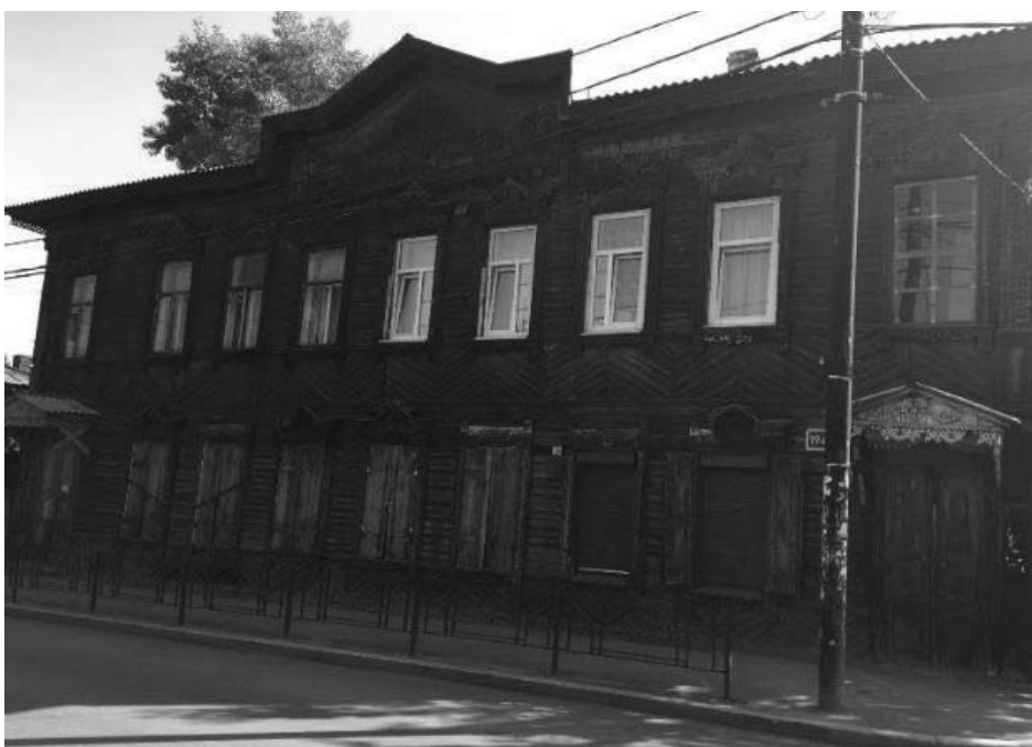
Фото 3 - Общий вид на юго-западный фасад здания
