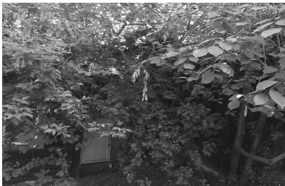
Фото 8 - Пристрой между юго-восточным фасадом дома и брандмауэрной стеной
