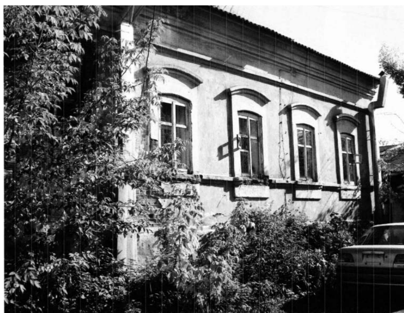
Архивное фото 4. Юго-западный фасад.
