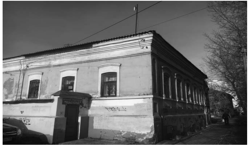
Фрагмент бокового фасада.
