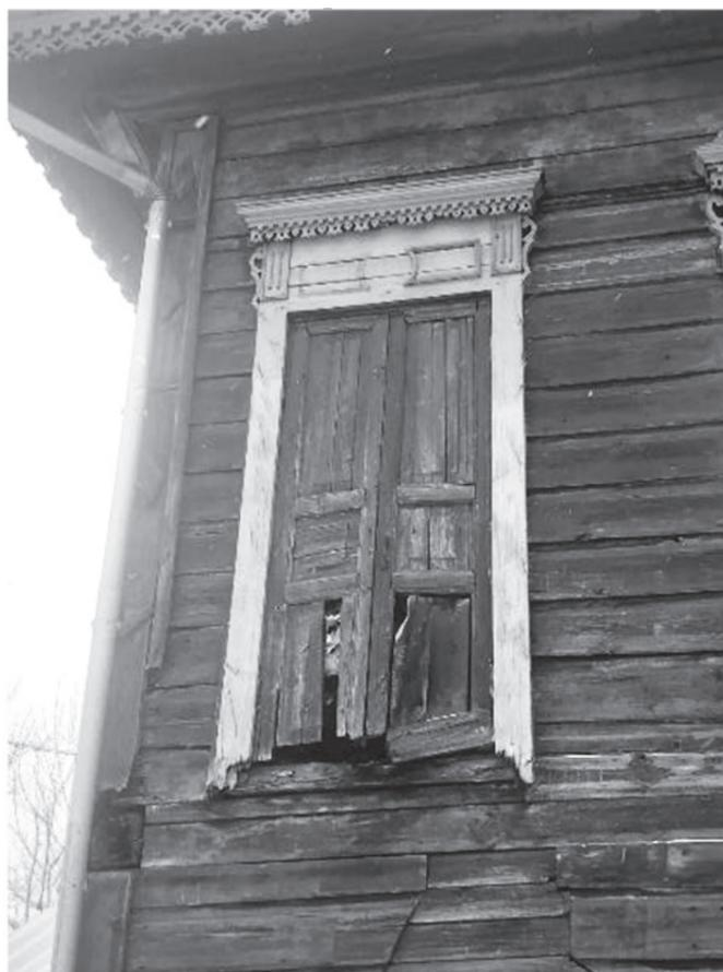
Фото 10 - Наличник дверного проема второго этажа со стороны главного фасада
