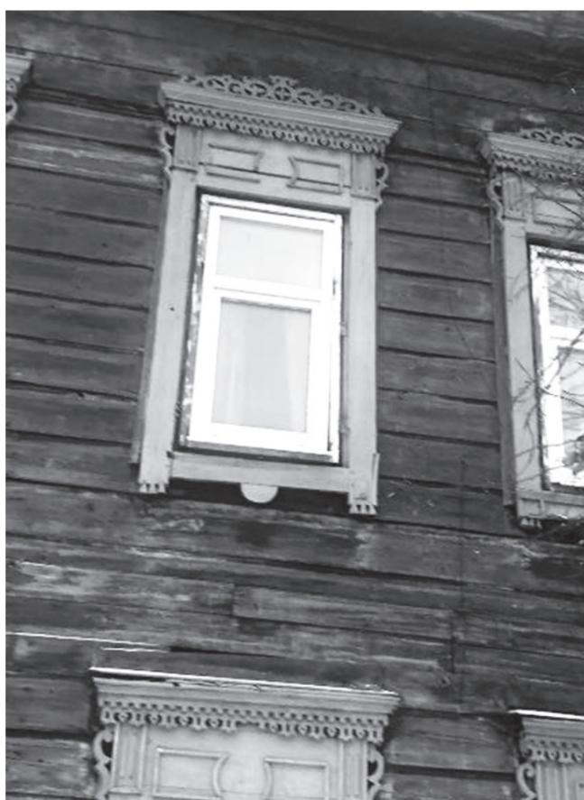
Фото 9 - Наличник оконного проема второго этажа со стороны главного фасада
