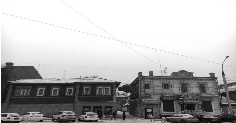
Общий вид зданий.
