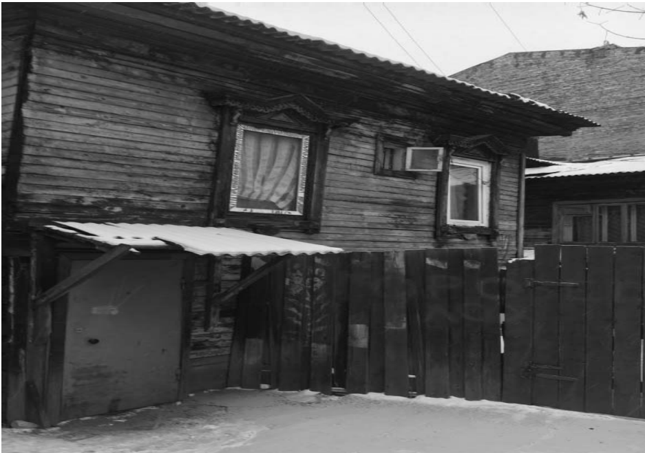
Дворовой фасад здания по адресу: г. Иркутск, ул. Тимирязева, 30 а
