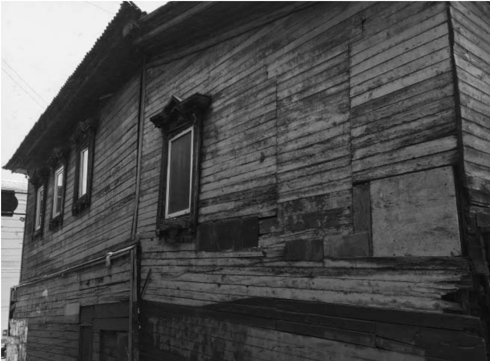
Боковой фасад здания по адресу: г. Иркутск, ул. Тимирязева, 30 а
