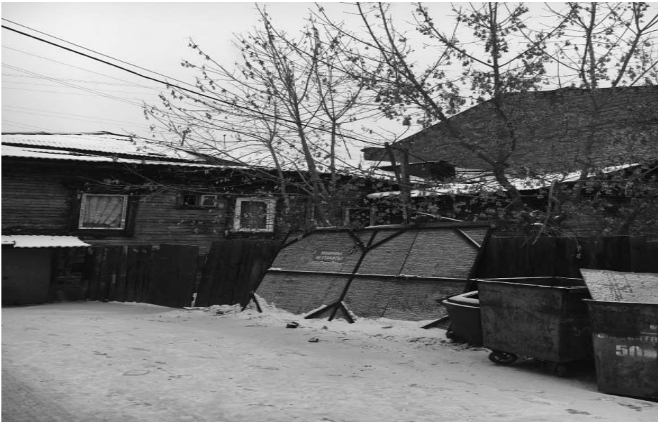
Дворовой фасад здания по адресу: г. Иркутск, ул. Тимирязева, 30 а
