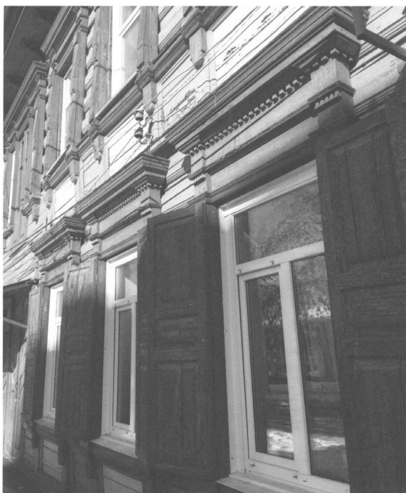
Фото 4. Оформление оконных проемов лит. А
