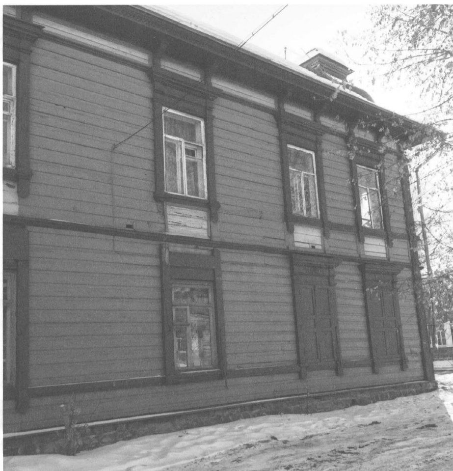
Фото 10. Торцевой северо-западный фасад лит. А
