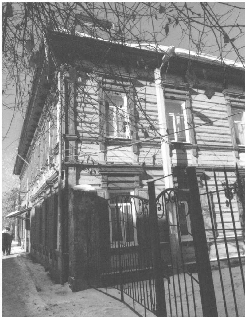
Фото 8. Торцевой юго-восточный фасад лит. А
