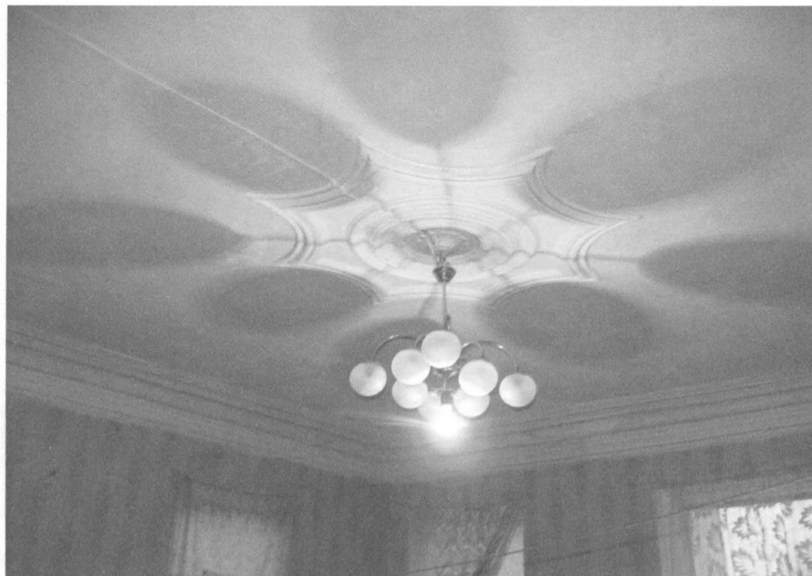
Фото 15. Потолочные тяги и розетка
