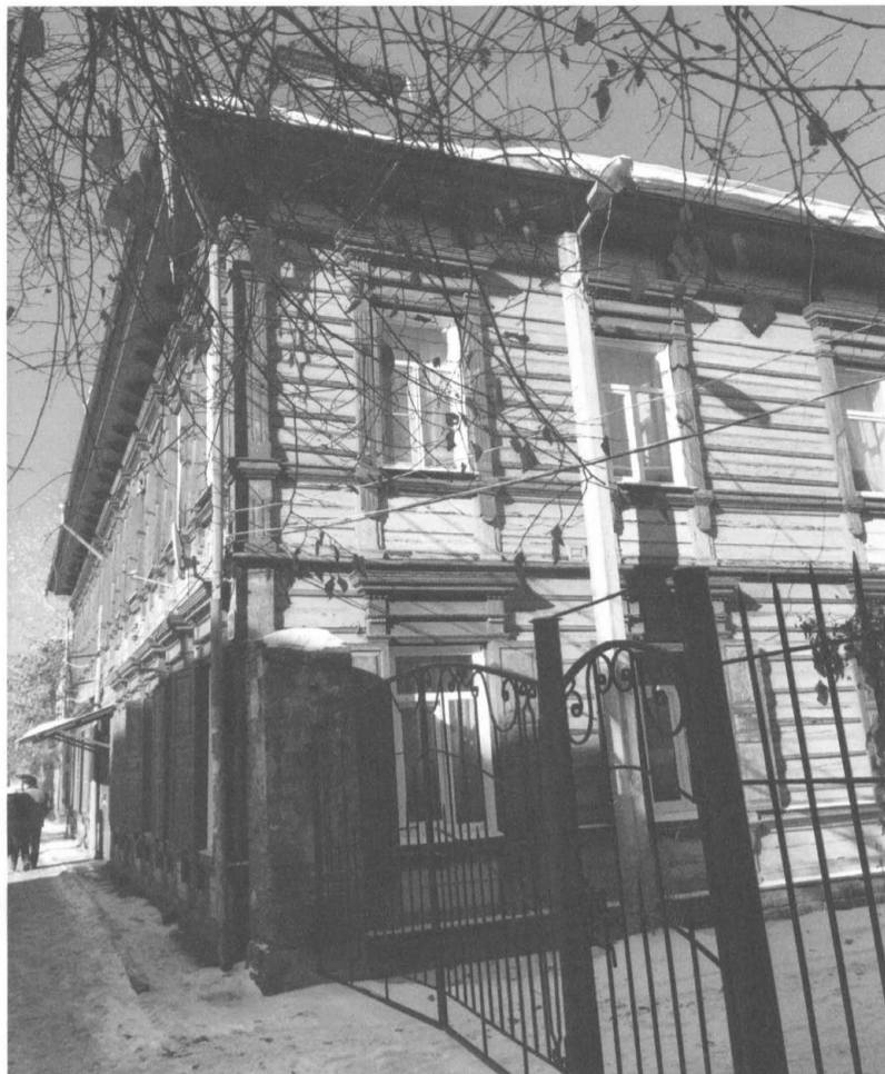
Фото 8. Торцевой юго-восточный фасад лит. А
