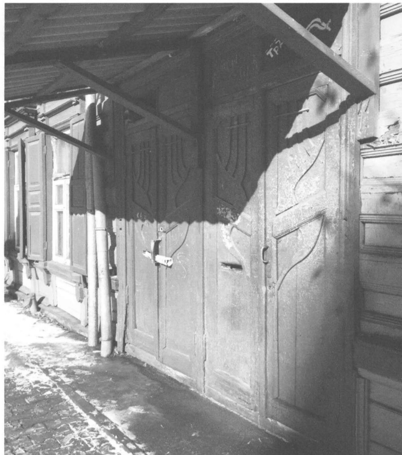
Фото 5. Оформление дверных проемов на главном фасаде лит. А
