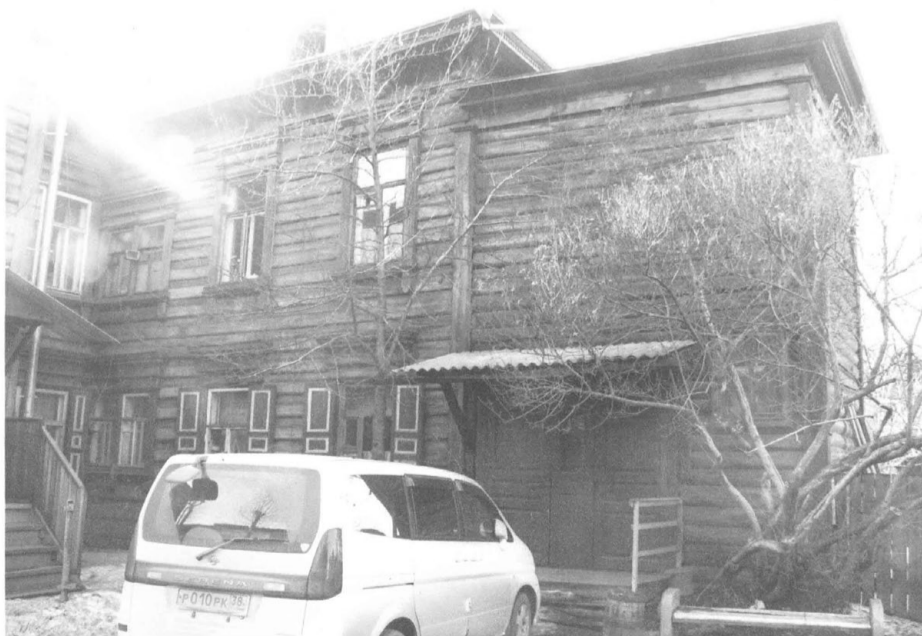
Фото 9. Дверные проемы в прирубе А3
