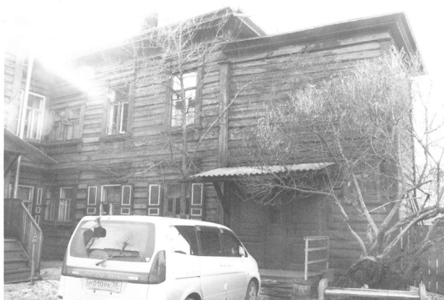
Фото 9. Дверные проемы в прирубке А3
