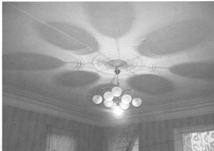
Фото 15. Потолочные тяги и розетка
