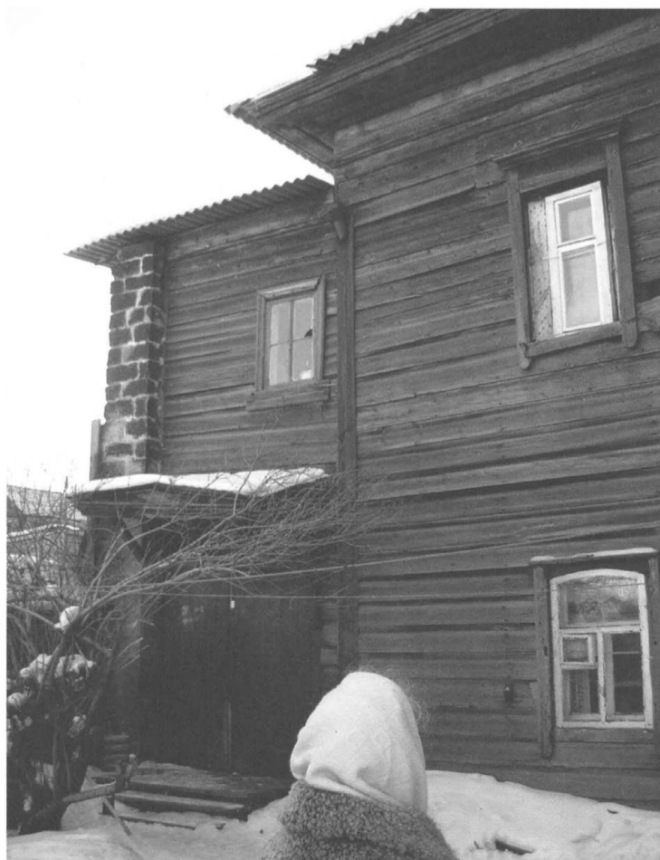
Фото 14. Дворовой фасад лит. Б
