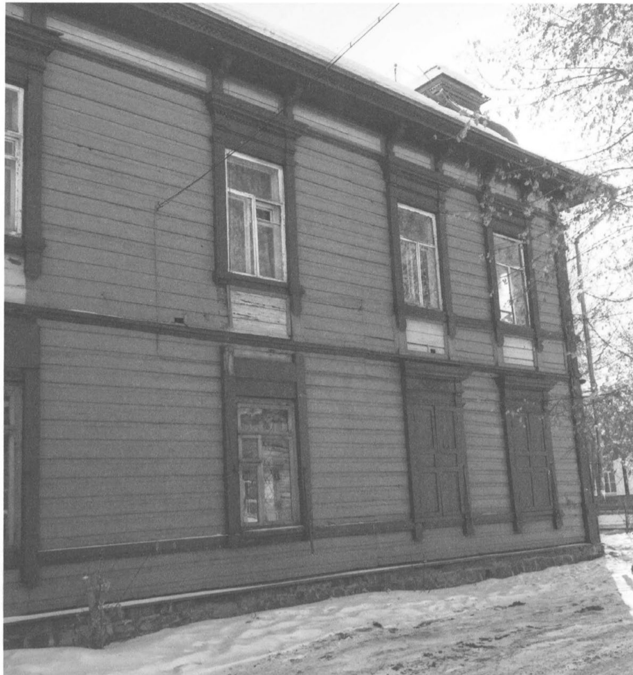
Фото 10. Торцевой северо-западный фасад лит. А
