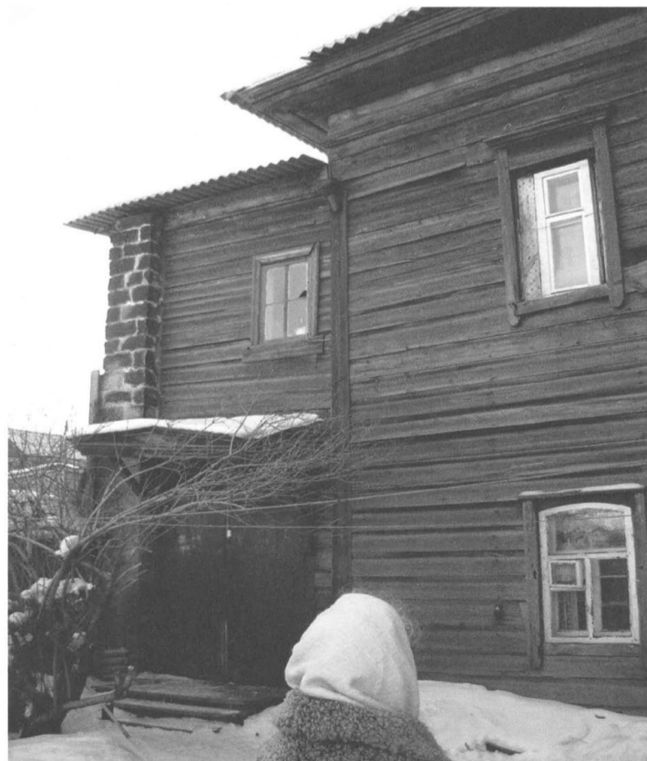
Фото 14. Дворовой фасад лит. Б
