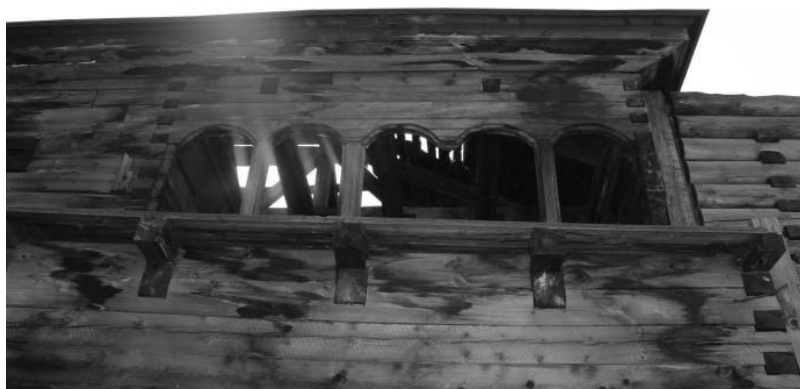
Фото Н.В. Шастун, август 2018 г. Вид на галерею с северо-запада.
