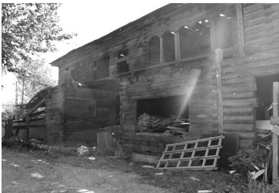
Фото Н.В. Шастун, август 2018 г. Боковой (северо-западный) фасад. Вид с западного угла.
