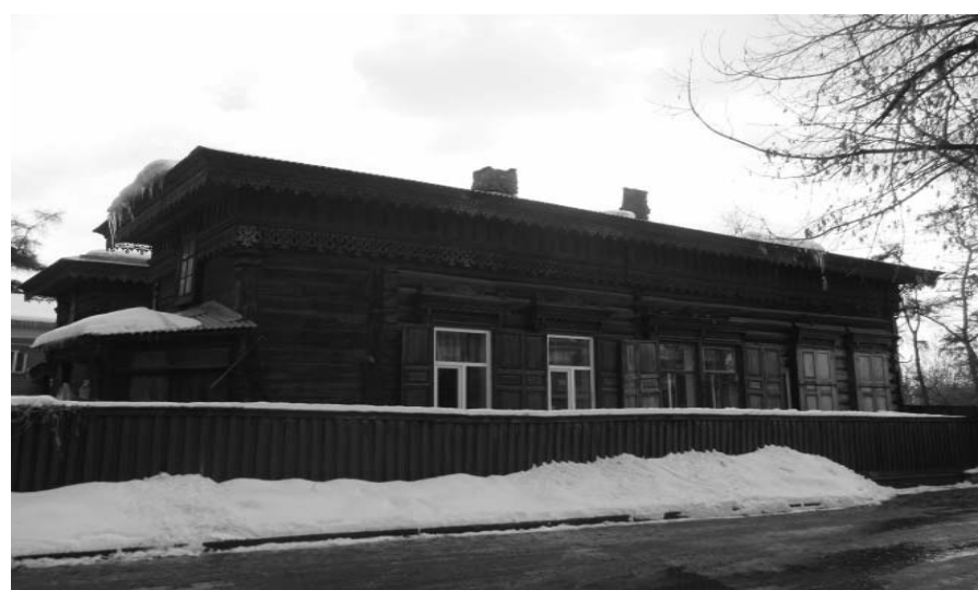
Фото 8 - Боковой (северо-западный) фасад основного объема, дворового жилого и хозяйственного прирубов
