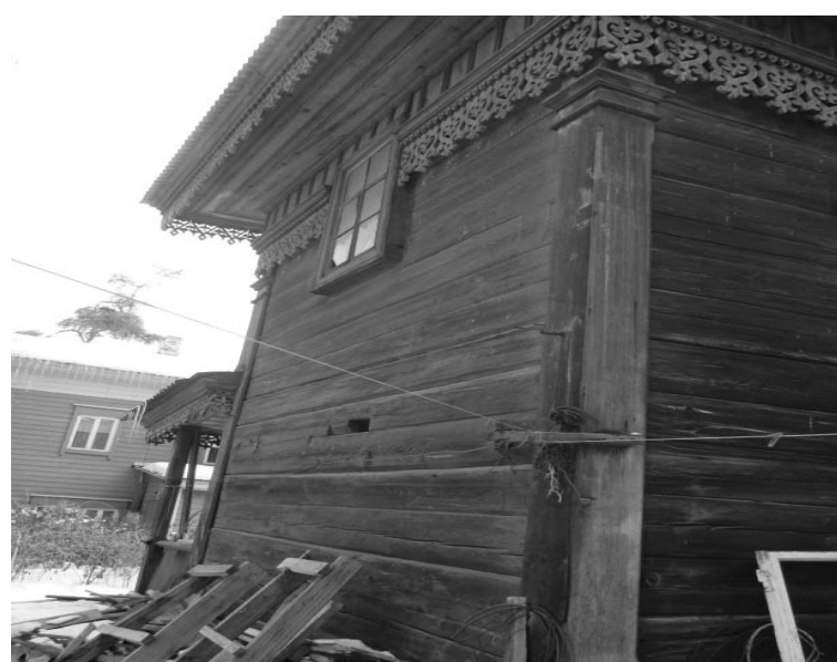
Фото 18 - Правый фланговый дворовый хозяйственный прируб. Оконный проем, декор фриза, карниза
