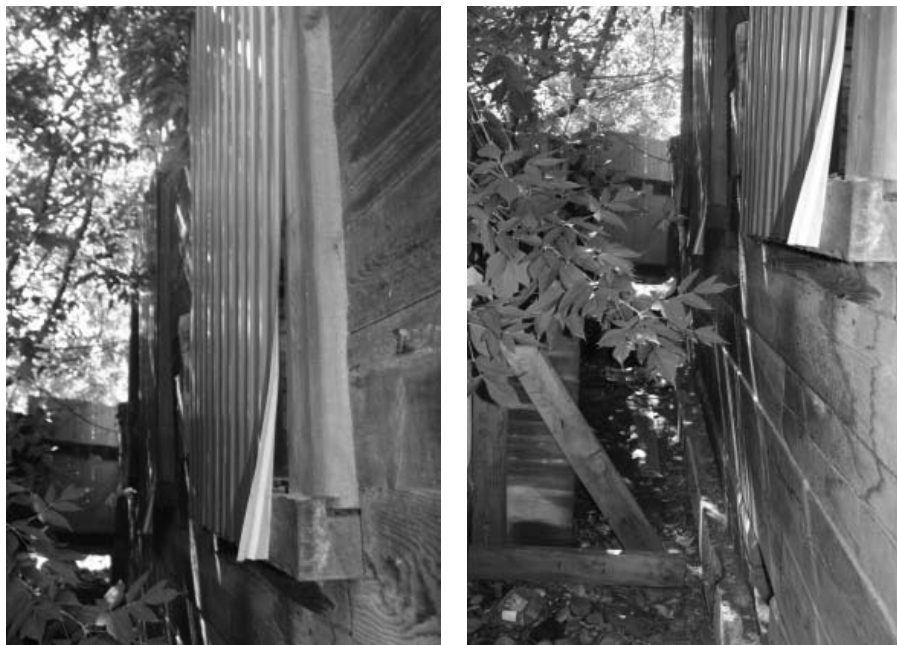
Фото Н.В. Шастун, август 2018 г. Оконные проемы главного (северо-восточного) фасада.
