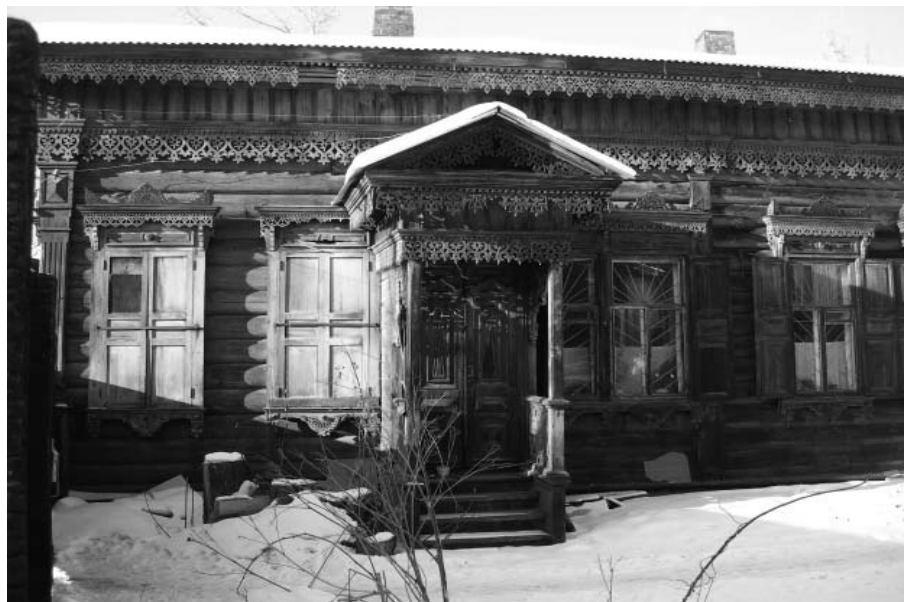
Фото 2 - Боковой (юго-восточный) фасад жилого дома (лит. А). Основной объем
