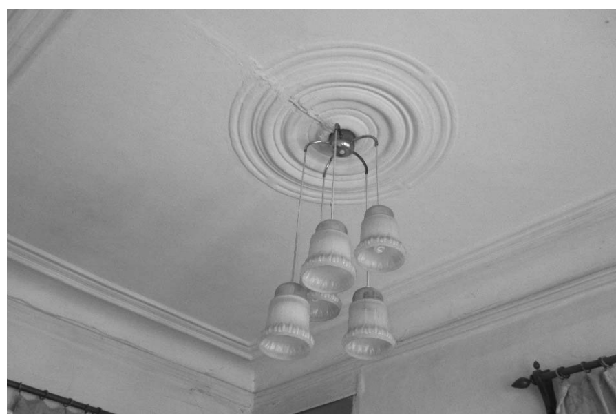
Фото 22 - Потолочные тяги, круглая розетка в пом. 5
