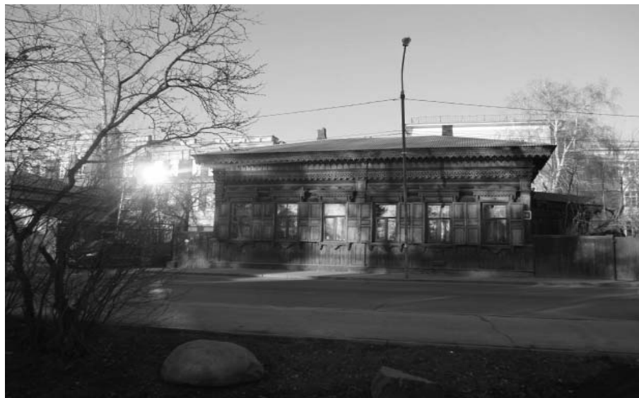
Фото 1 - Главный (юго-западный) фасад жилого дома (лит. А). Основной объем
