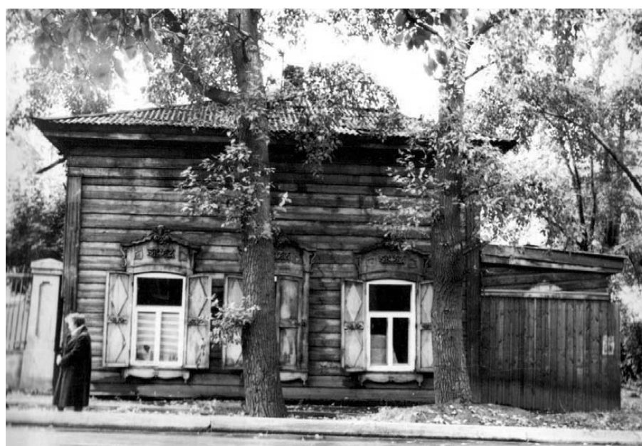
Фото из фотоальбома ТПО «Иркутскархпроект» (архив службы), 1992 г. Главный фасад.
