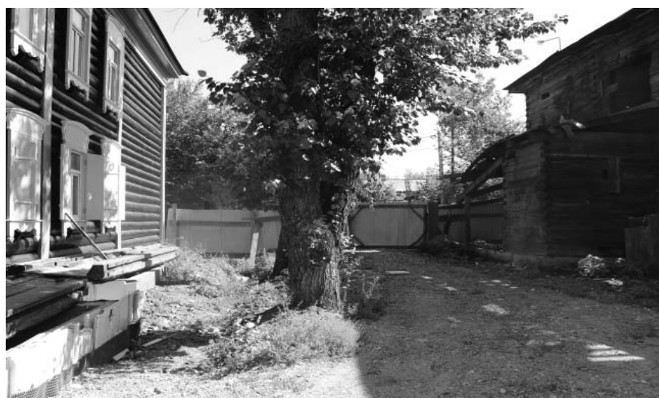
Фото Н.В. Шастун, август 2018 г. Северо-западная часть территории здания. Вид с юго-запада.
