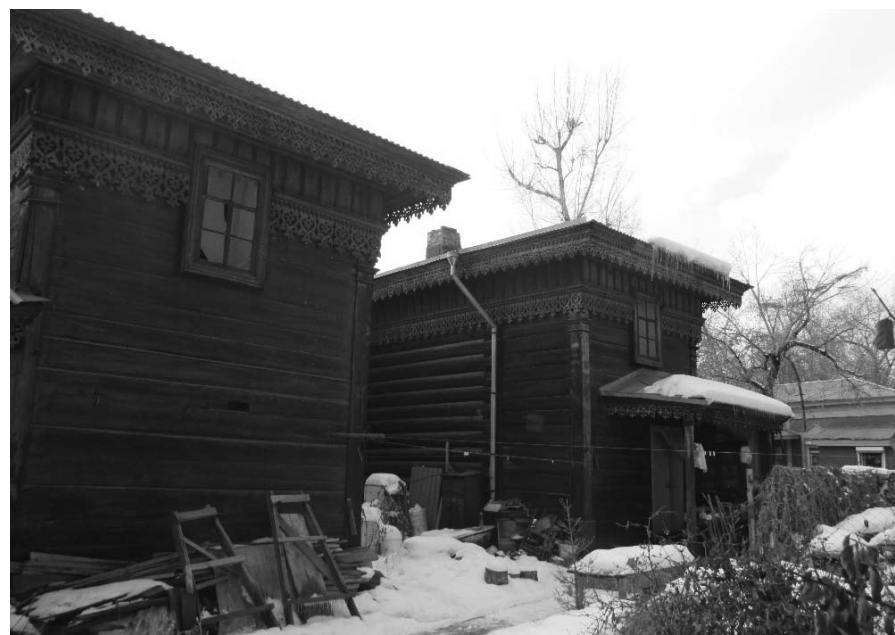
Фото 5 - Дворовые (северо-восточные) фасады дворовых хозяйственных прирубов
