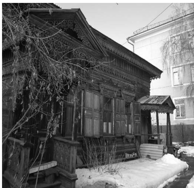
Фото 3 - Боковой (юго-восточный) фасад правого флангового дворового жилого прируба
