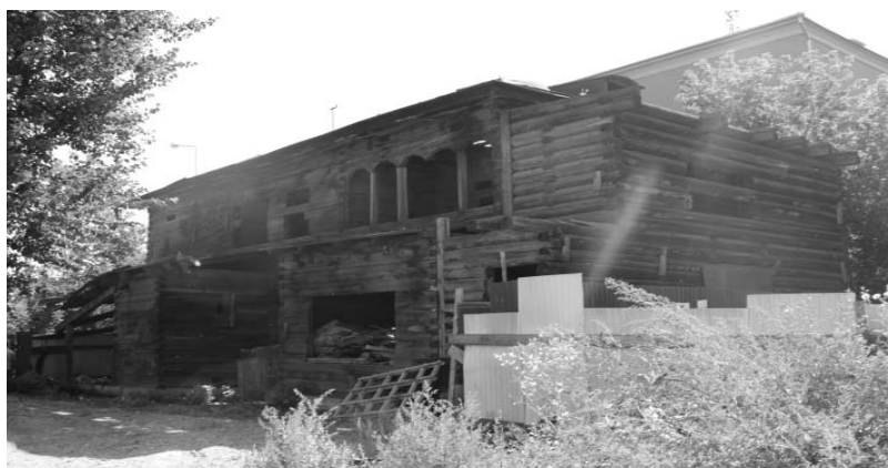
Фото Н.В. Шастун, август 2018 г. Вид на здание с запада. Дворовый (юго-западный) прируб.
