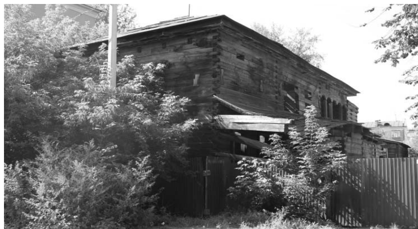
Фото Н.В. Шастун, август 2018 г. Общий вид здания с северного угла.
