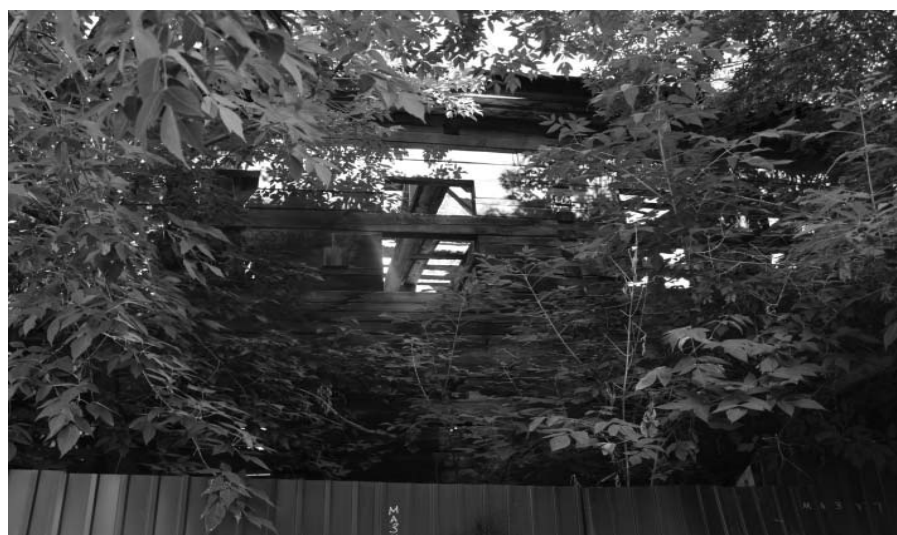
Фото Н.В. Шастун, август 2018 г. Фрагмент бокового (юго-восточного) фасада.
