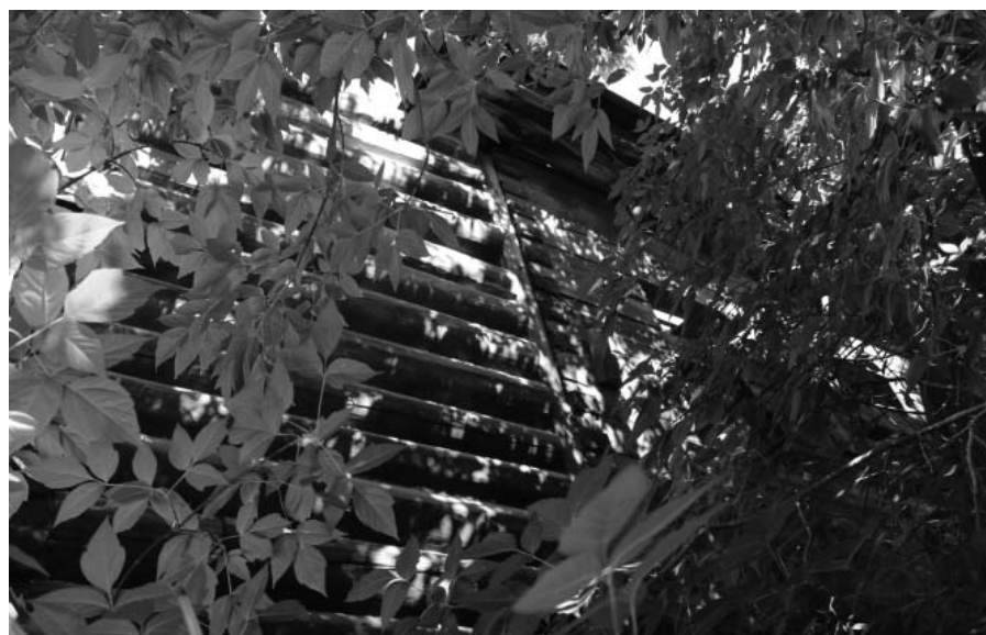
Фото Н.В. Шастун, август 2018 г. Фрагмент бокового (юго-восточного) фасада.
