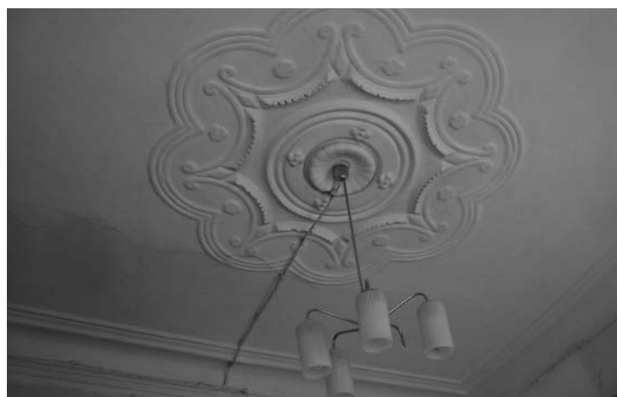
Фото 23 - Потолочные тяги, фигурная розетка в пом. 6
