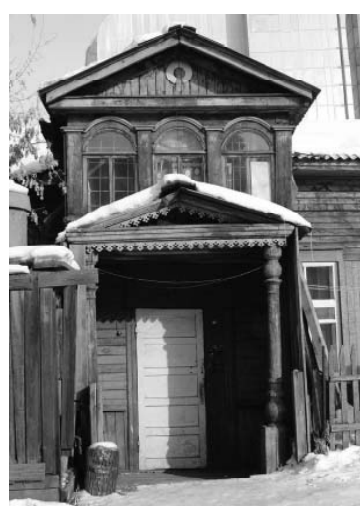
Фото 4 - Фрагмент юго-западного фасада. Входной прибор со светелкой
