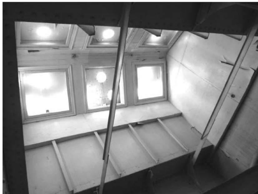
ПРИЛОЖЕНИЕ 2. ФОТОФИКСАЦИЯ. Фото 34 Машинное отделение. Фото автора 2013г
