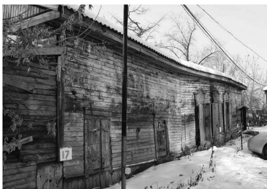
Фото 8 - Северо-восточный фасад. Вид с восточного угла
