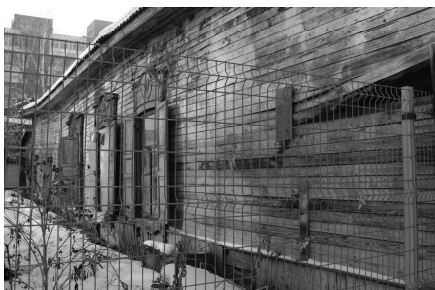
Фото 7 - Северо- восточный фасад (вид с северного угла)
