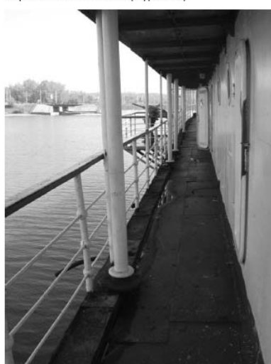
ПРИЛОЖЕНИЕ 2. ФОТОФИКСАЦИЯ. Фото 12,13 Вид нижней палубы по левому и правому борту судна. Фото автора 2013г. Покрытие – листовой металл (подлинный)
