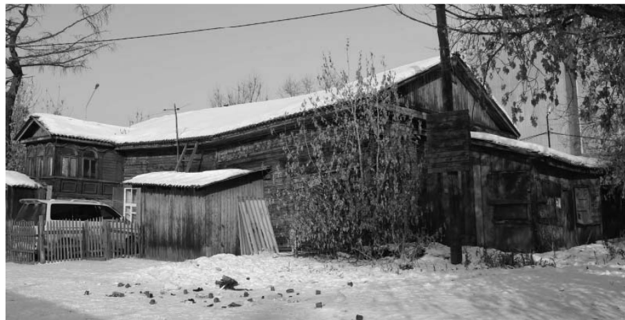
Фото 11 - Общий вид дома с южного угла.
