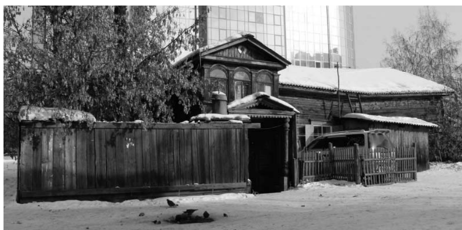
Фото 2 - Боковой (юго-западный) фасад.
