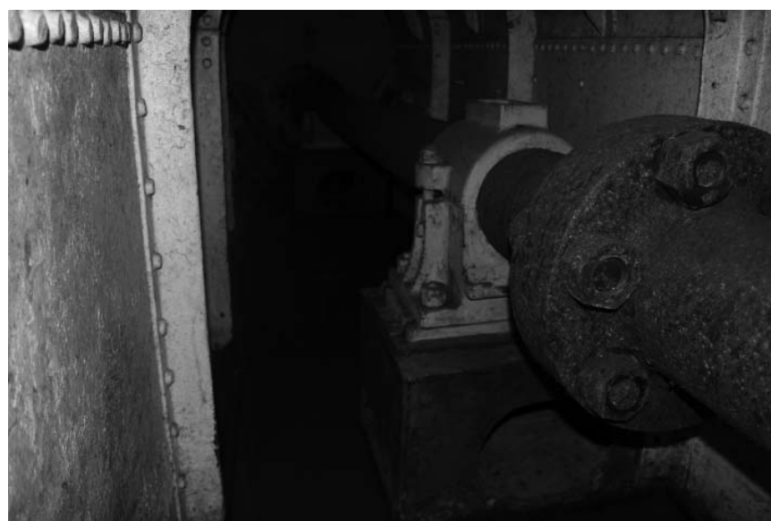
Фото А.А. Жильцов, август 2018 г. Фрагмент вала, вращающего гребной винт.
