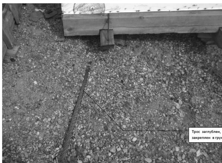
ПРИЛОЖЕНИЕ 2. ФОТОФИКСАЦИЯ. Фото 7. Крепление швартовочных тросов на береговом грунте. Фото автора 2013г.
