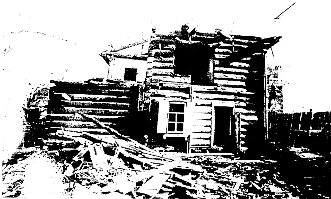
Фото 12. Пер. Черемховский, 4, лит. А. Юго-западный фасад. 1993 г.
