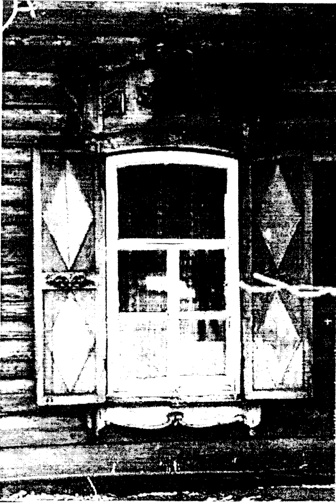
Фото 14. Пер. Черемховский, 4, лит. А. Оконный наличник северо-восточного фасада. Фото Б. Михайлова, 1983 г.
