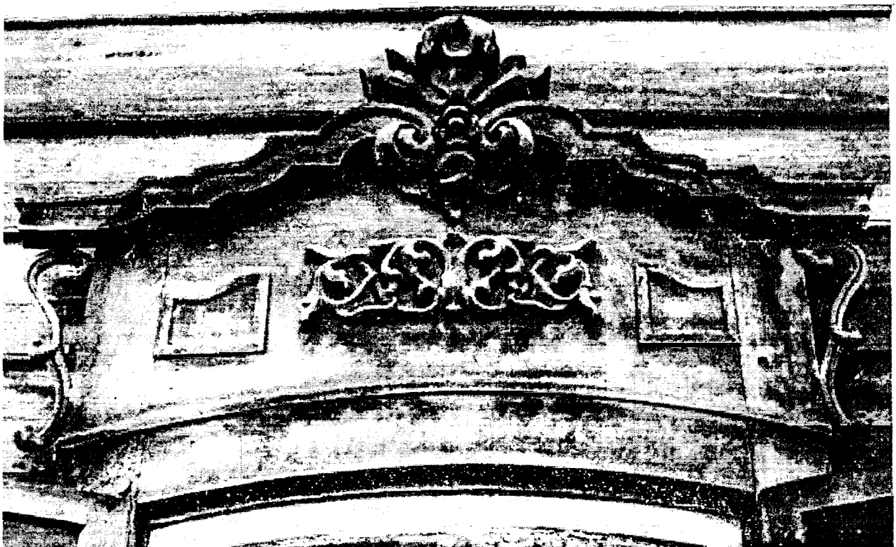
Фото 15. Пер. Черемховский, 4, лит. А. Верхняя часть оконного наличника северо-восточного фасада. Фото В. Щербина, нач. 1980-х гг.
