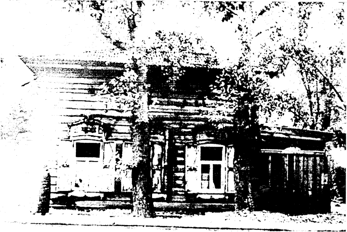
Фото 1. Пер. Черемховский, 4, лит. А. Главный (северо-восточный) фасад. Фото 1992 г.
