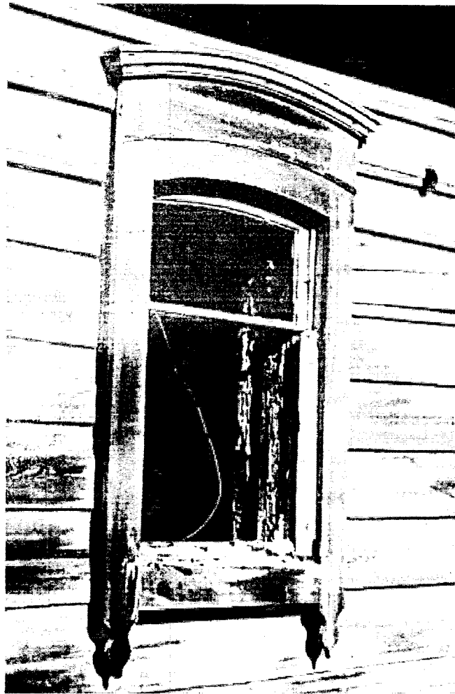
Фото 18. Пер. Черемховский, 4, лит. А. Наличник оконного проема антресольного этажа юго-восточного фасада. Фото 1993 г.
