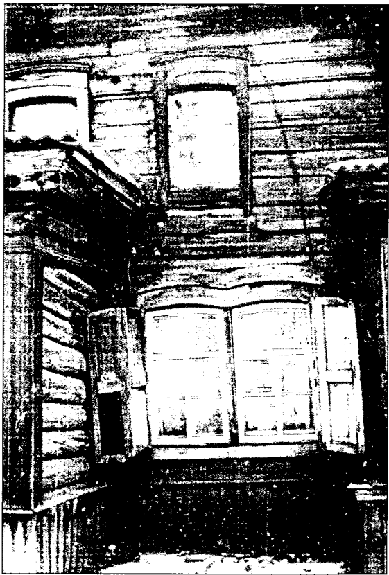
9. Пер. Черемховский, 4, лит. А. Фрагмент северо-западного фасада. Фото Б. Михайлова, 1983 г.
