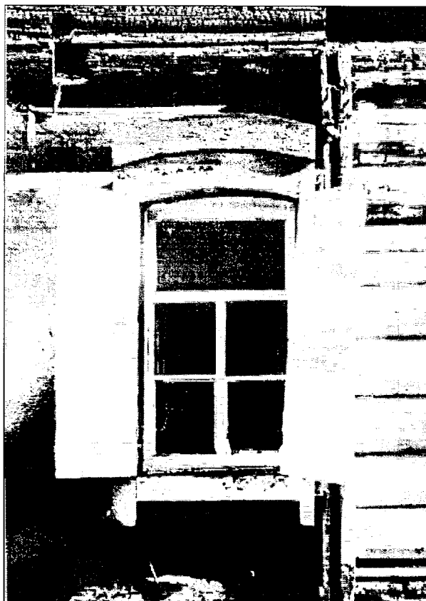
Фото 19. Пер. Черемховский, 4, лит. А. Наличник оконного проёма 1-го этажа юго-западного фасада. Фото 1993 г.
