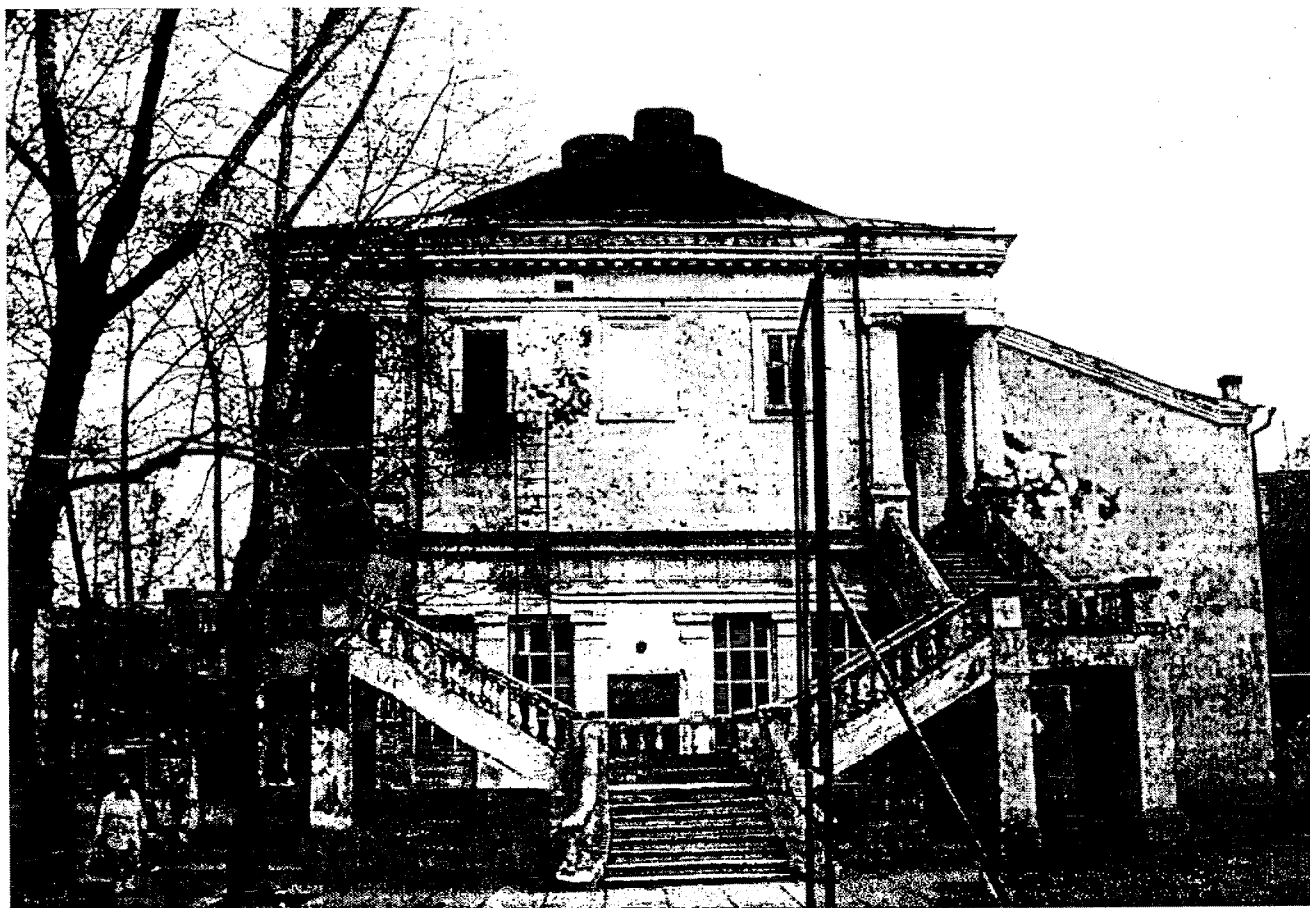
Фото 10. Северо-восточный фасад. Фото 2003 г.
