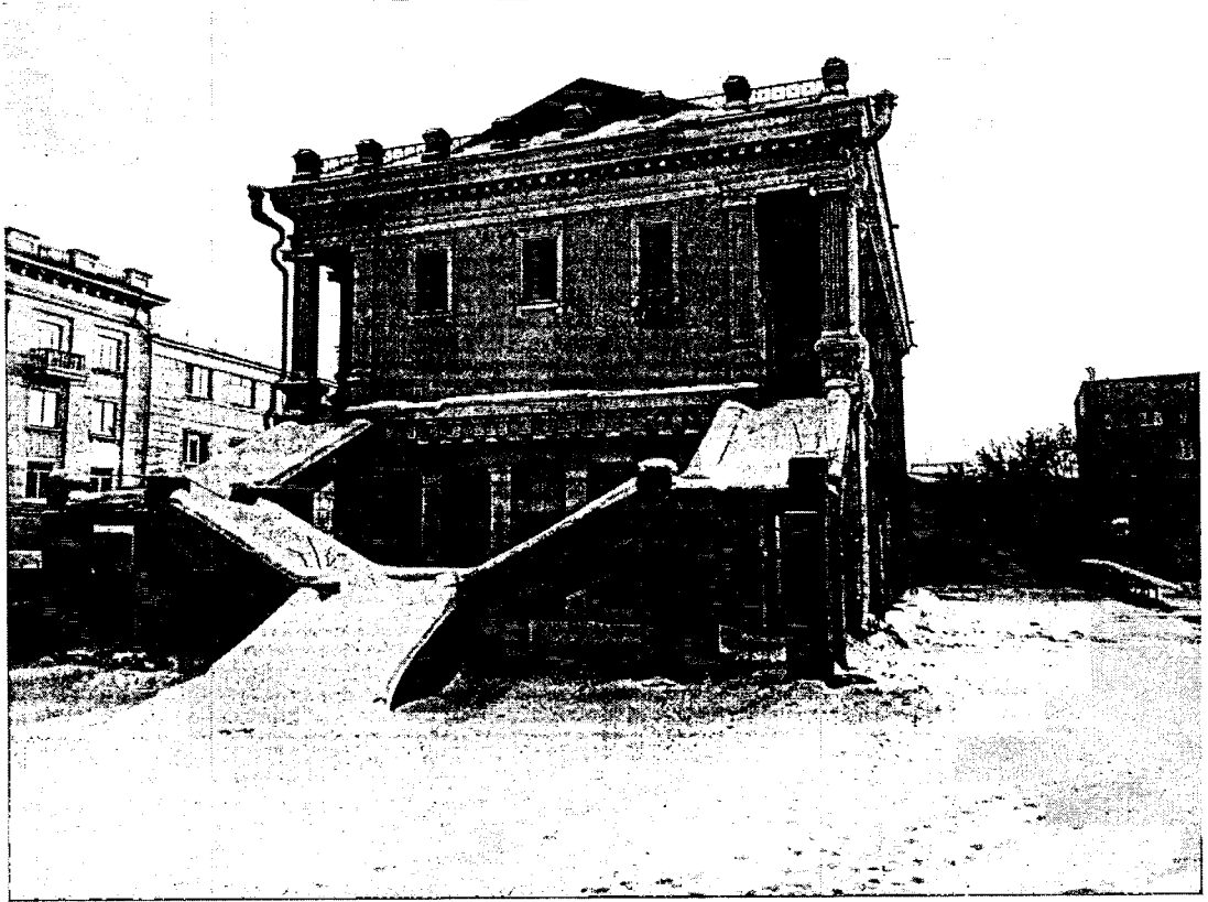
Фото 11. Северо-восточный фасад. Фото 2023 г.
