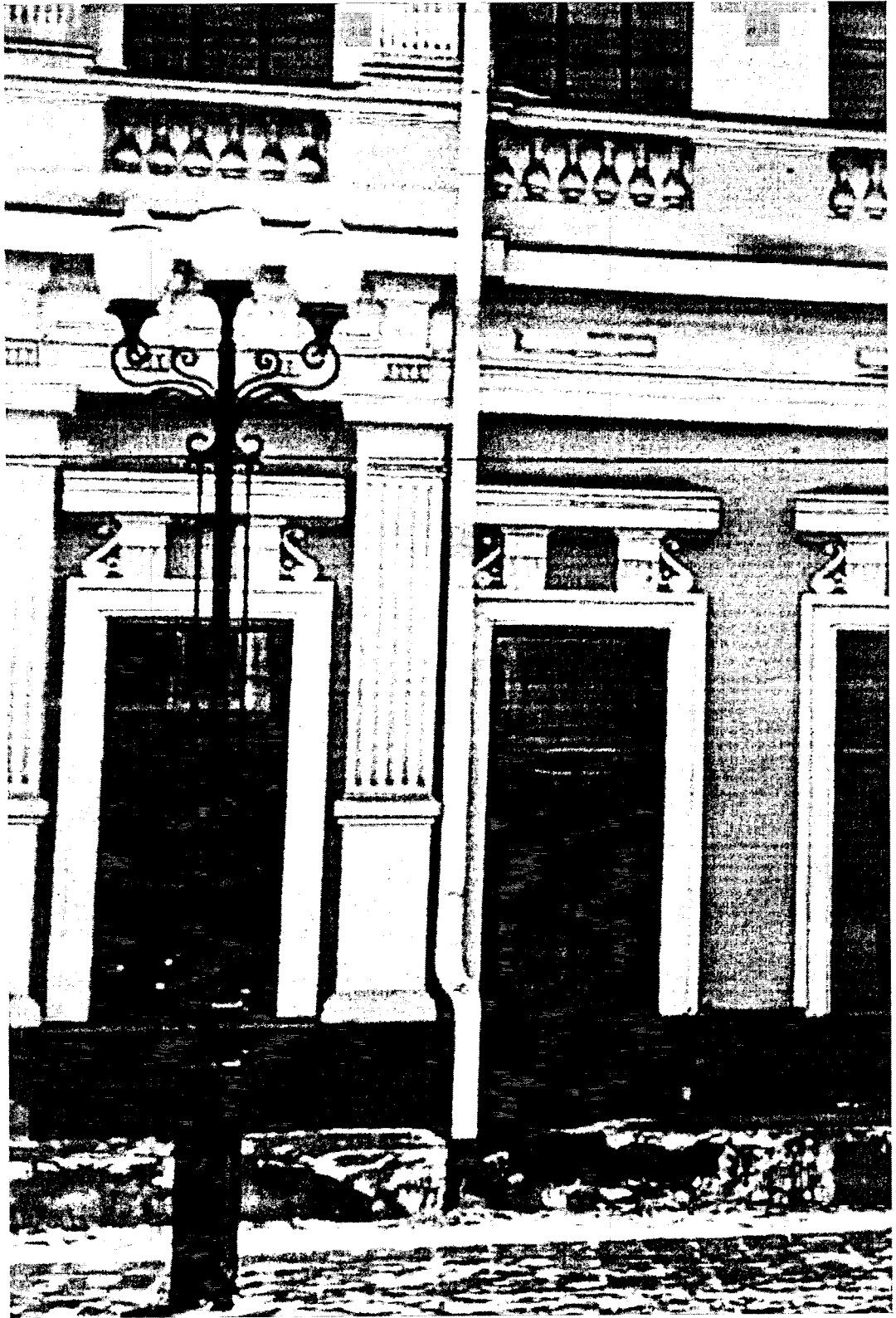
Фото 18. Фрагмент главного юго-восточного фасада. Межэтажный пояс. Окна и наличники 1 этажа. Пилястры 1 этажа. Цоколь. Фото 2023 г.
