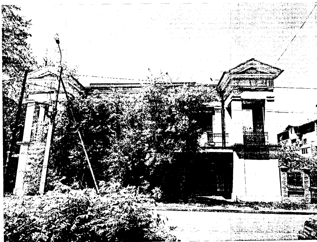
Фотография № 5. Вид фрагмент фасада объекта культурного наследия
