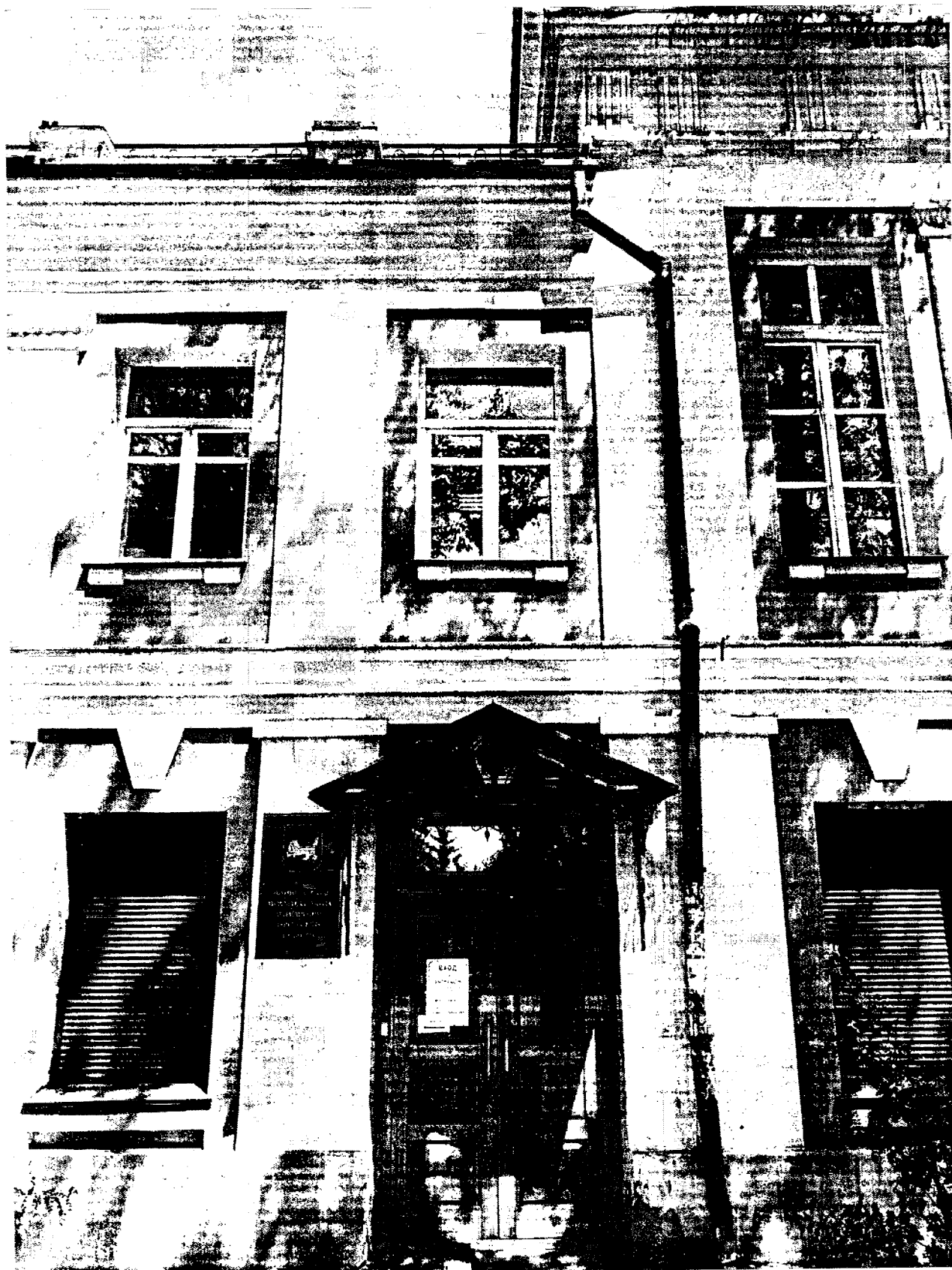
Фотография № 3. Вид фрагмент фасада объекта культурного наследия
