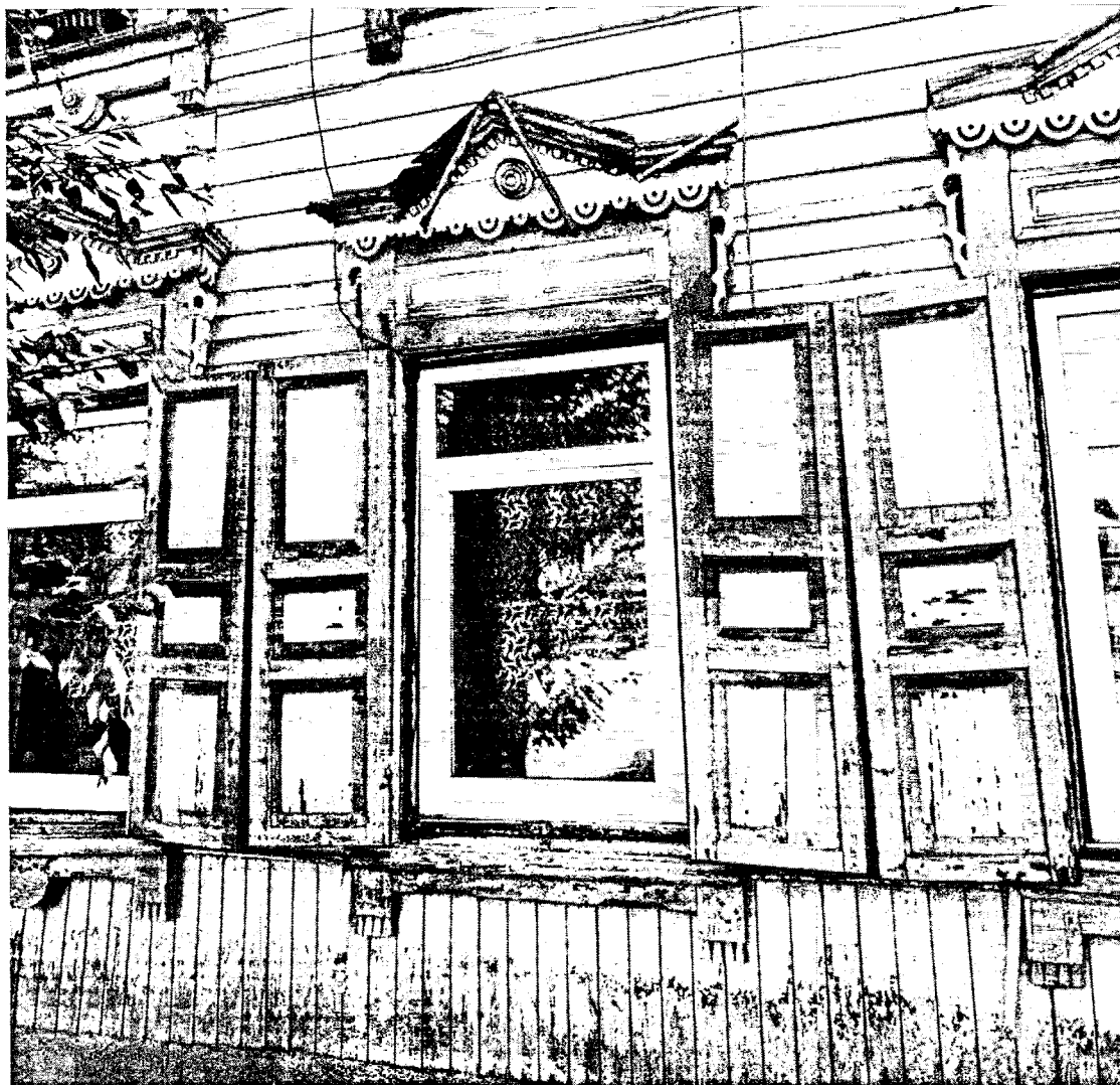
Фотография № 3. Вид на фрагмент фасада объекта культурного наследия
