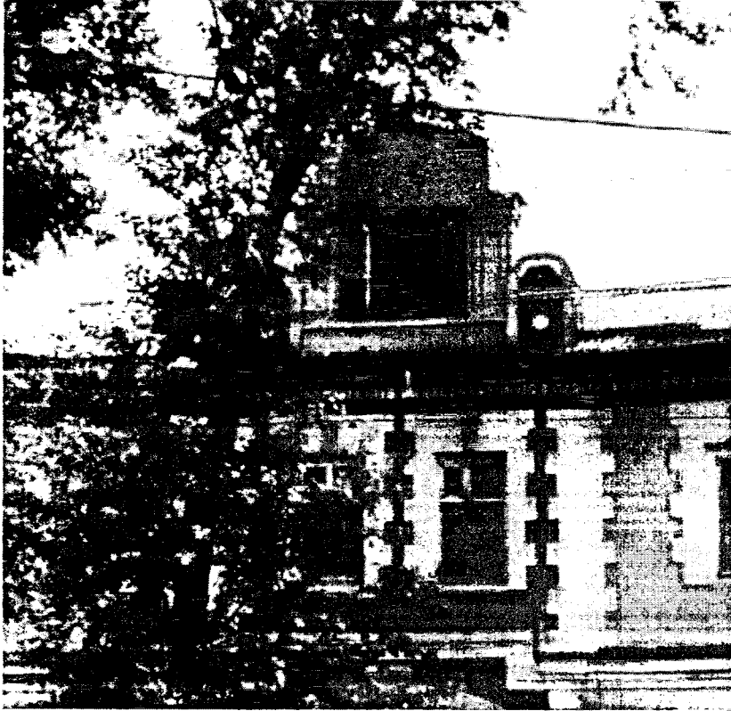
Фотография № 7. Вид на фрагмент фасада объекта культурного наследия
