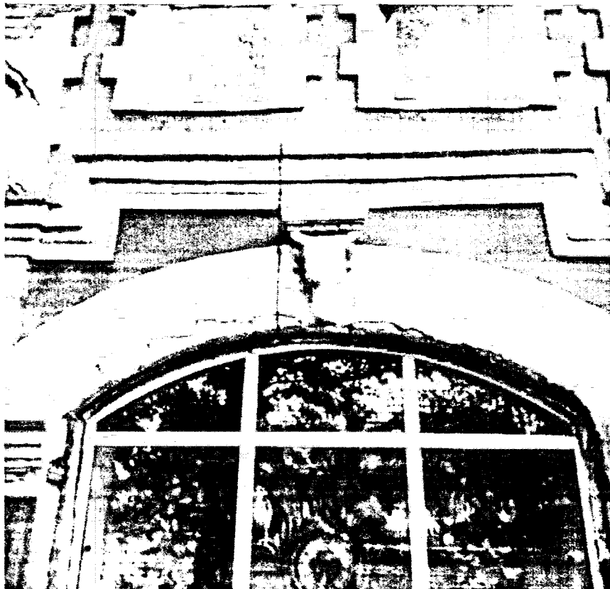
Фотография № 6. Вид на фрагмент фасада объекта культурного наследия
