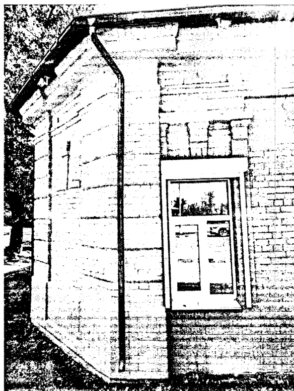
Фотография № 2. Вид с улицы Подгорной на фрагмент фасада объекта культурного наследия
