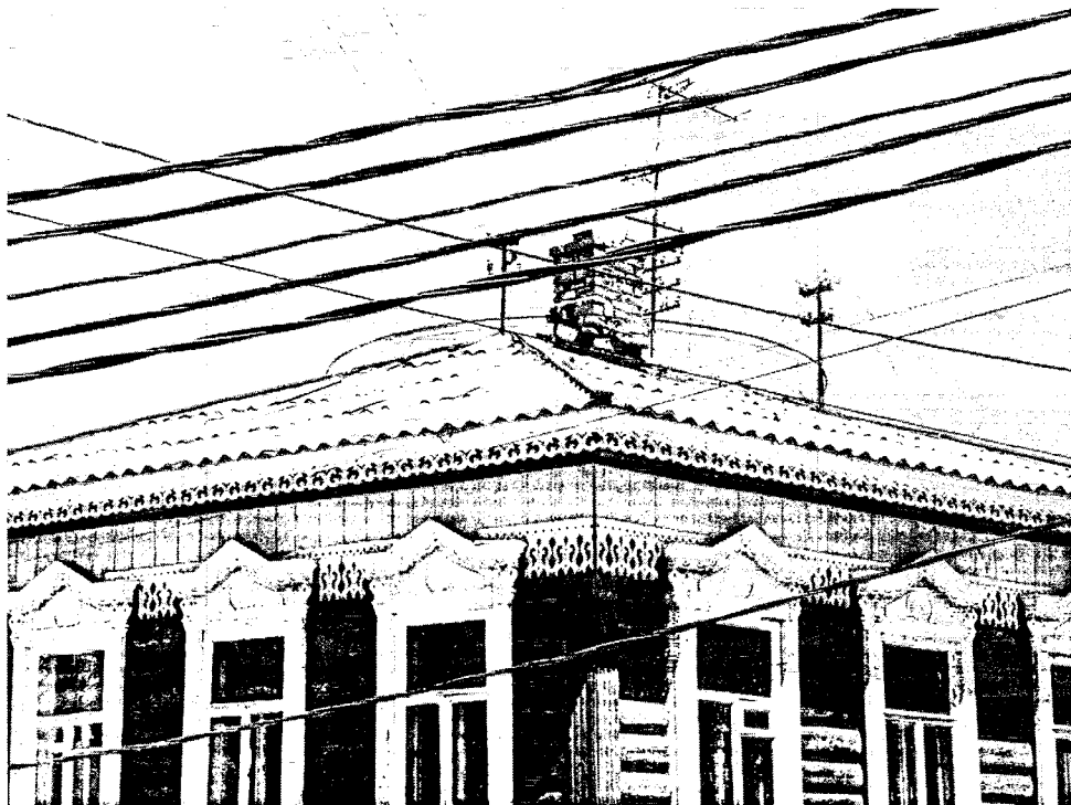
Фотография № 6. Вид с улицы Грязнова на фрагмент фасада объекта культурного наследия
