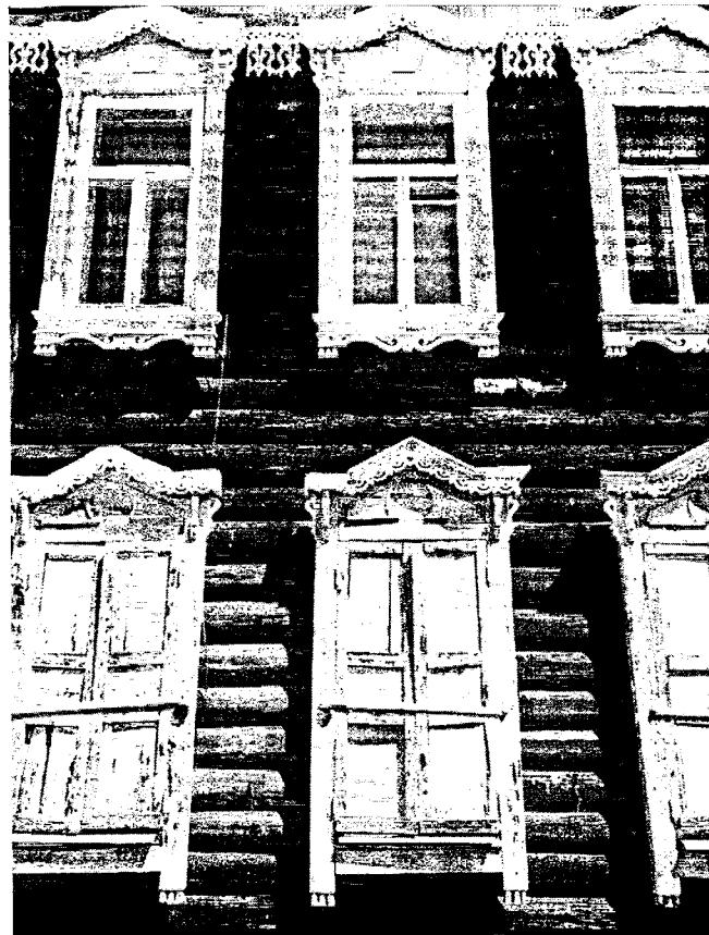
Фотография № 4. Вид с улицы Грязнова на фрагмент фасада объекта культурного наследия
