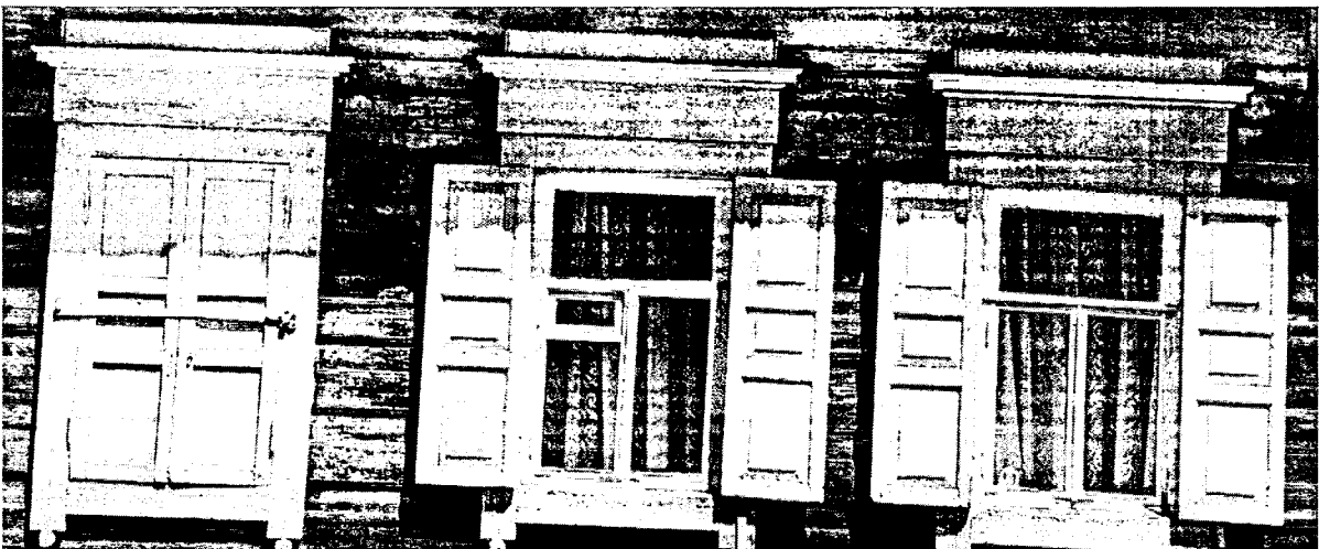
Фотография № 2. Вид на фрагмент фасада объекта культурного наследия
