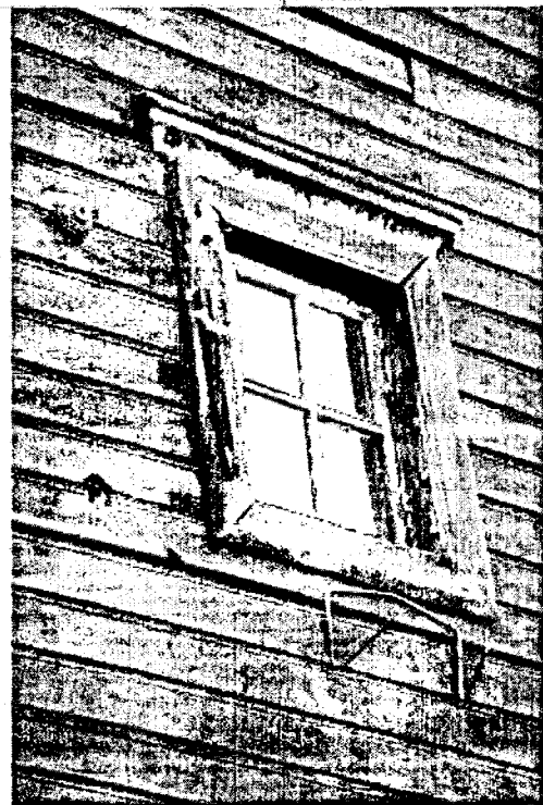
20. Небольшое окно северо-восточного фасада.
