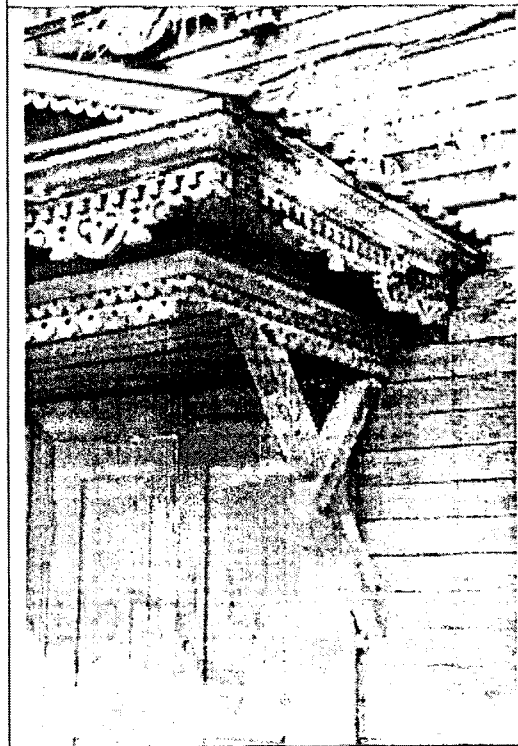
15. Навес главного входа. Крошительн.
