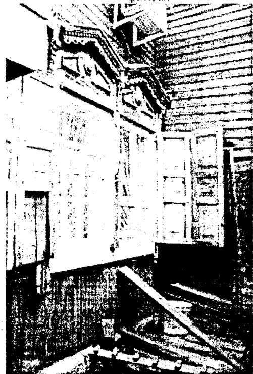
19. Сдвоенное окно северо-западного фасада.
