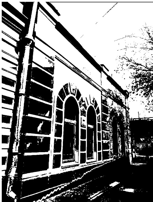
Фото 2. Фрагмент бокового (юго-восточного) фасада здания. Пристрой
