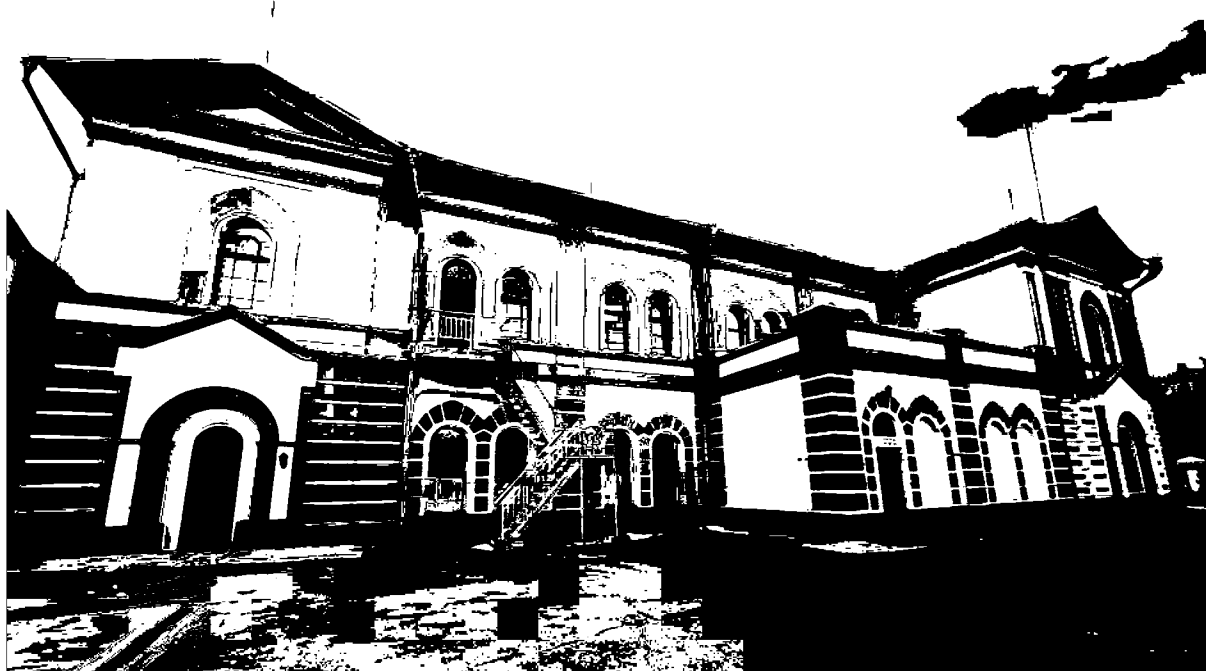
Фото 3. Вид с севера на боковой (северо-западный) фасад здания
