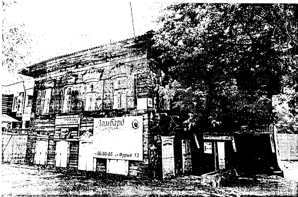
Фото 1. Главный юго-западный фасад дома по улице Фурье
