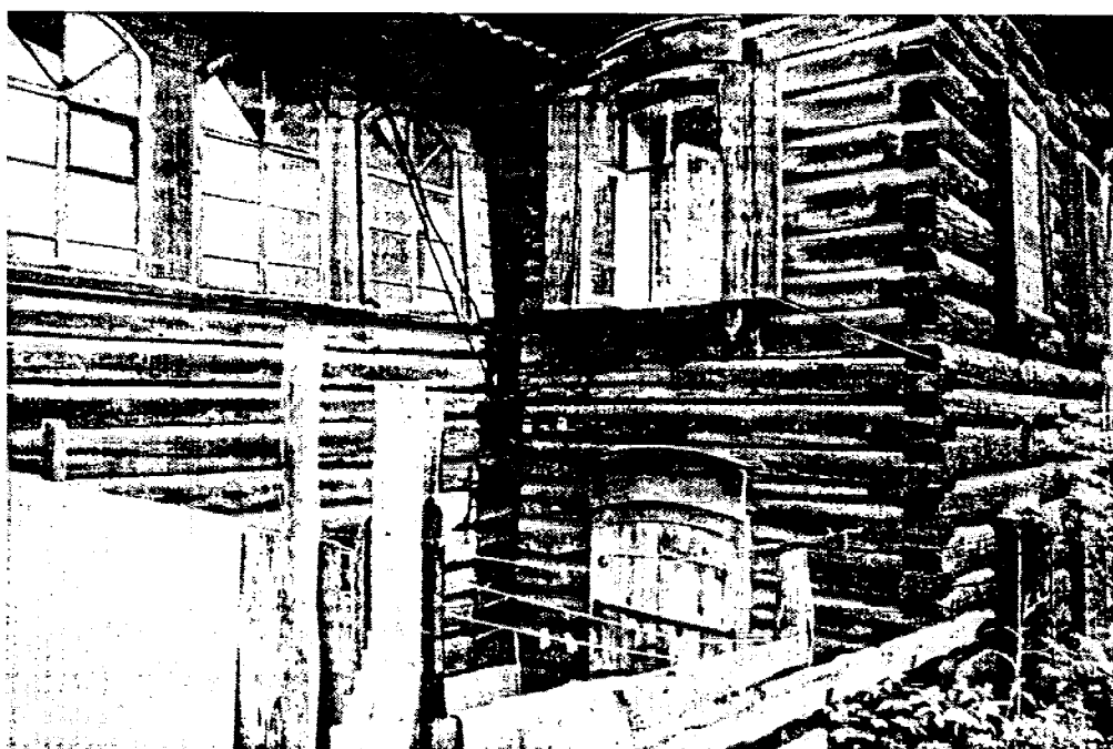
Фото 4. Фрагмент северо-восточного фасада
