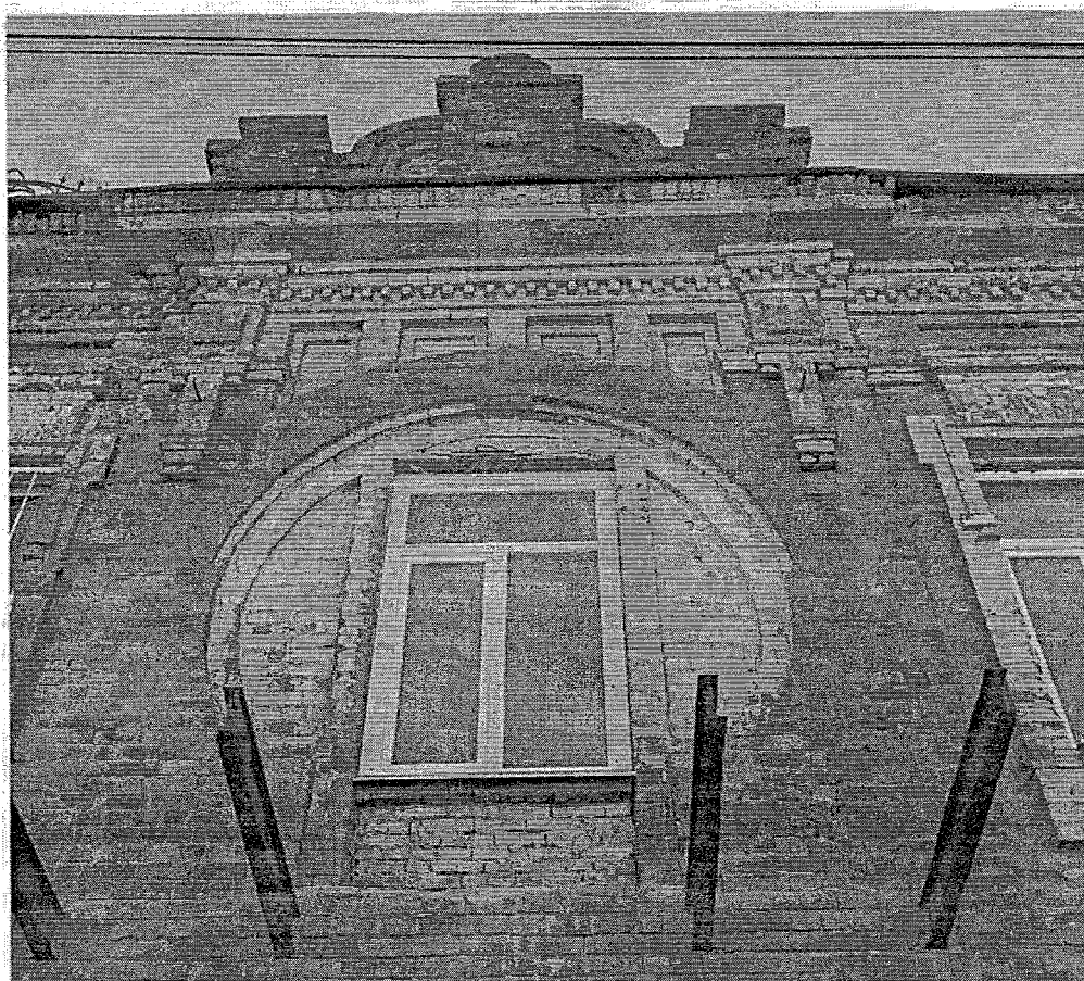
Фотография № 5. Вид фрагмент фасада объекта культурного наследия
