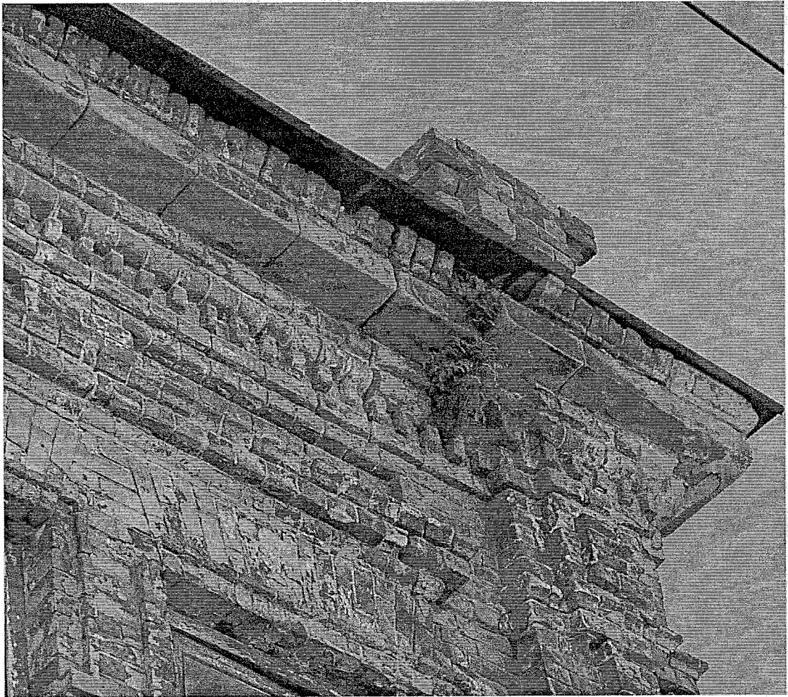
Фотография № 7. Вид фрагмент фасада объекта культурного наследия
