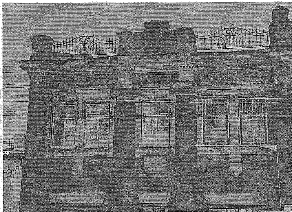
Фотография № 6. Вид фрагмент фасада объекта культурного наследия
