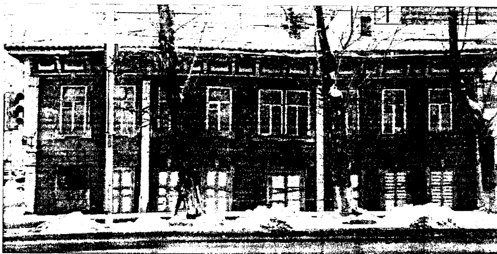
Фотография № 4. Вид на фрагмент фасада объекта культурного наследия
