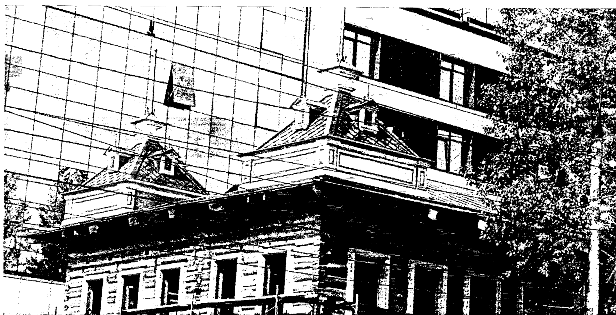
Фотография № 2. Вид на фрагмент фасада объекта культурного наследия
