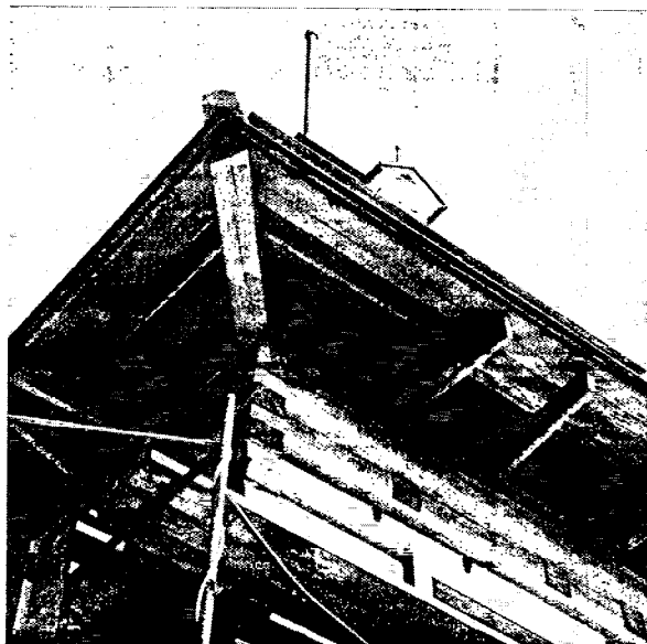
Фотография № 3. Вид на фрагмент фасада объекта культурного наследия
