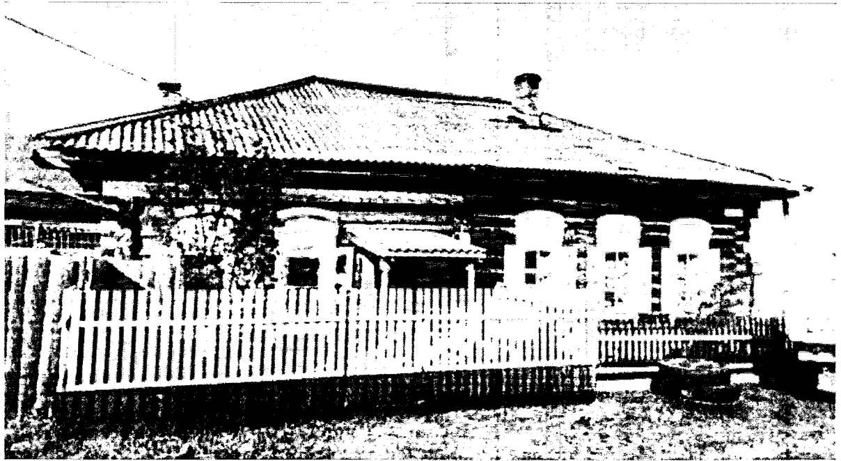
Фотография № 3. Вид на западный фасад объекта культурного наследия «Дом жилой», вторая половина XIX в., расположенного по адресу: Иркутская область, Ольхонский район, с. Косая степь, ул. Верховая, 9, лит. А, лит. А1
