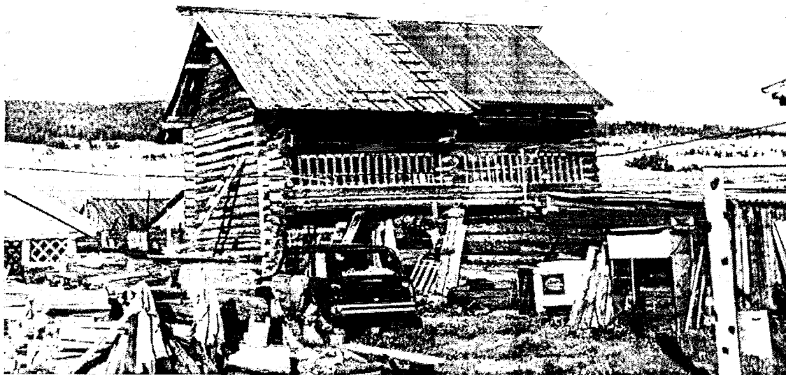
Фотография № 7. Вид на западный и северный фасады объекта культурного наследия «Амбар», вторая половина XIX в., расположенного по адресу: Иркутская область, Ольхонский район, с. Косая степь, ул. Верховая, 9, лит. Г1
