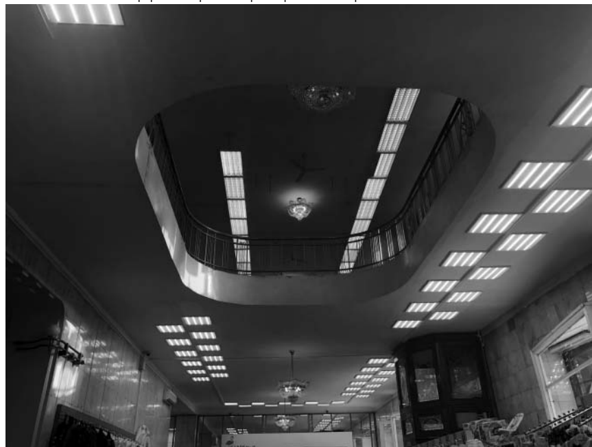
Интерьер. Овальный проем в перекрытии над первым этажом.
