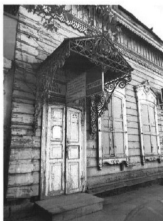
2. Фрагмент северо-западного фасада здания. Вход в здание. Автор снимка: Кравченко В.И. Дата съемки: июнь 2017 г.
