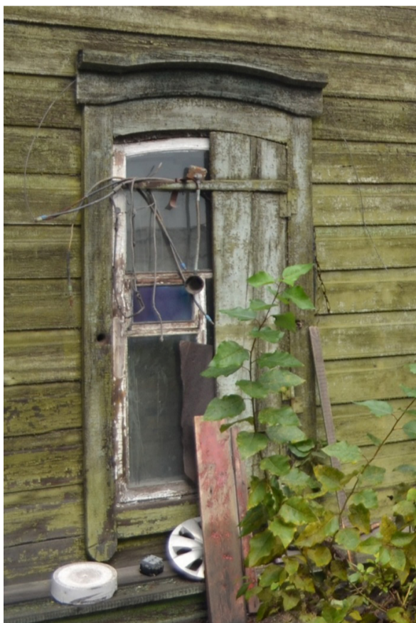
Фото 7. Наличник окна бокового (юго-восточного) фасада.
