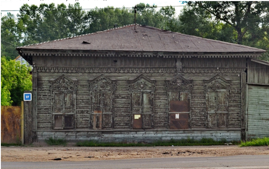
Фото 3. Главный (юго-западный) фасад.
