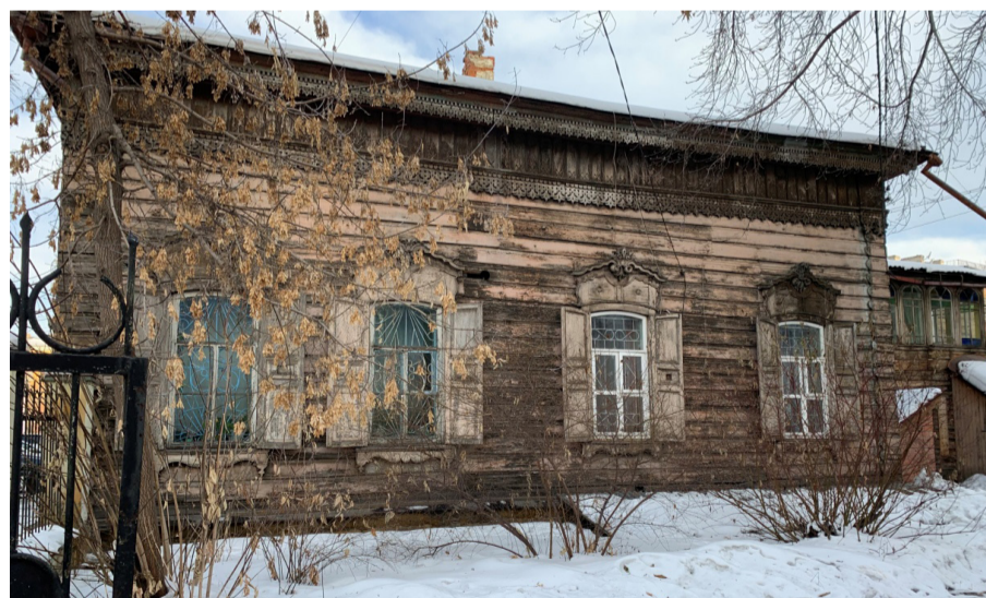
Общий вид на боковой (юго-западный) фасад жилого дома (лит. А).
