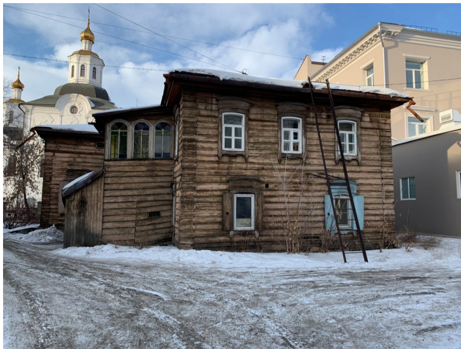
Общий вид на дворовый (юго-восточный) фасад жилого дома (лит. А).
