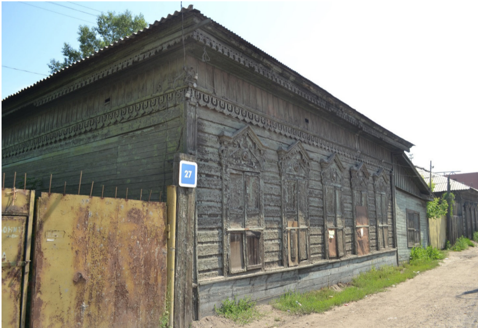
Фото 2. Общий вид объекта культурного наследия.
