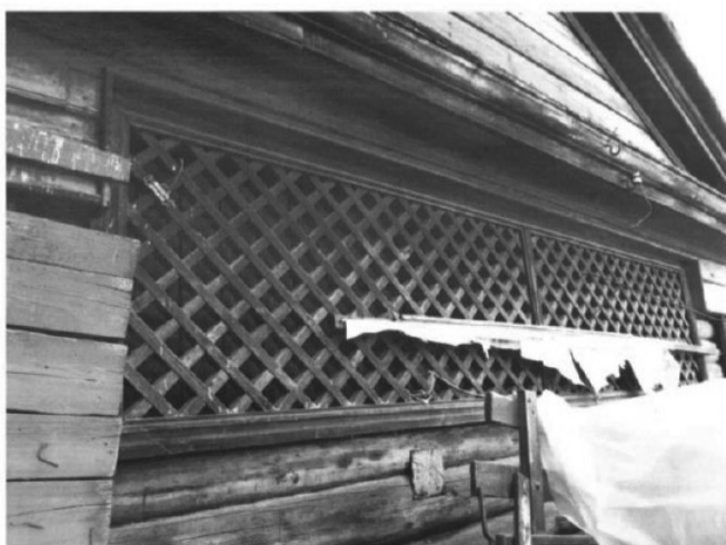
36.Фрагмент северо-западного фасада. Проем с заполнениями из диагонально скрещенных брусьев. Автор снимка: Кравченко В.И. Дата съемки: июнь 2017 г.
