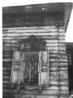
8. Фрагмент юго-западного фасада основного объема здания, со стороны двора с юга. Автор снимка: Кравченко В.И. Дата съемки: июнь 2017 г.
