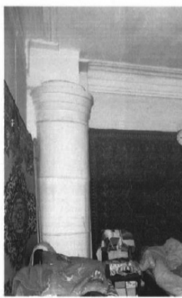
28. Утермарковская печь в основном объеме здания (кв.1, пом.2). Автор снимка: Кравченко В.И. Дата съемки: июнь 2017 г.
