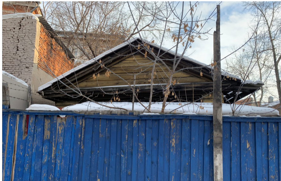
Общий вид на боковой (северо-западный) фасад амбара (лит. Б). Фрагмент главного (юго-западного) фасада амбара (лит. Б).
