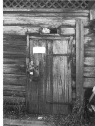
37.Фрагмент юго-западного фасада. Дверь. Автор снимка: Кравченко В.И. Дата съемки: июнь 2017 г.
