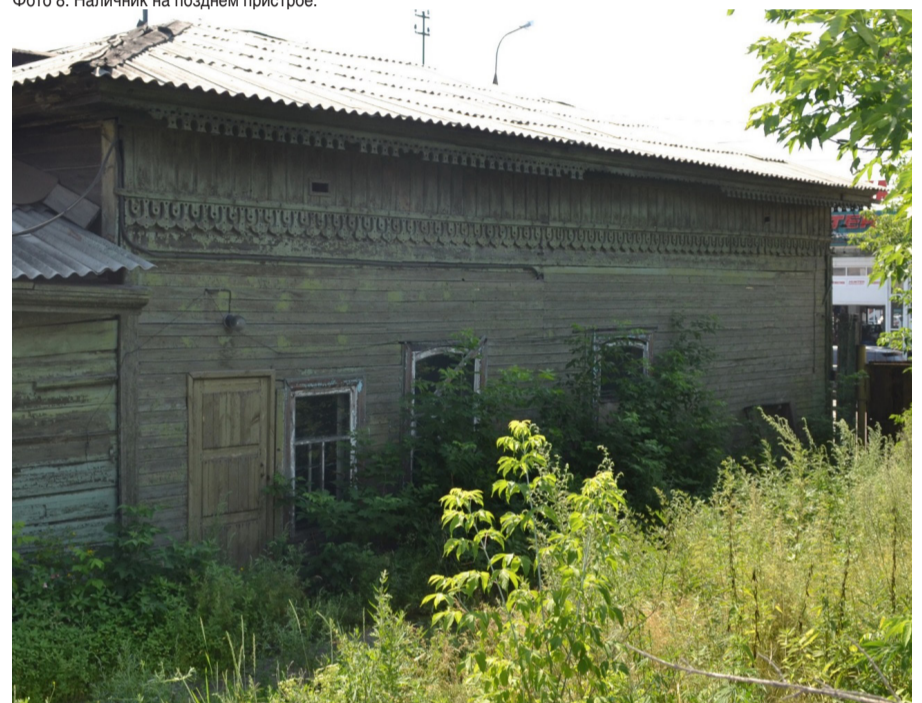
Фото 9. Левый боковой (северо-западный) фасад.
