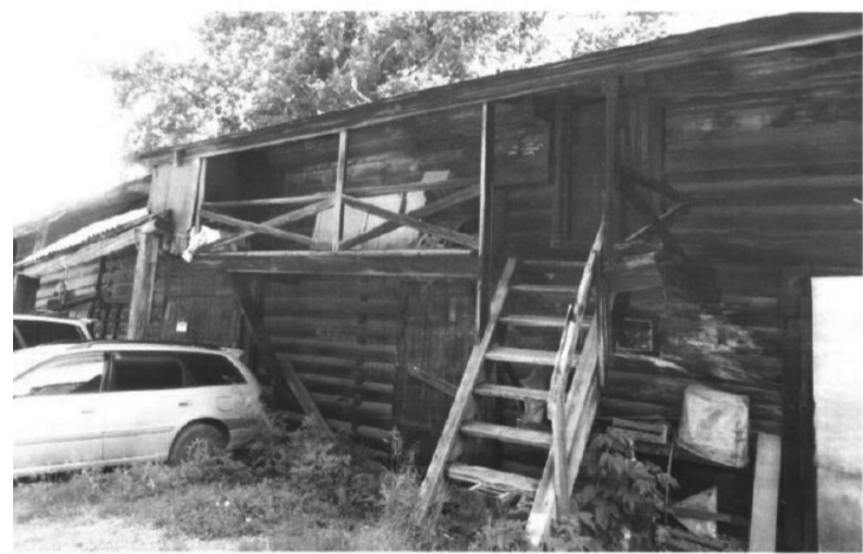
40.Фрагмент юго-западного фасада. Ограждение галерей с лестницами. Автор снимка: Кравченко В.И. Дата съемки: июнь 2017 г.
