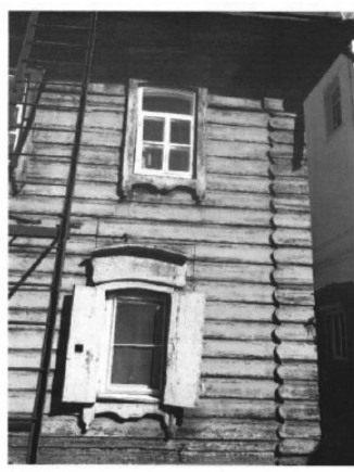
15. Фрагмент юго-восточного фасада дворового объема здания. Окно. Автор снимка: Кравченко В.И. Дата съемки: июнь 2017 г.
