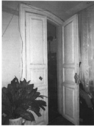
30. Филеичатые двери с латунными ручками. Автор снимка: Кравченко В.И. Дата съемки: июнь 2017 г.
