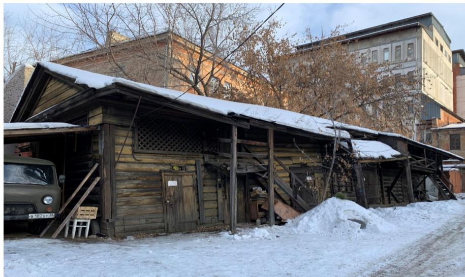
Общий вид на главный (юго-западный) фасад амбара (лит. Б).
