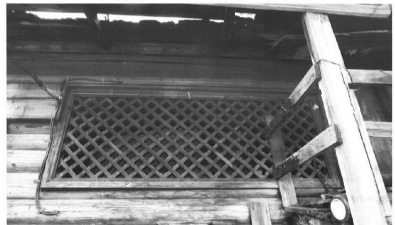
39.Фрагмент юго-западного фасада. Проем с заполнениями из диагонально скрещенных брусьев. Автор снимка: Кравченко В.И. Дата съемки: июнь 2017 г.
