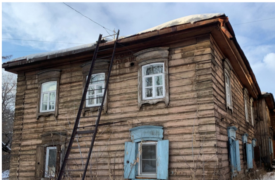
Общий вид с востока на дворовый (юго-восточный) и боковой (северо-восточный) фасады жилого дома (лит. А).
