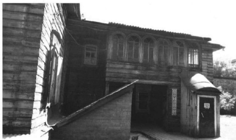
6. Вид на юго-западный фасад дворового объема здания со стороны двора с запада. Автор снимка: Кравченко В.И. Дата съемки: июнь 2017 г.
