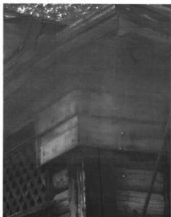
43. Фриз, карниз амбара. Автор снимка: Кравченко В.И. Дата съемки: июнь 2017 г.
