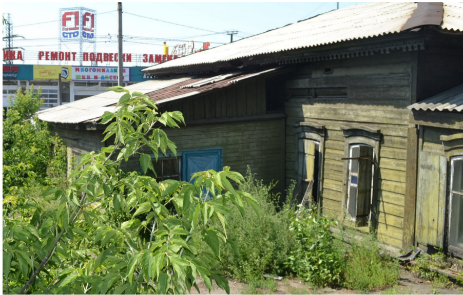
Фото 6. Правый боковой (юго-восточный) фасад.
