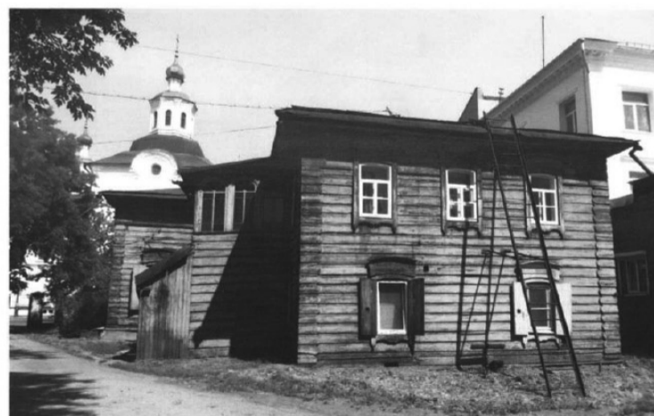
11. Вид на юго-восточный фасад дворового объема здания со стороны двора с юга-востока. Автор снимка: Кравченко В.И. Дата съемки: июнь 2017 г.
