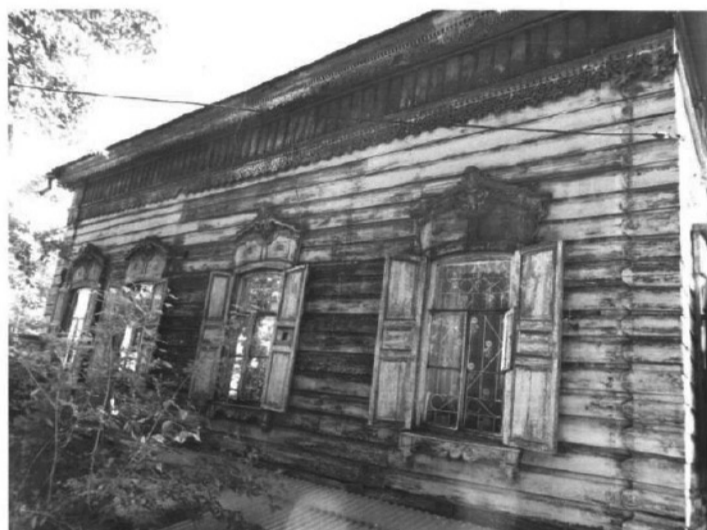
5. Вид на юго-западный фасад основного объема здания со стороны двора. Автор снимка: Кравченко В.И. Дата съемки: июнь 2017 г.
