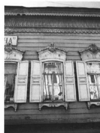
3. Фрагмент северо-западного фасада здания. Окно, фриз, карниз. Автор снимка: Кравченко В.И. Дата съемки: июнь 2017 г.
