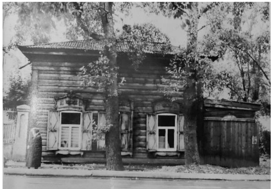
Фото 1. Пер. Черемховский, 4, лит. А. Главный (северо-восточный) фасад. Фото 1992 г.
