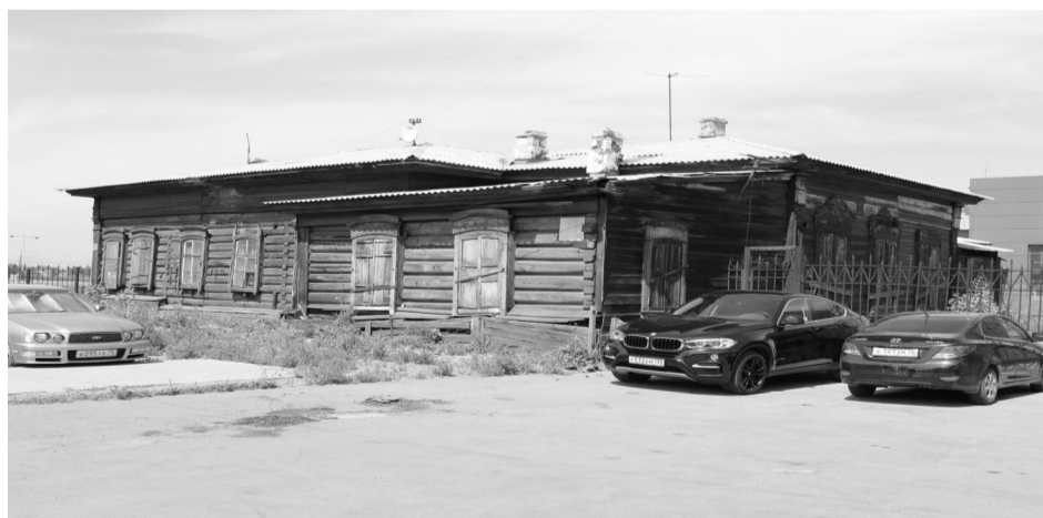
Фото 1 – Общий вид с улицы Франк-Каменецкого. Продольный юго-западный фасад
