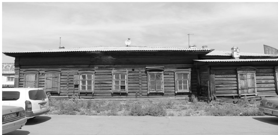
Фото 2 – Продольный юго-западный фасад
