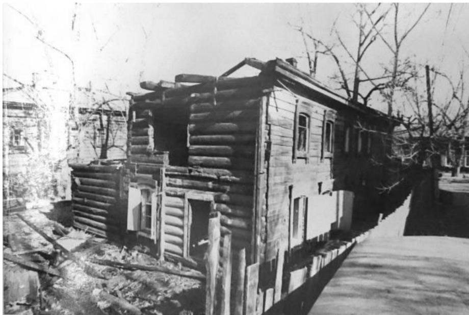
Фото 13. Пер. Черемховский, 4, лит. А. Общий вид с юга. 1993 г.
