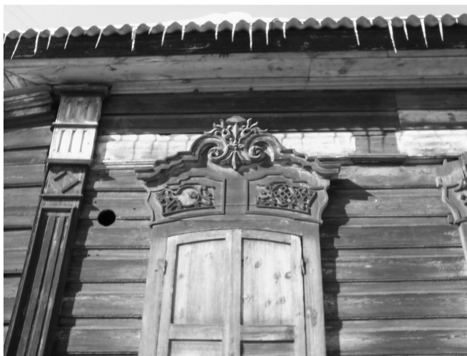
Фото 5 – Фрагмент юго-восточного фасада
