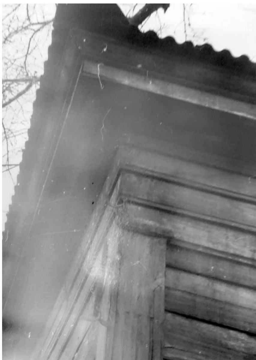
Фото 24. Пер. Черемховский, 4, лит. А. Фриз, карниз и верх лопатки основного объёма. Фото 1993 г.
