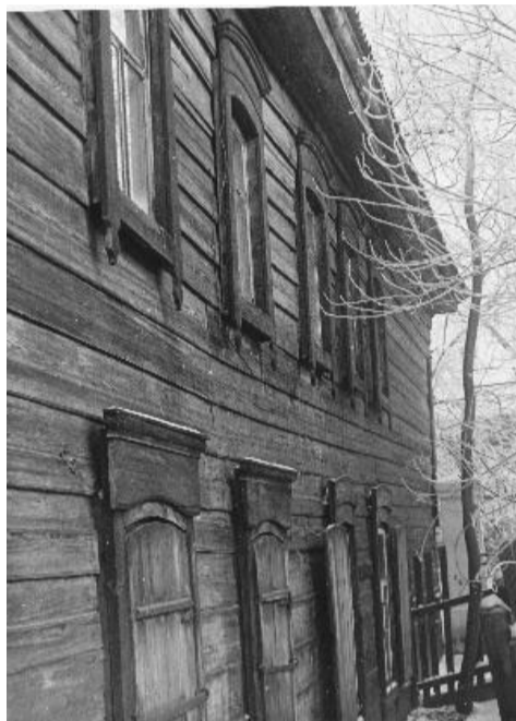
Фото 8. Пер. Черемховский, 4, лит. А. Фрагмент юго-восточного фасада. Фото Б. Михайлова, 1983 г.
