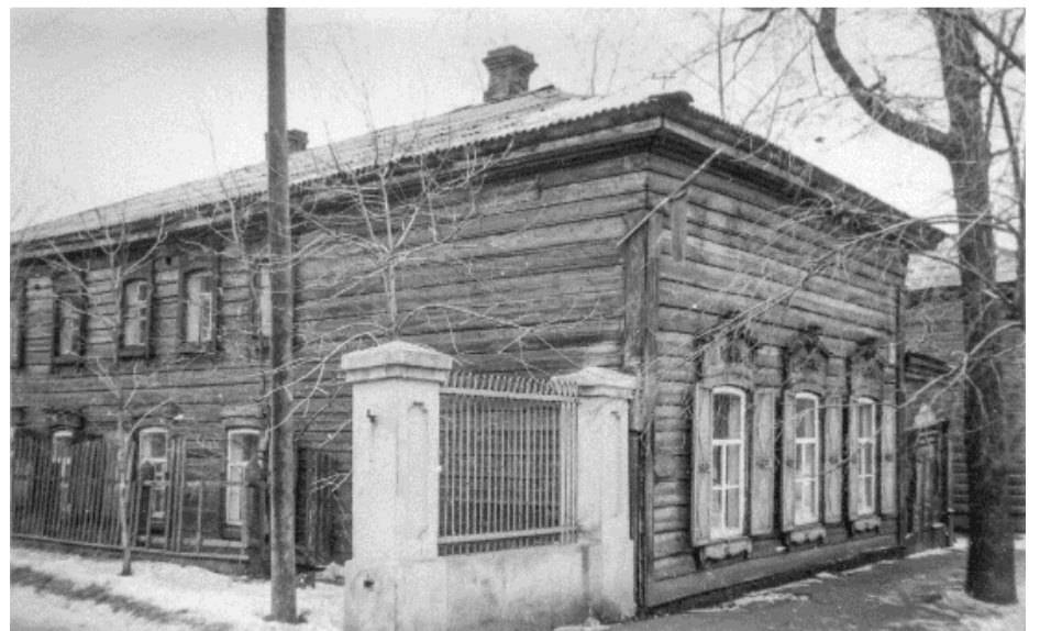
Фото 2. Пер. Черемховский, 4, лит. А. Общий вид с востока.
