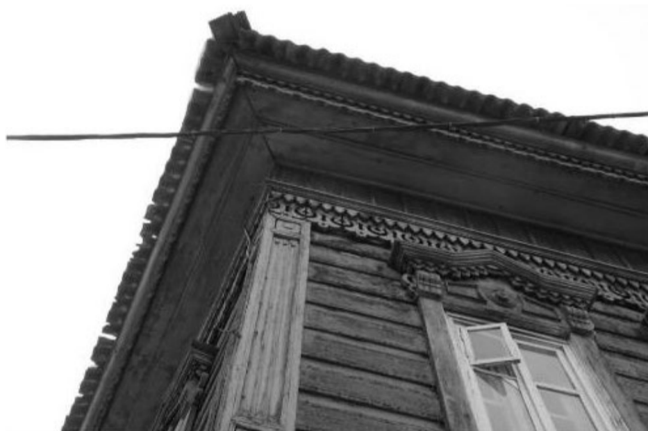
Фото 10 – Антаблемент: фронт и карниз главного фасада. Фрагмент углового оконного проема.
