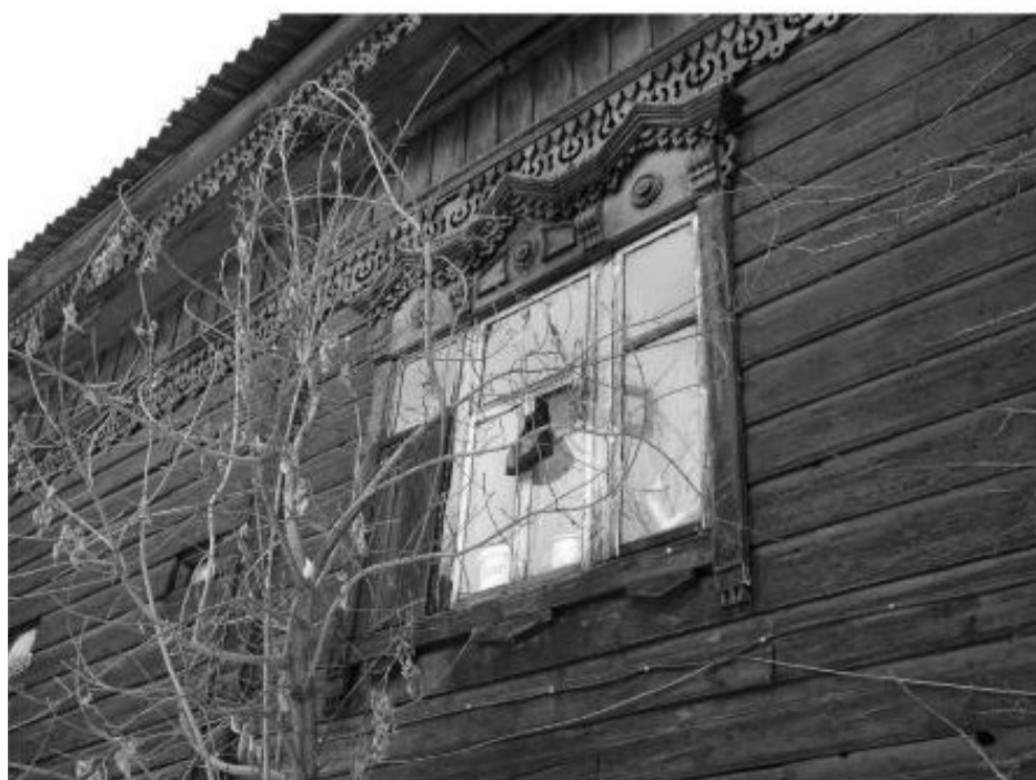
Фото 11 – Тройной оконный проем бокового фасада
