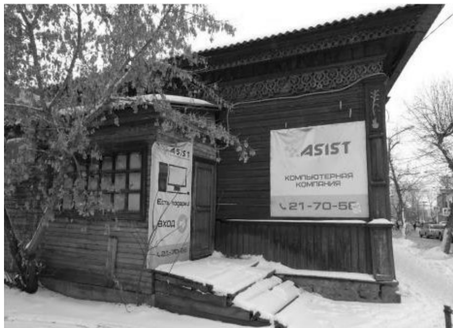
Фото 15 – Фрагмент бокового, юго-западного фасада
