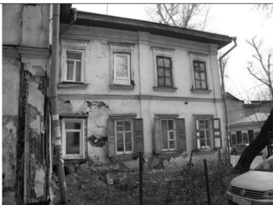
Фото 3 – Боковой юго-западный фасад
