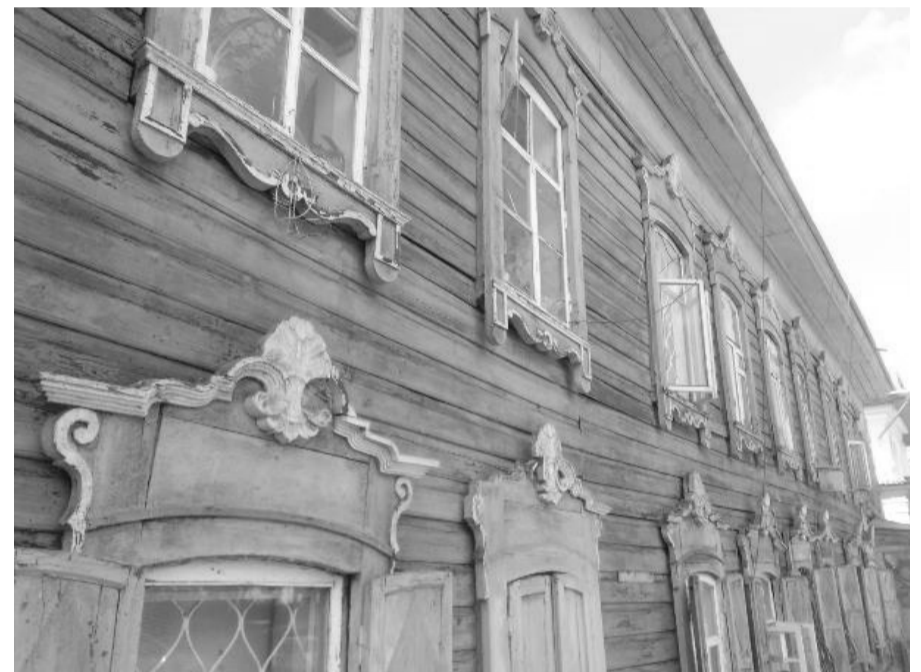
Фото 3 – Фрагмент юго-восточного фасада
