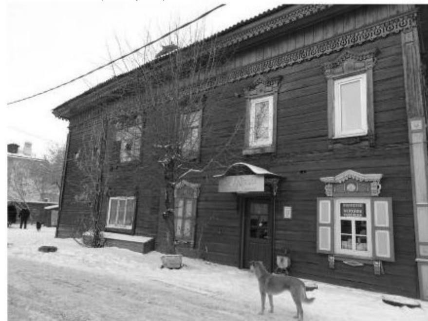
Фото 3 – Боковой юго-западный фасад
