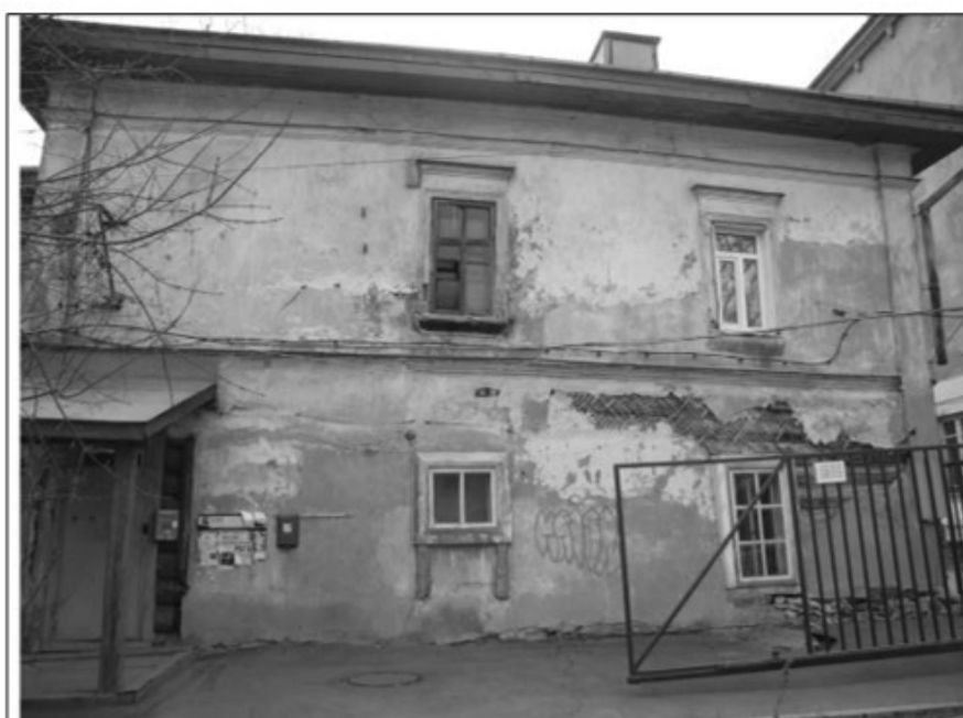
Фото 5 – Северо-западный фасад пристроя
