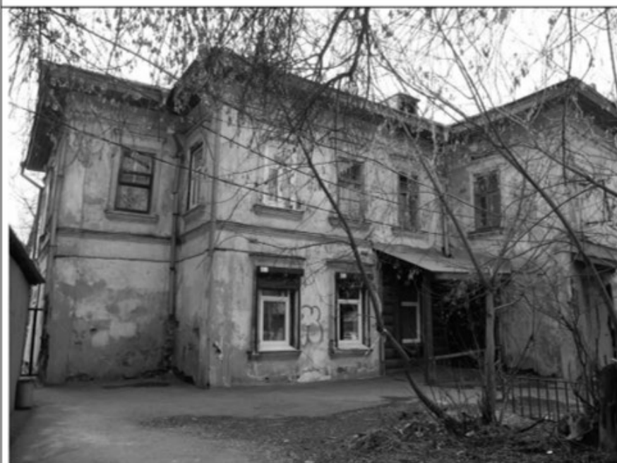
Фото 8 – Вид со двора с юга
