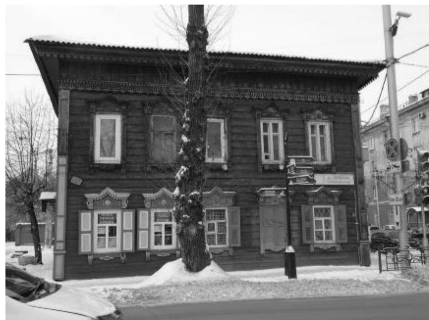
Фото 2 – Юго-восточный фасад по ул. Свердлова
