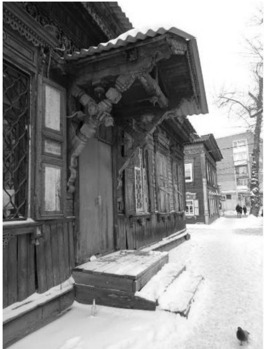
Фото 23 – Крыльцо парадного входа
