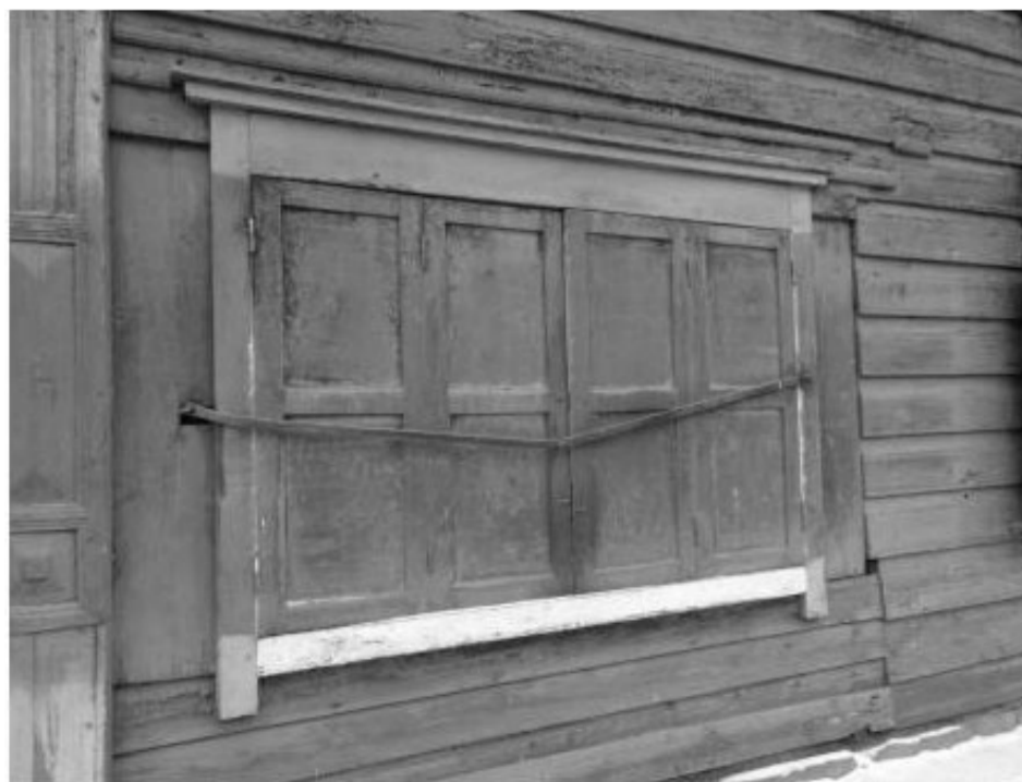
Фото 6 – Тройной оконный проем III этажа главного фасада.
