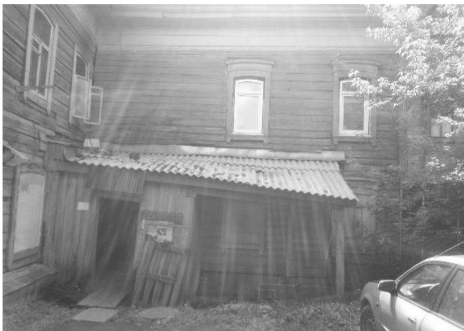
Фото 6 – Дворовой северо-восточный фасад
