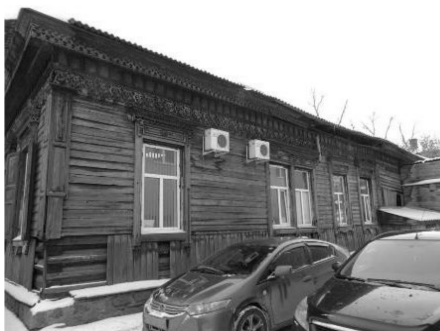
Фото 18 – Фрагмент дворового фасада
