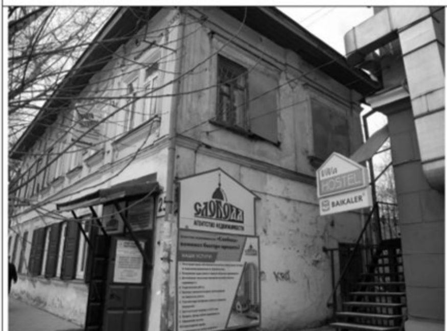
Фото 2 – Боковой северо-восточный фасад
