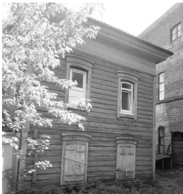
Фото 8 – Торцевой северо-западный фасад
