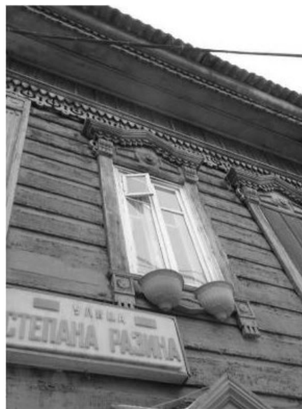
Фото 7, 8 – Рядовые оконные 2 этажа главного фасада
