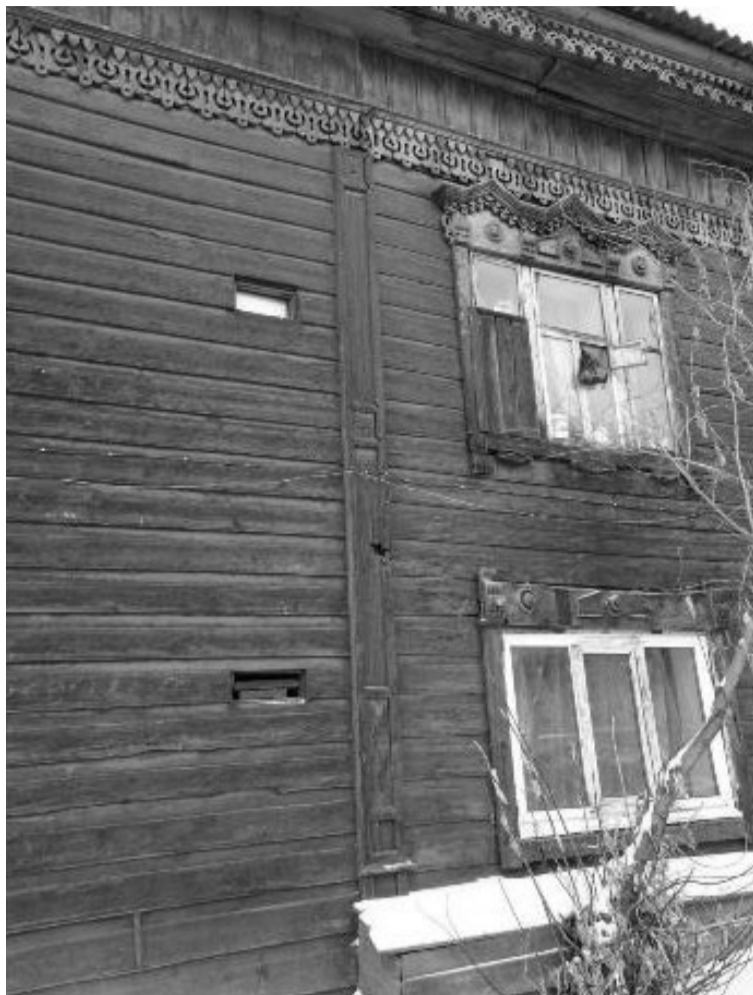
Фото 12 – Пилястра бокового фасада
