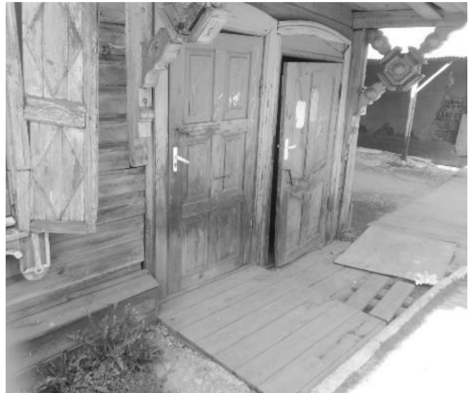
Фото 2 – Фрагмент главного юго-восточного фасада
