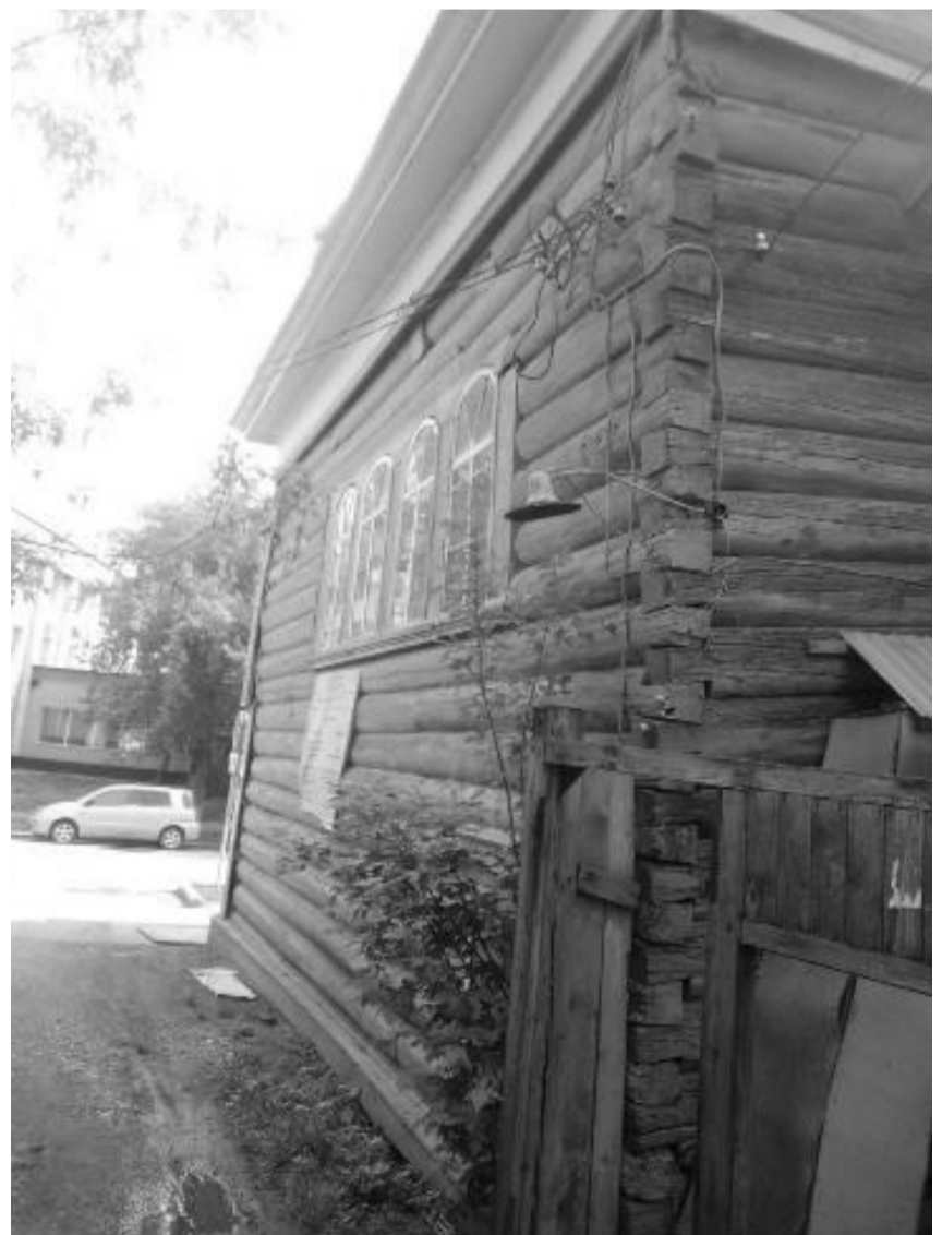
Фото 4 – Торцевой северо-восточный фасад
