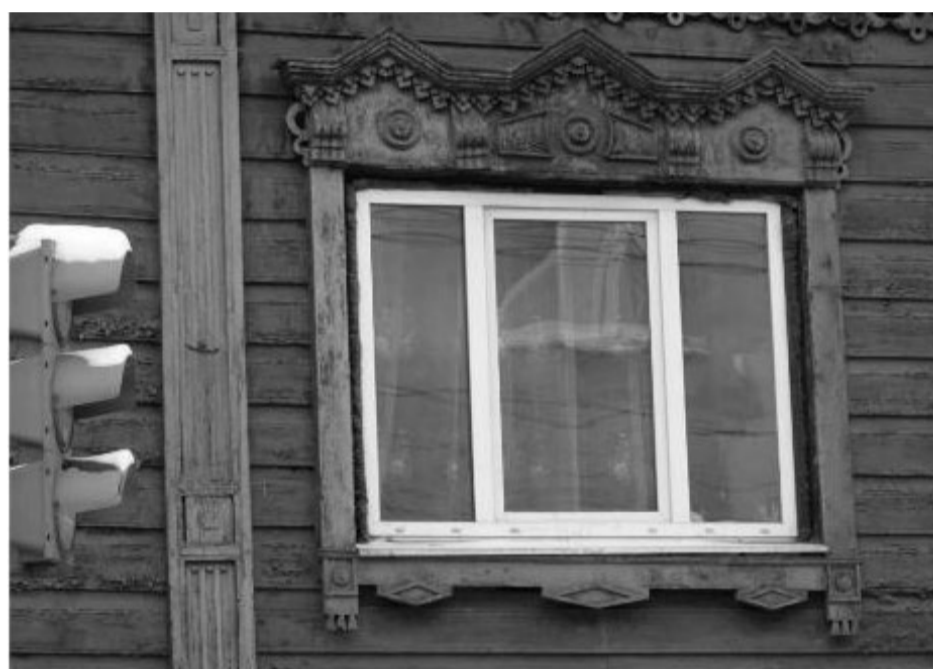
Фото 9 – Тройной оконный проем 2 этажа главного фасада.
