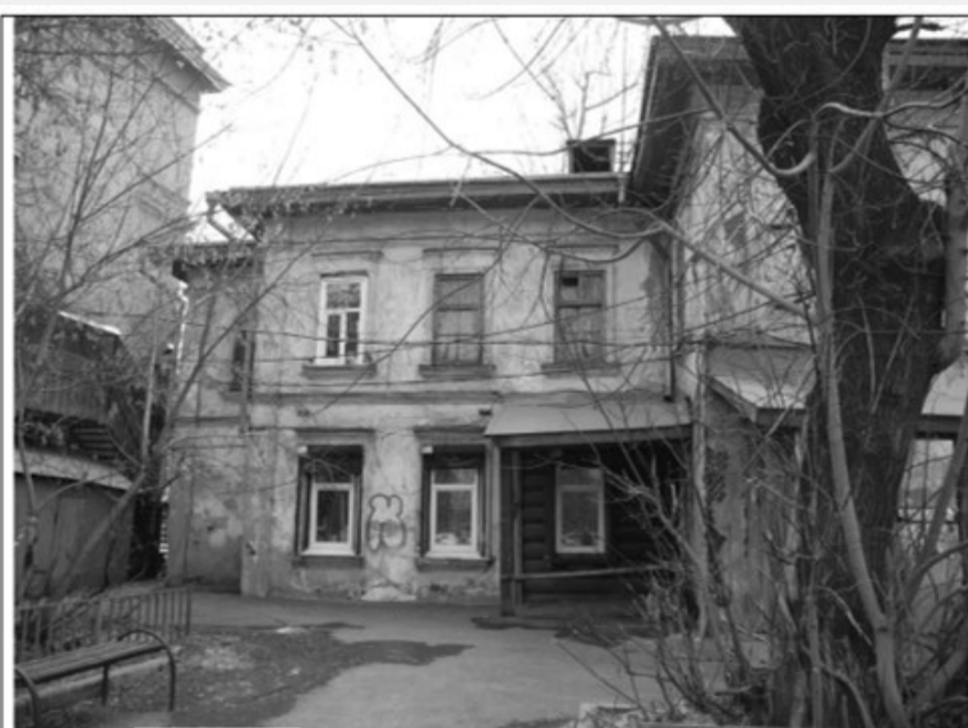
Фото 7 – Северо-западный фасад основного объема
