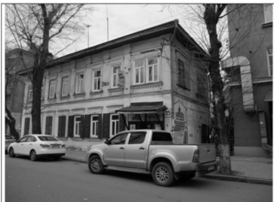
Фото 1 – Общий вид с востока
