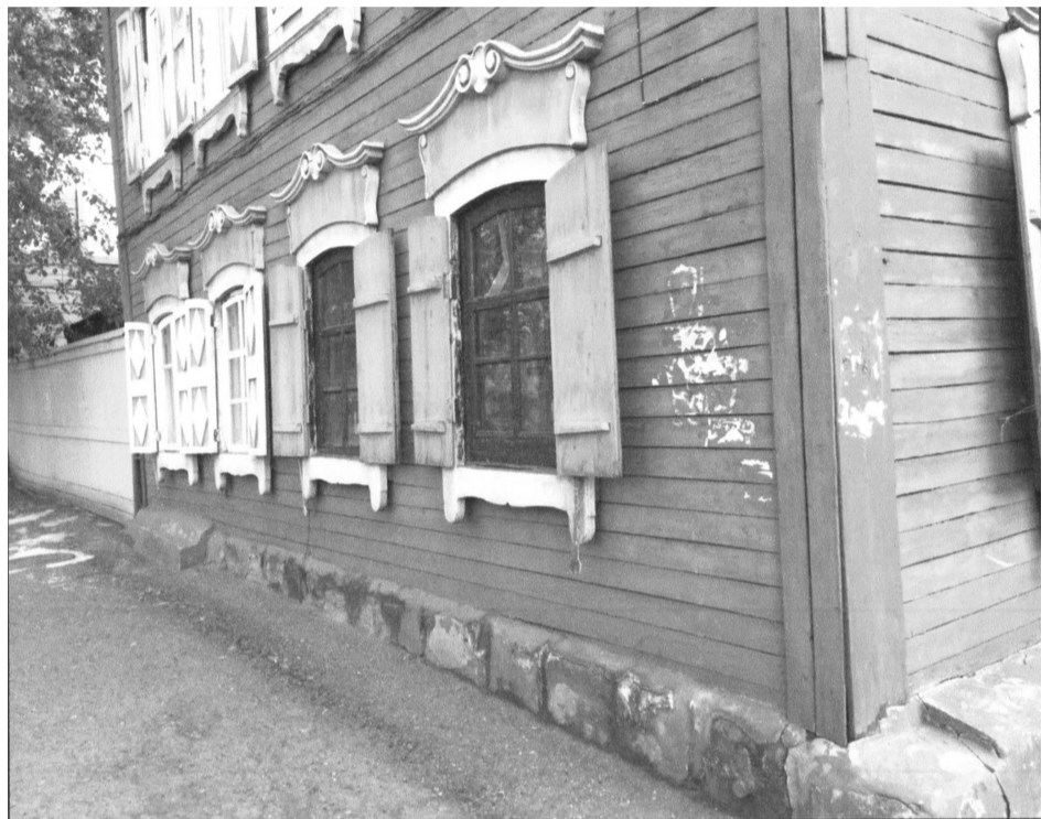
Фото 2 – Фрагмент северо-восточного фасада
