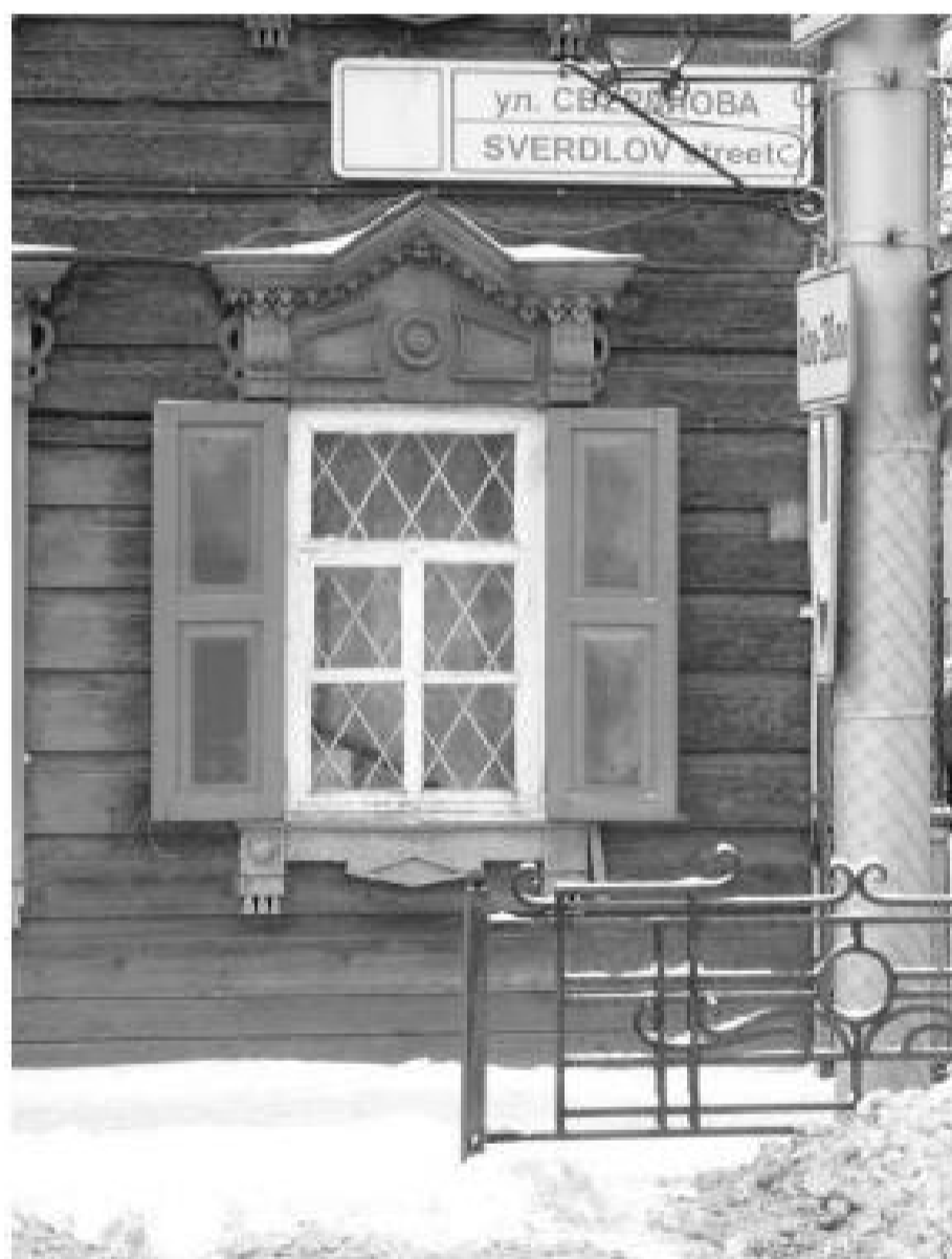
Фото 5 – Рядовой оконный проем I этажа главного фасада.
