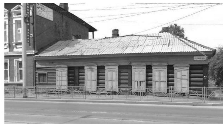
Фото 6 – Главный фасад дома с лавкой
