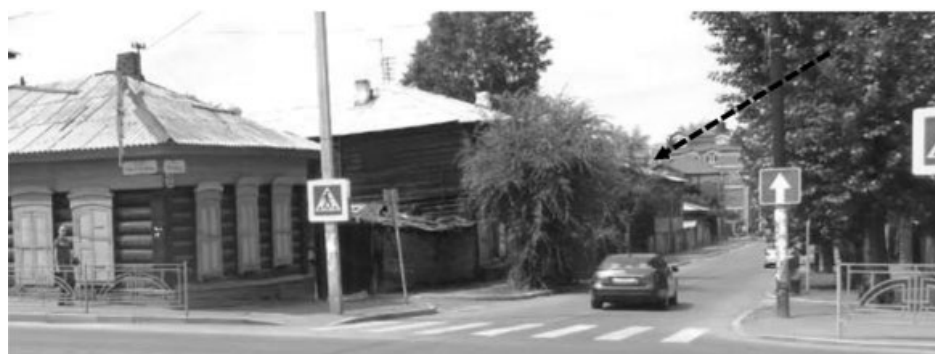
Фото 9 – Вид на ОКН с перекрестка с улицей Тимирязева
