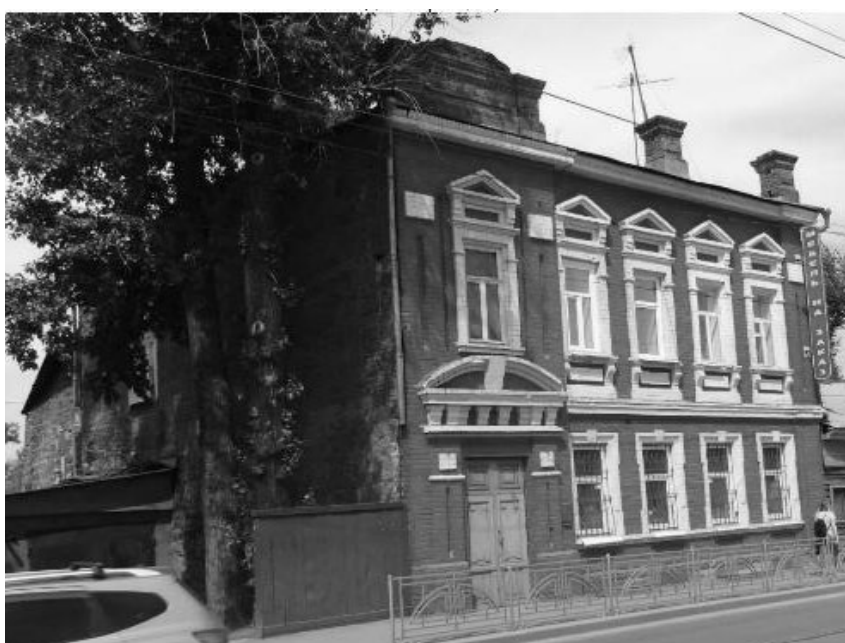
Фото 9 – Вид на элемент в составе усадьбы «Доходный дом» с юга. Главный юго-восточный, и боковой юго-западный фасады
