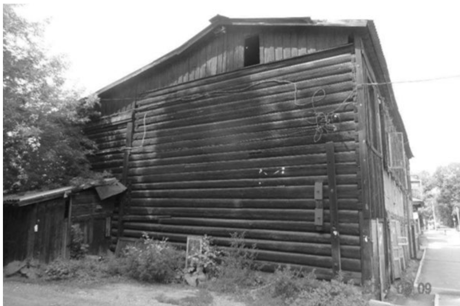
Фото 10 – Боковой юго-восточный фасад
