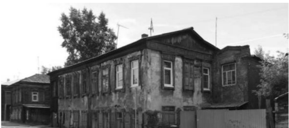
Фото 2 – Общий вид ОКН с севера
