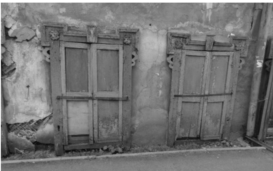
Фото 4 – Наличники оконного проема 1 этажа
