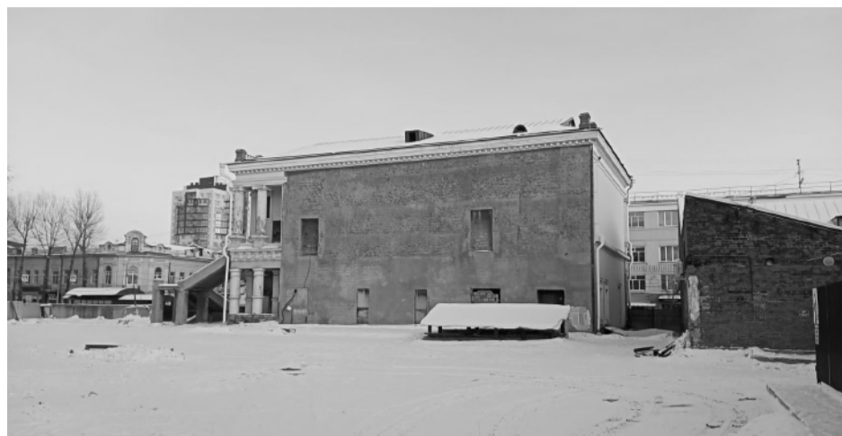
Фото 13. Общий вид здания с северо-запада. Фото 2003 г.
