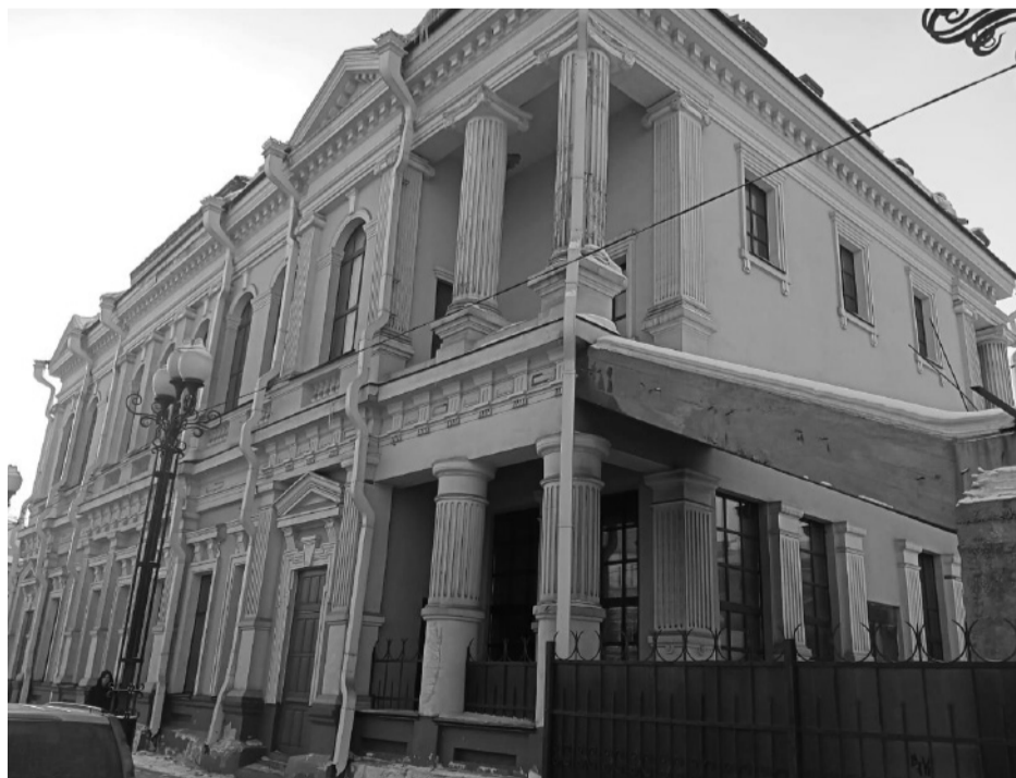
Фото 8. Восточный угол здания. Фото 2023 г.
