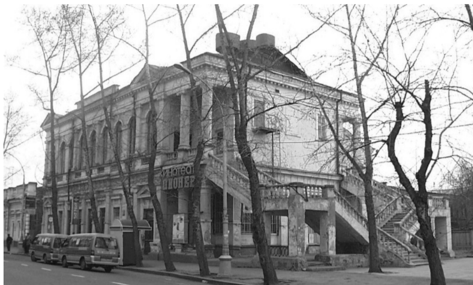
Фото 6. Общий вид здания с востока. Фото 2003 г.
