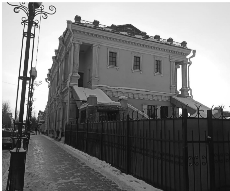
Фото 7. Общий вид здания с востока. Фото 2023 г.
