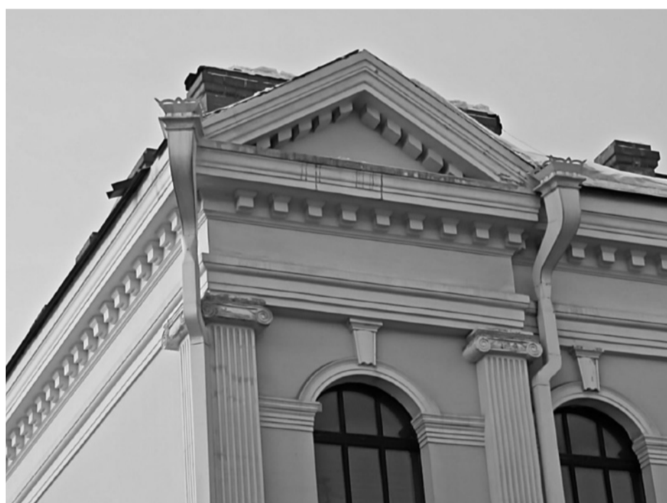
Фото 15. Фрагмент главного юго-восточного фасада. Вернувшийся антаблемент. Фронтон разлита. Аттиковые стенки. Фото 2023 г.
