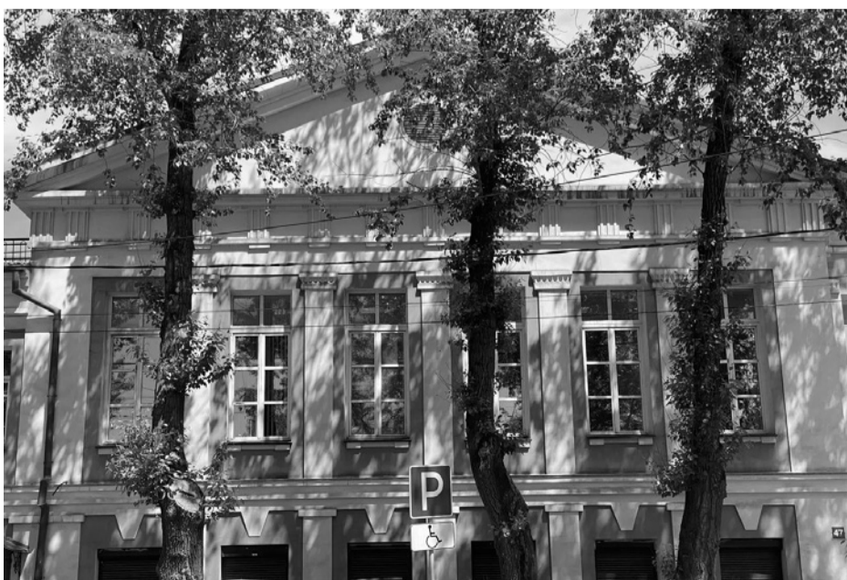
Фотография № 2. Вид фрагмент фасада объекта культурного наследия
