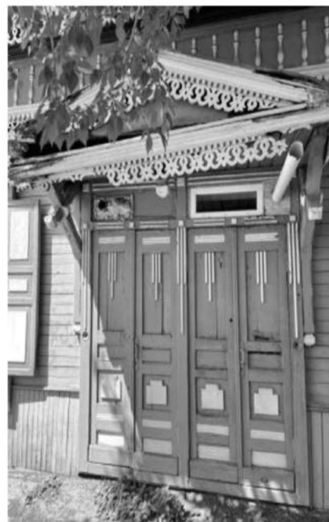
Фотография № 4. Вид на фрагмент фасада объекта культурного наследия
