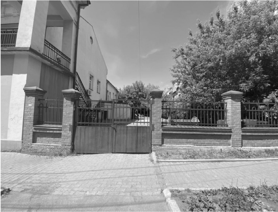
Фотография № 6. Вид фрагмент фасада объекта культурного наследия
