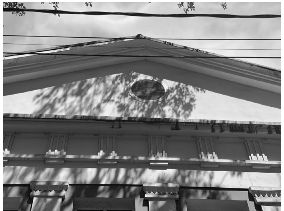
Фотография № 4. Вид фрагмент фасада объекта культурного наследия
