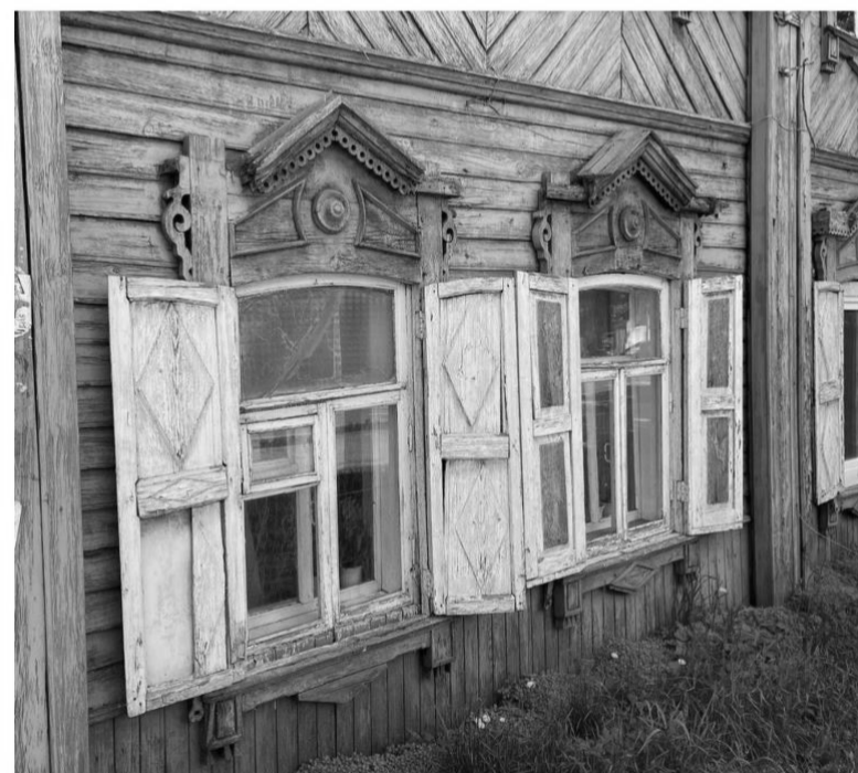
Фотография № 4. Вид на фрагмент фасада объекта культурного наследия
