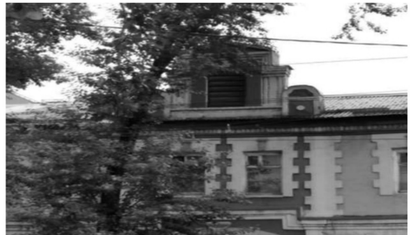
Фотография № 7. Вид на фрагмент фасада объекта культурного наследия
