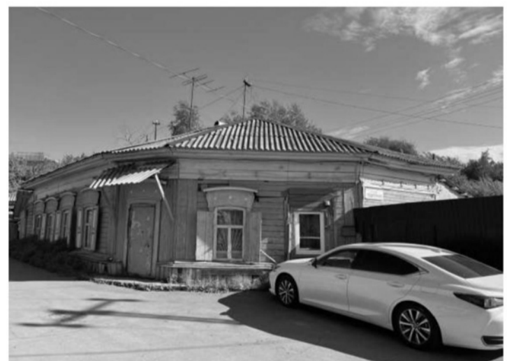
Фотография № 1. Вид с перекрестка улиц Байкальской и Подгорной на объект культурного наследия
