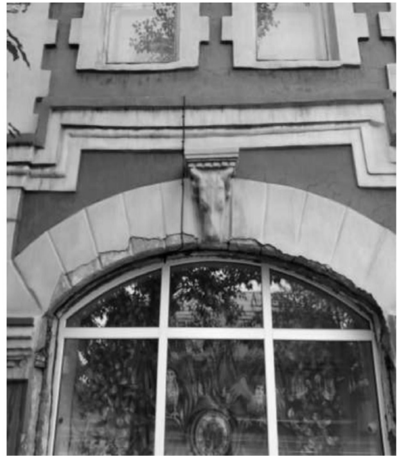
Фотография № 6. Вид на фрагмент фасада объекта культурного наследия
