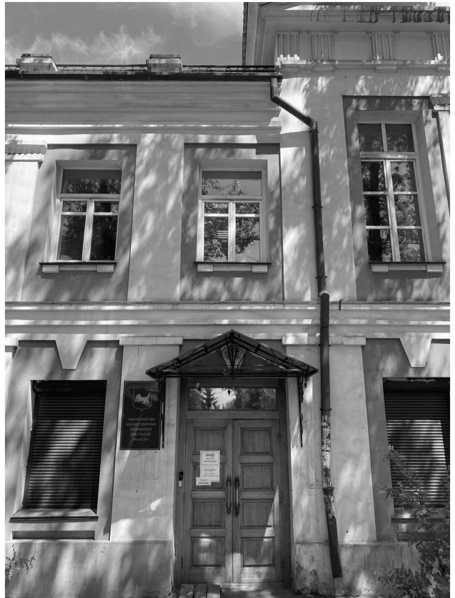
Фотография № 3. Вид фрагмент фасада объекта культурного наследия
