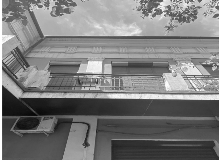
Фотография № 7. Вид фрагмент фасада объекта культурного наследия
