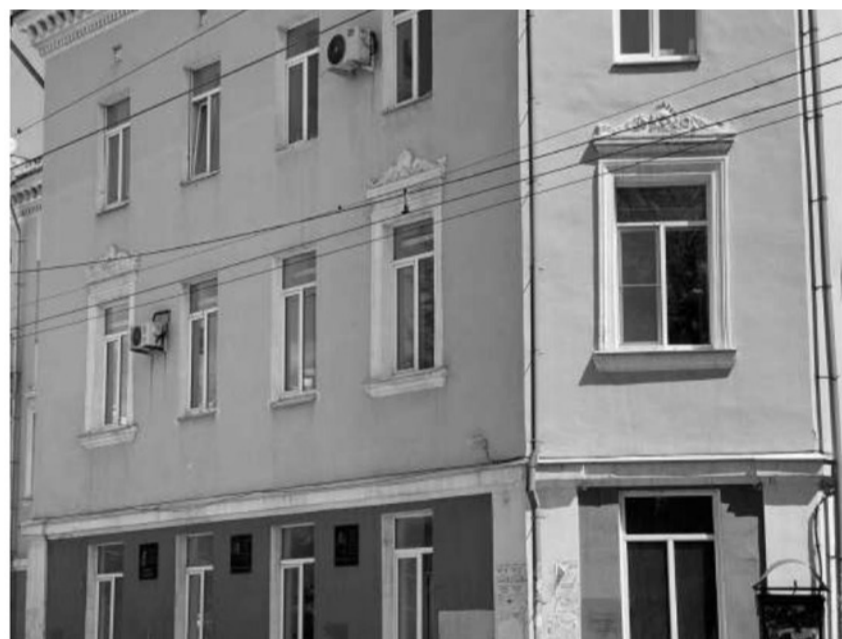
Фотография № 5. Вид на фрагмент фасада объекта культурного наследия
