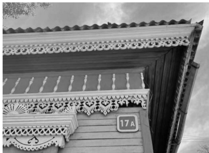
Фотография № 2. Вид на фрагмент фасада объекта культурного наследия
