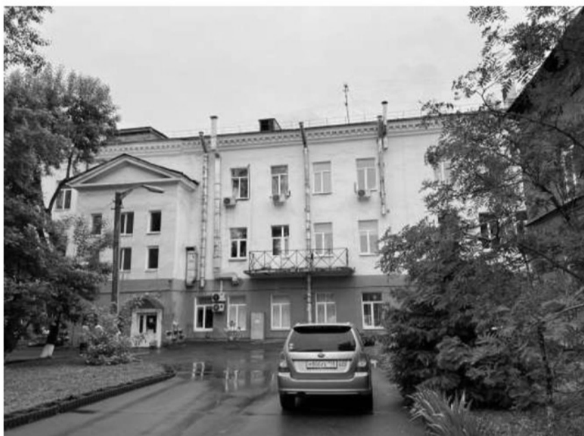
Фотография № 4. Вид на фрагмент фасада объекта культурного наследия
