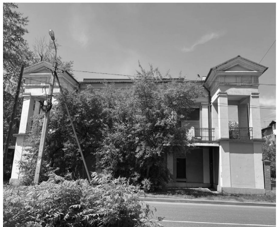
Фотография № 5. Вид фрагмент фасада объекта культурного наследия
