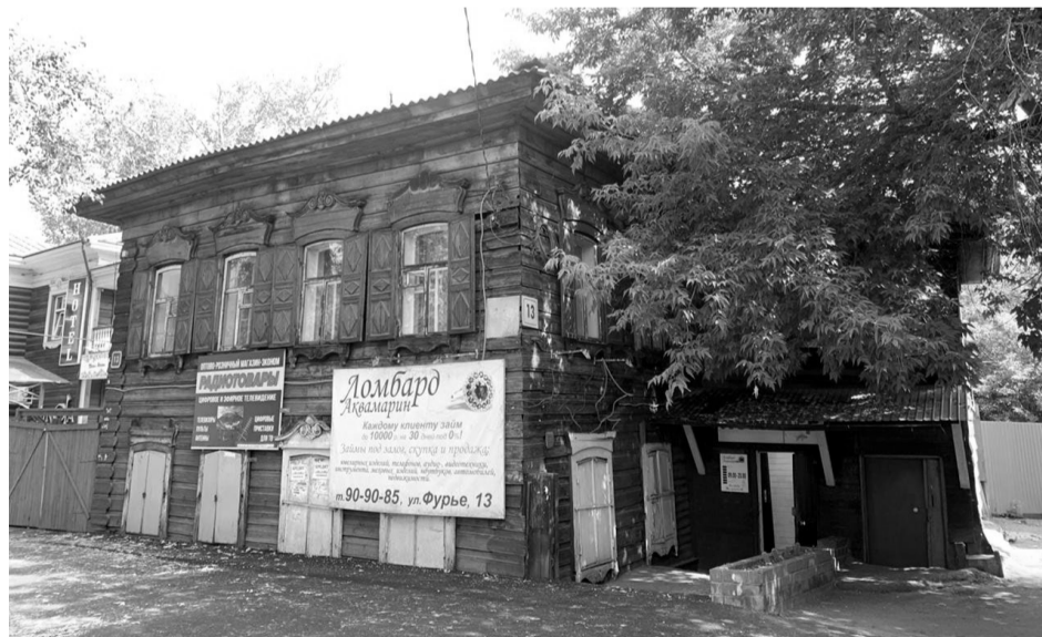
Фото 1. Главный юго-западный фасад дома по улице Фурье
