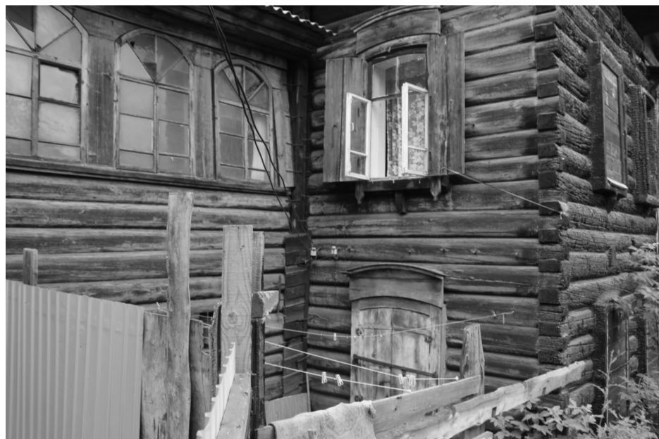
Фото 4. Фрагмент северо-восточного фасада
