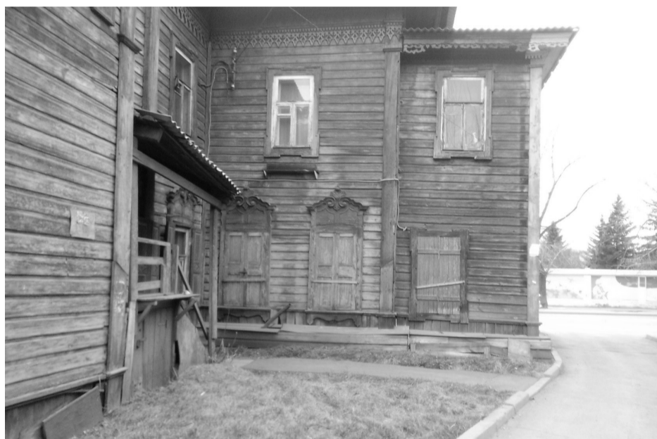
Фото 4. Северо-восточный фасад доходного дома (лит. а)
