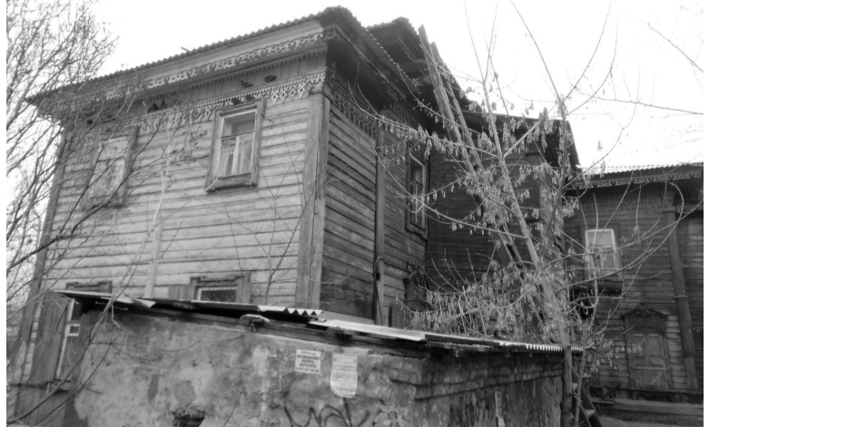
Фото 6. Юго-восточный фасад доходного дома (лит. а)
