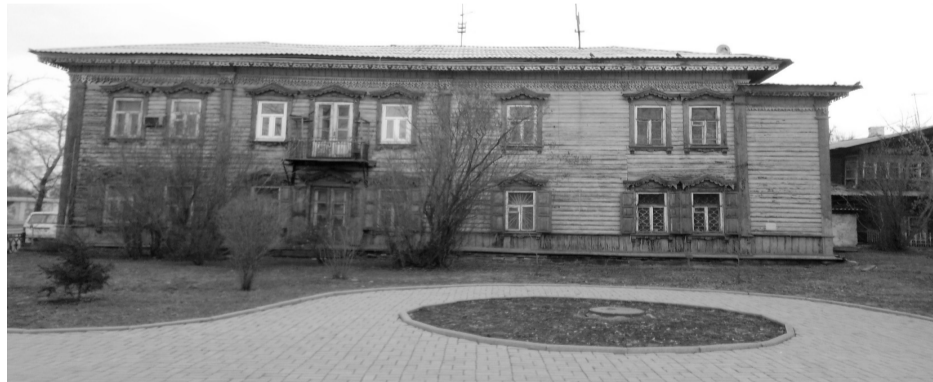
Фото 5. Фрагмент северо-восточного фасада доходного дома (лит. а)
