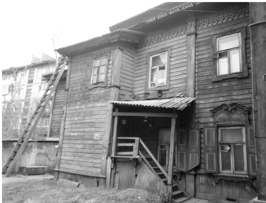
Фото 3. Фрагмент главного фасада доходного дома (лит. а) по ул. Сурикова
