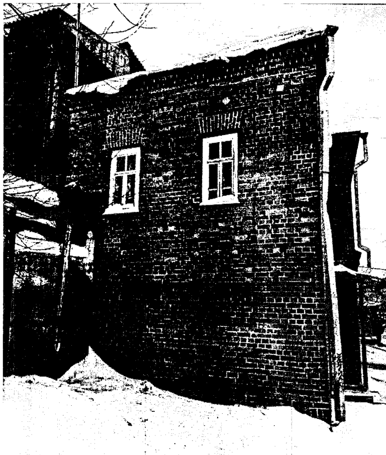
Фото 3 – Дворовой (восточный) фасад входного пристроя
