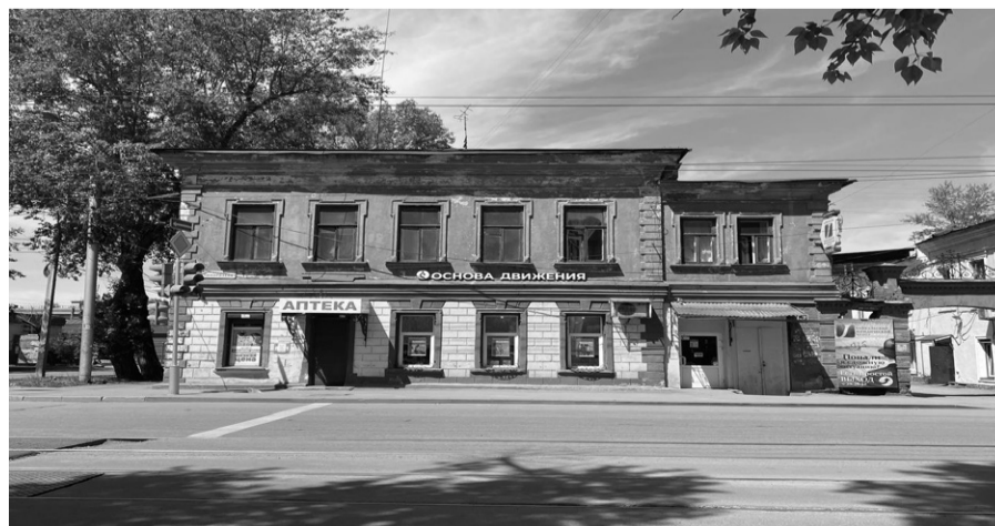
Фотография №1. Вид с улицы Тимирязева на объект культурного наследия
