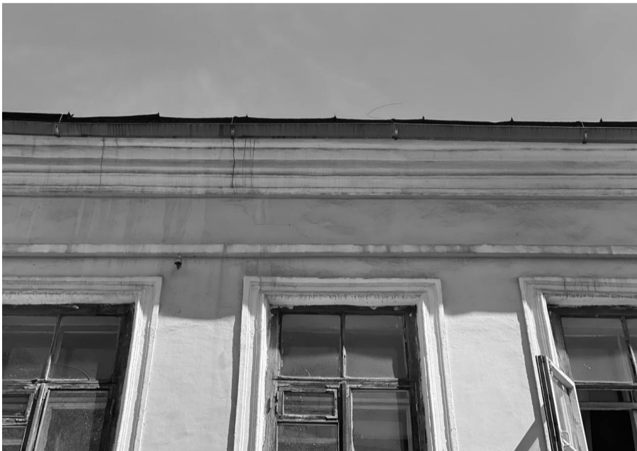
Фотография № 4. Вид на фрагмент фасада объекта культурного наследия
