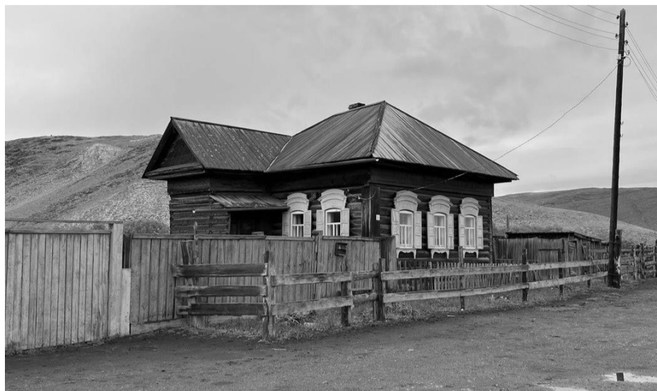
Фотография № 1. Вид с ул. Солнечная на юго-восточный и юго-западный фасады объекта культурного наследия
