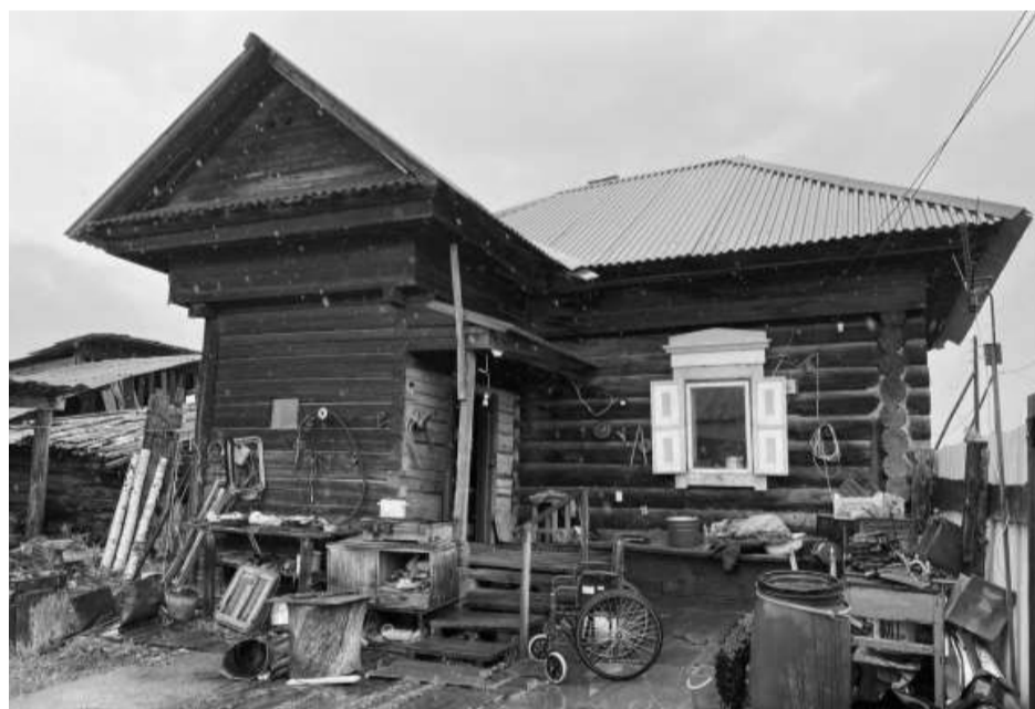
Фотография № 3. Вид на юго-западный фасад объекта культурного наследия
