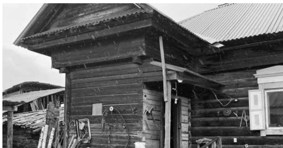
Фотография № 4. Фрагмент юго-западного фасада объекта культурного наследия
