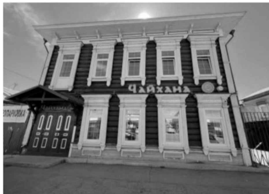
Фотография № 1. Вид на объект культурного наследия «Доходный дом» с улицы С. Перовской
