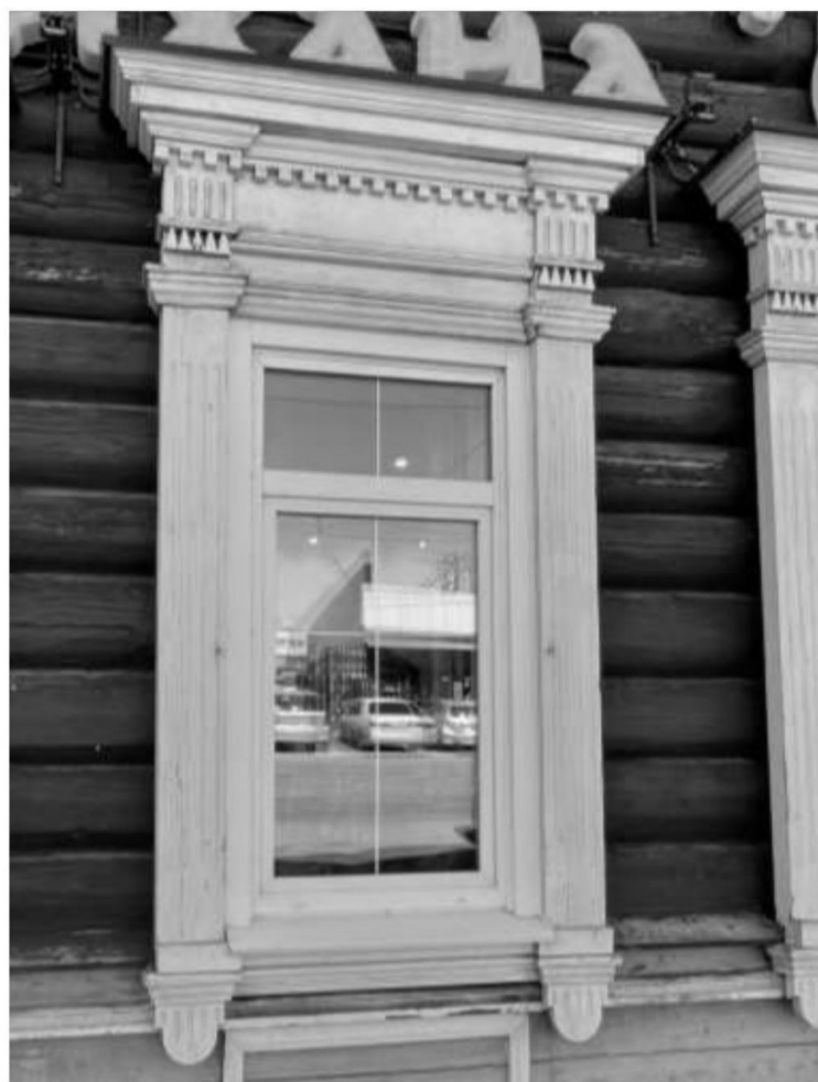
Фотография № 4. Вид на фрагмент фасада объекта культурного наследия
