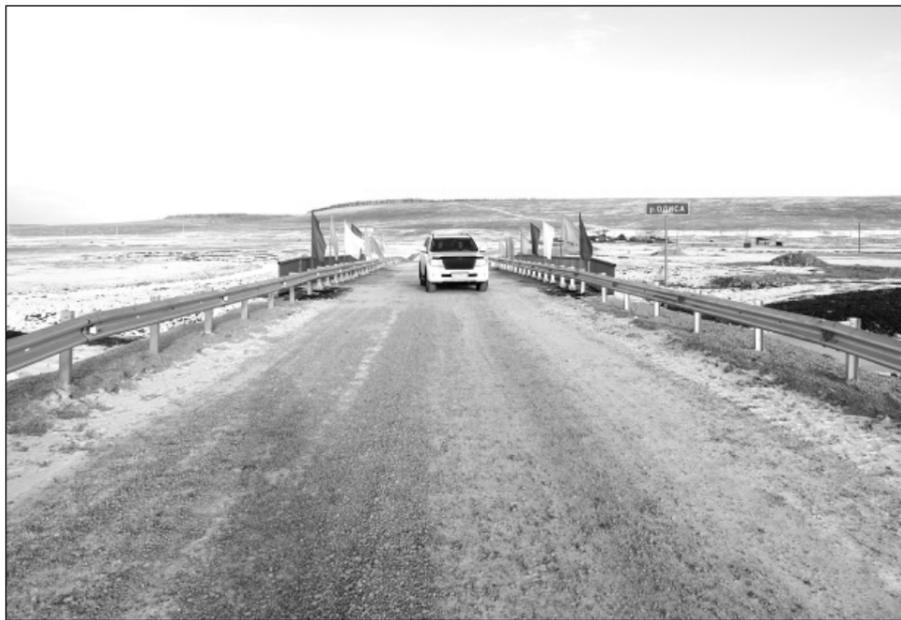
вым покрытием, а подъездные пути в гравийном исполнении. Откосы укреплены щебнем. Вообще раньше на этом месте находилась труба, а сверху нее – деревянная переправа. Весной труба забивалась шугой и не пропускала воду, из-за чего потом речка разливалась по долине. С новым мостом таких проблем уже не будет.
