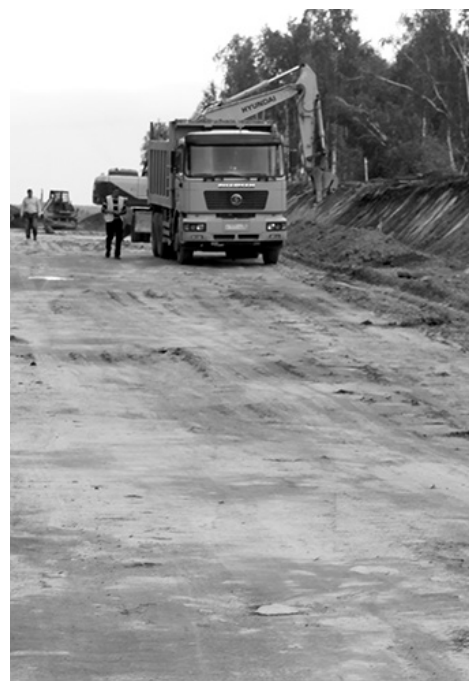
Строительство дороги в Аларском районе
