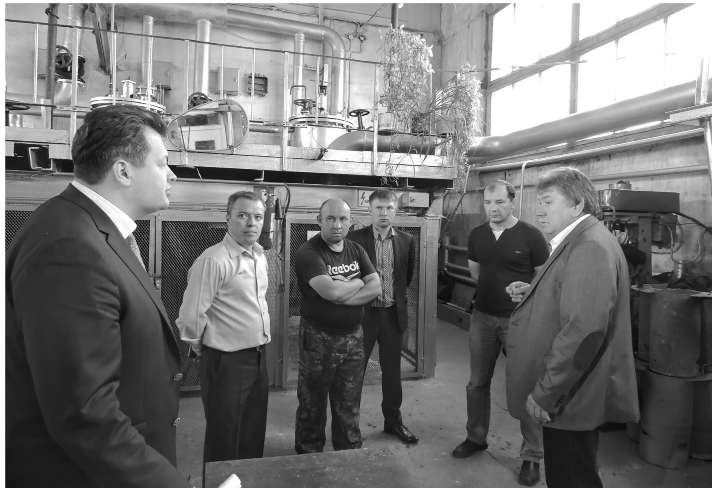
На неволонской котельной: слева мэр района А. Дубас, сотрудники котельной и неволонской администрации
