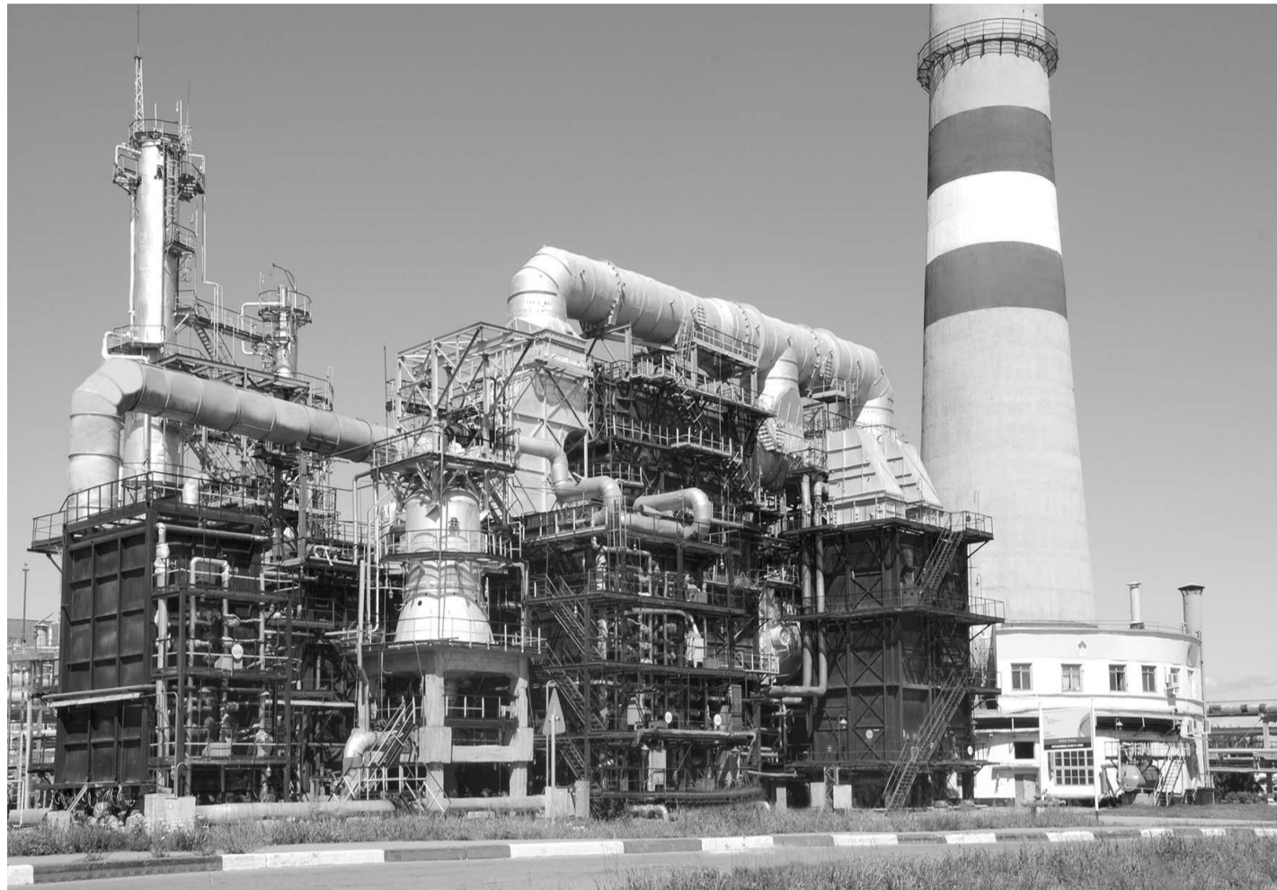
Установка каталитического риформинга вырабатывает основной компонент автомобильного бензина
