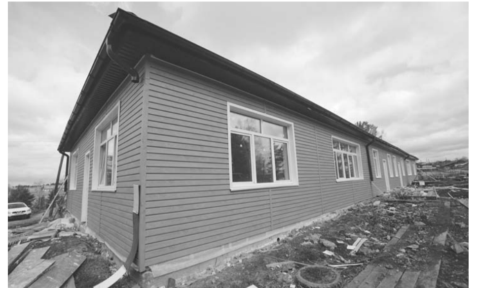
Строительство детского сада
