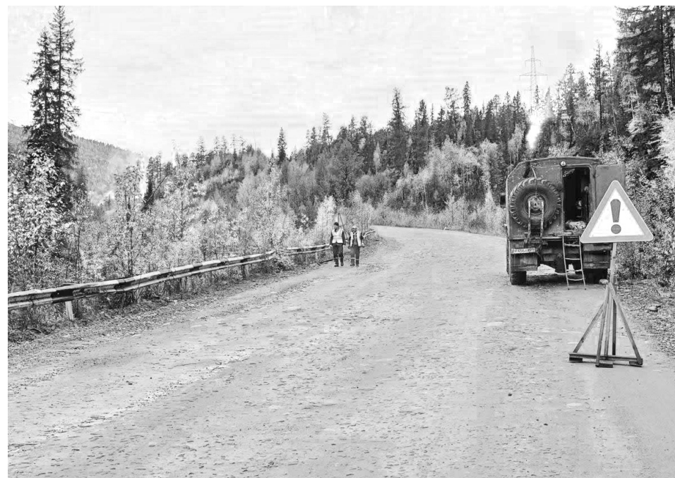
С 12 сентября на самых проблемных участках автодороги от Бодайбо до поселка Кропоткин начала работать дорожно-строительная техника
